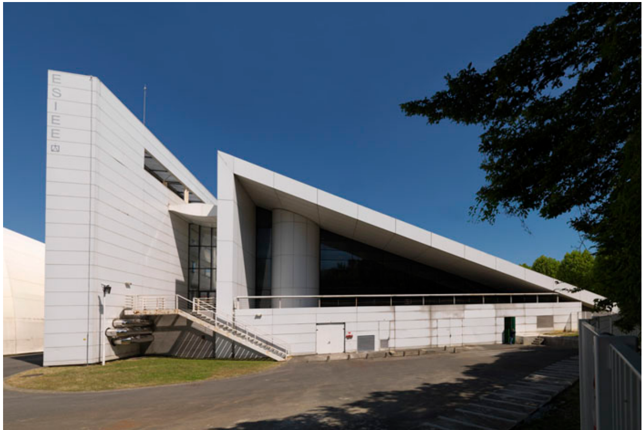
Vue du côté sud.
