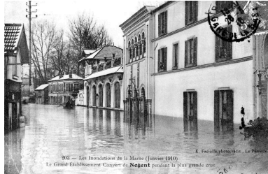
Face antérieure. Au centre: première salle de bad de style mauresque. Au fond: salle de bal ajoutée en 1908. Carte postale, 1910. (AD Val-de-Marne) IVR11_19859400229XB
