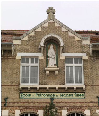
Détail du couronnement des deux travées centrales. Phot. Jean-Bernard Vialles IVR11_20099500632NUC4A
