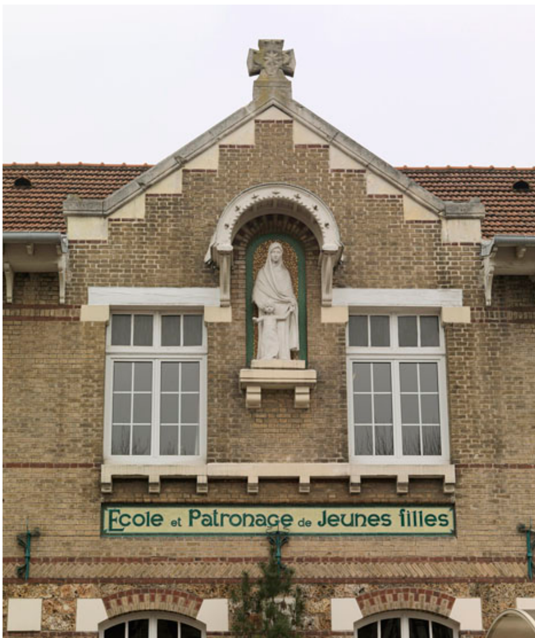
Détail du couronnement des deux travées centrales.
