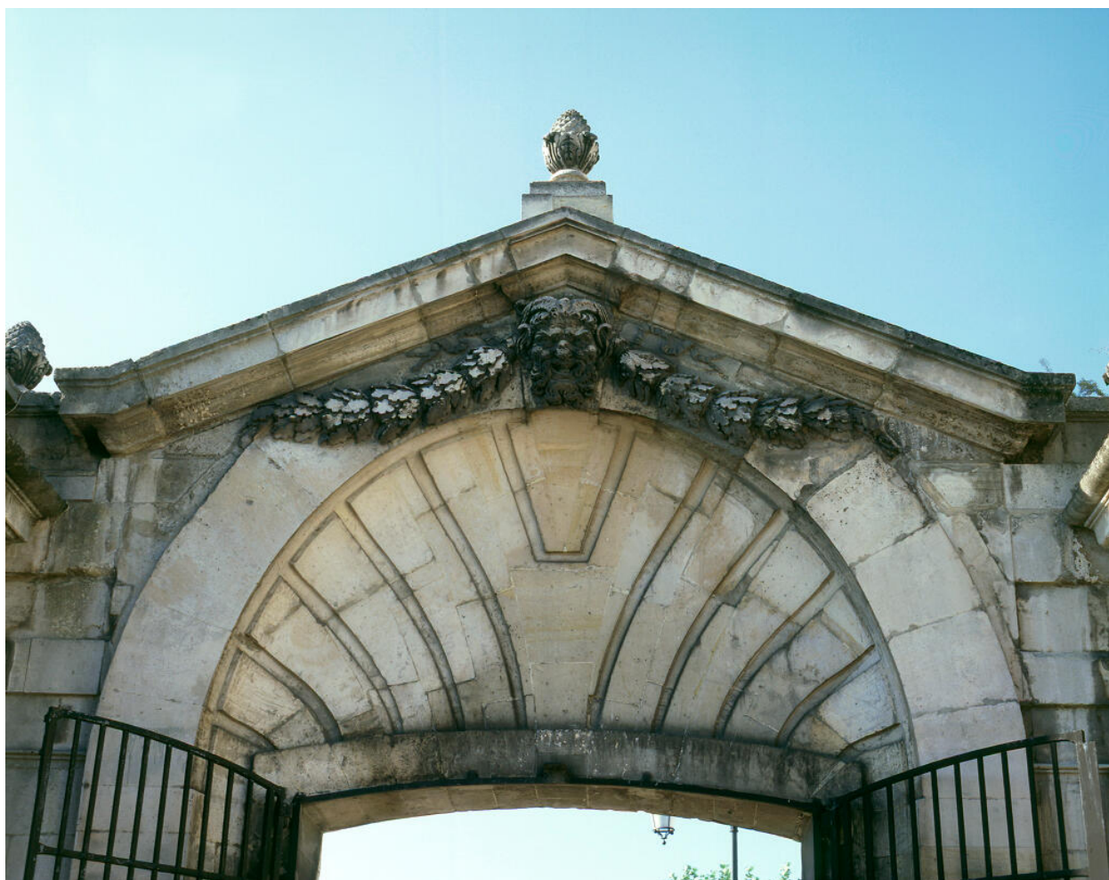
Détail de l'arrière voussoir de la porte.
