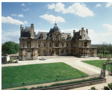
Vue générale, face antérieure. Phot. Vialles Jean-Bernard IVR11_19887800416XA
