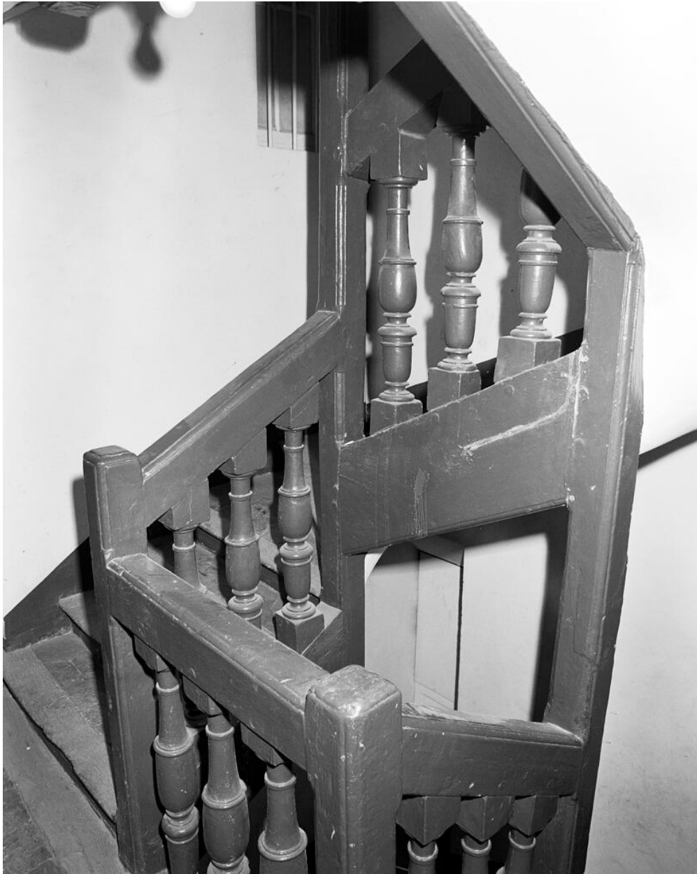
Entrée sud dite porte Pétrous. Pavillon, 56, avenue de Paris, vue de l'escalier à quatre noyaux.
