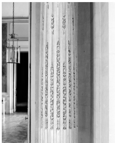
Vestibule d'entrée, détail d'une colonne. Phot. Vialles Jean-Bernard IVR11_19907800238X
