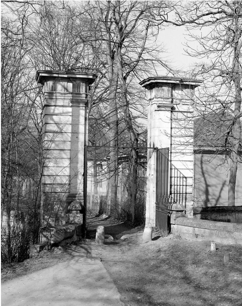
Entrée dite Entrée du Roy ou Caves du nord. Vue d'ensemble, prise côté parc, de la porte située à gauche de la cour circulaire.
