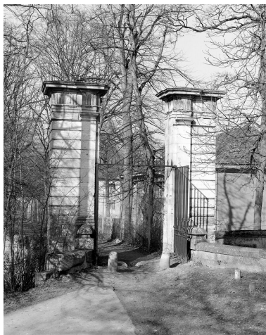
Entrée dite Entrée du Roy ou Caves du nord. Vue d'ensemble, prise côté parc, de la porte située à gauche de la cour circulaire. Phot. Vialles Jean-Bernard IVR11_19907800049X
