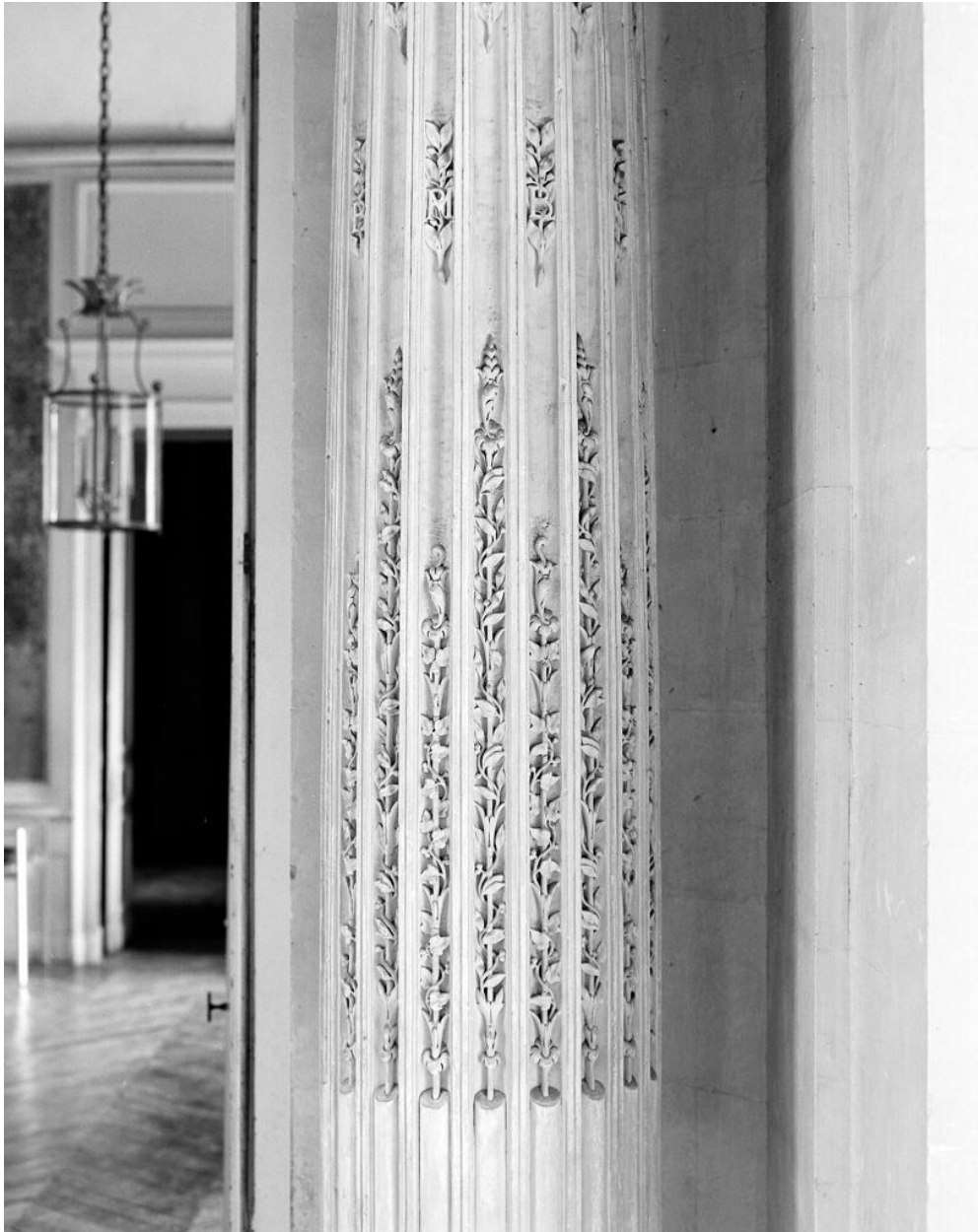
Vestibule d'entrée, détail d'une colonne.
