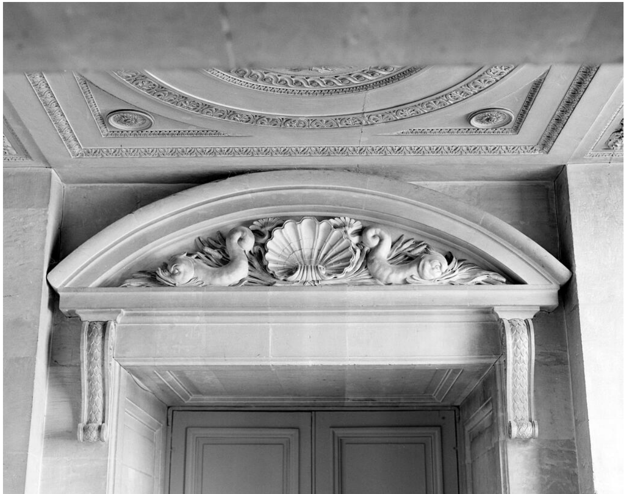
Entrée, vestibule droite, détail sculpté.
