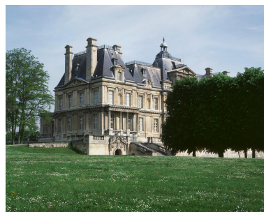
Vue d'ensemble du château depuis le sud. Phot. Vialles Jean-Bernard IVR11_19997800480XA
