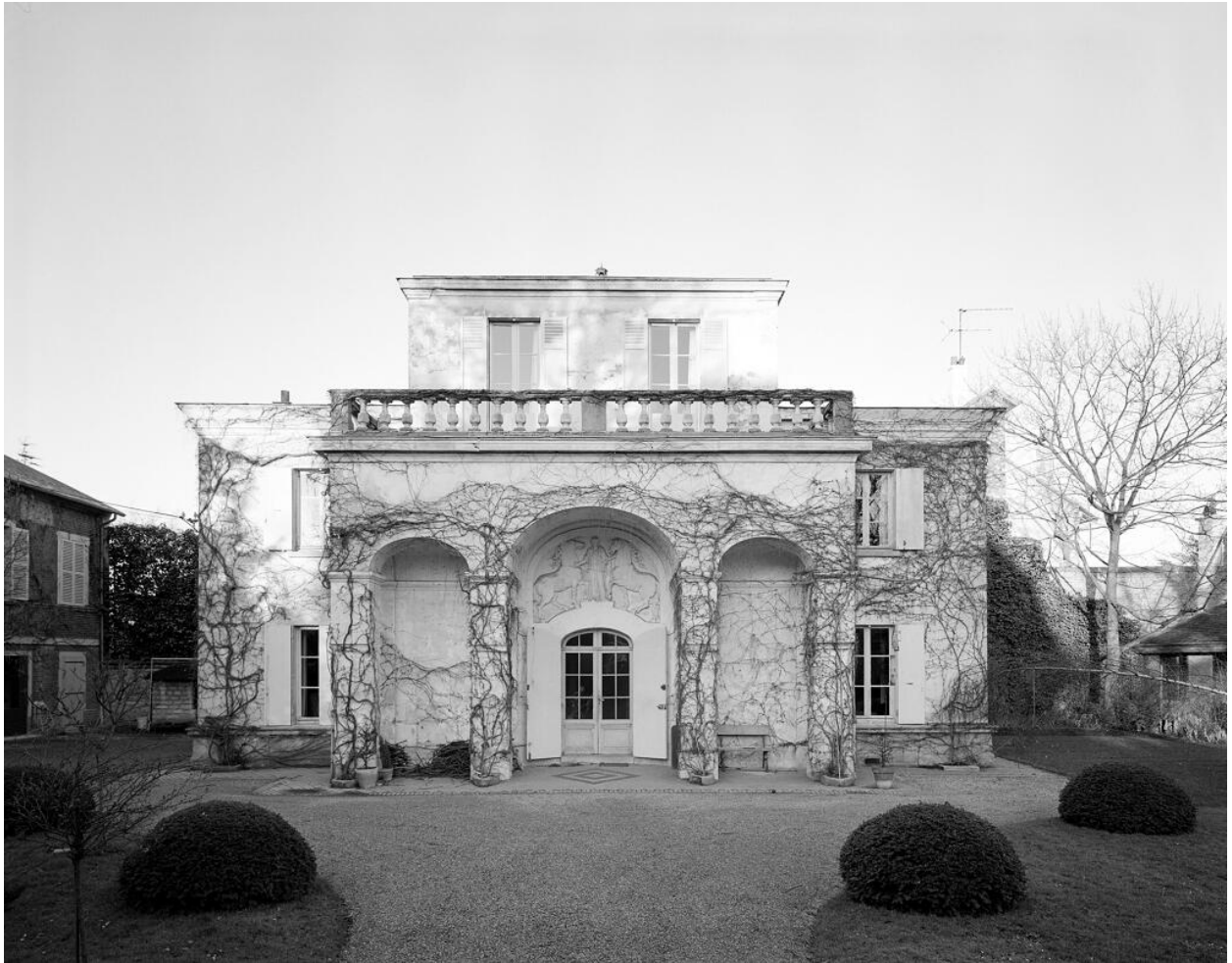
Ecuries. Façade antérieure de la maison construite autour de l'abreuvoir en 1883 dite maison de la Grotte.
