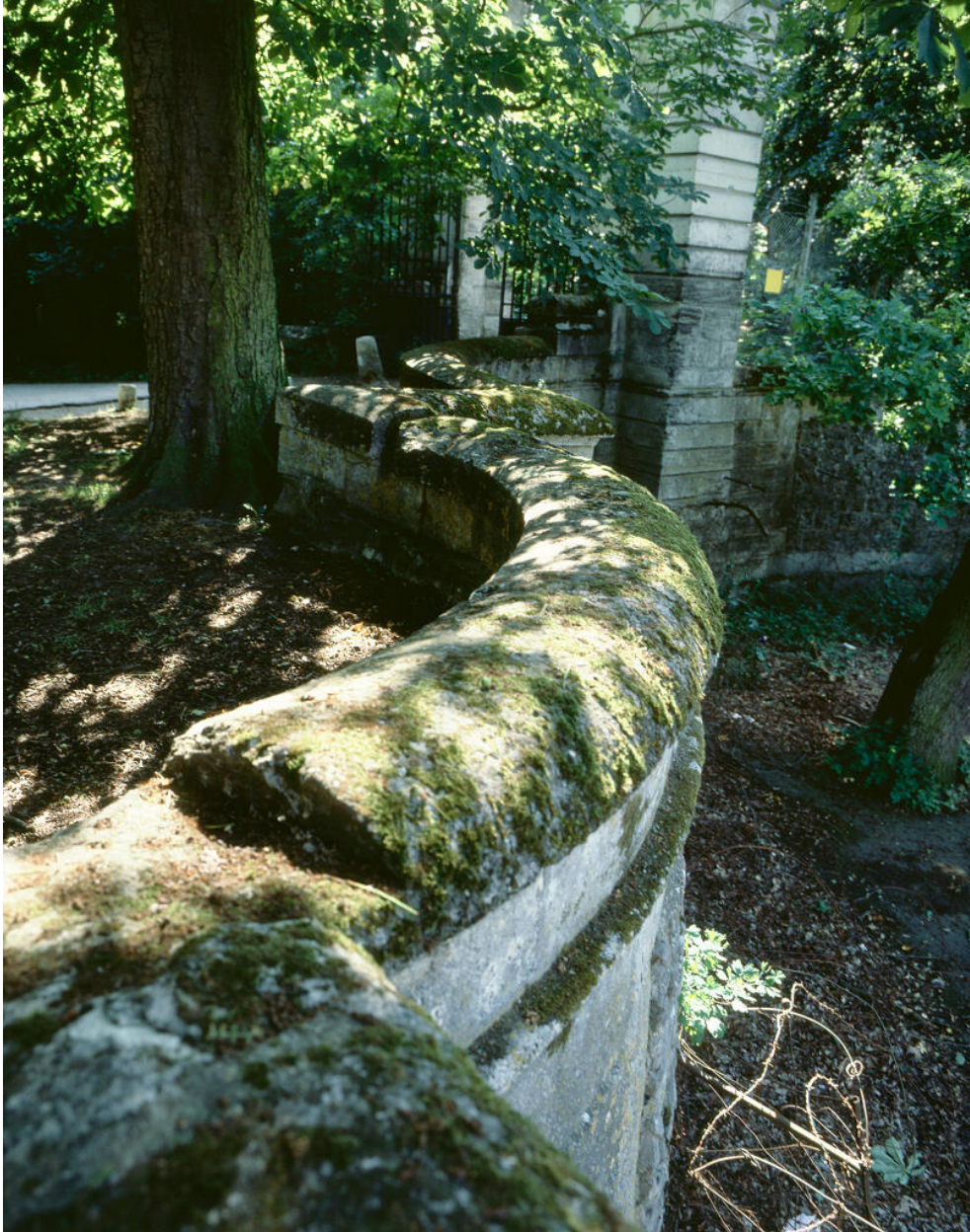
Entrée dite "les caves du Nord": détail de la modénature du mur de soutènement.
