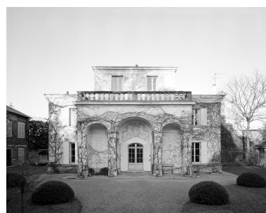
Ecuries. Façade antérieure de la maison construite autour de l'abreuvoir en 1883 dite maison de la Grotte. Phot. Vialles Jean-Bernard IVR11_19907800068V
