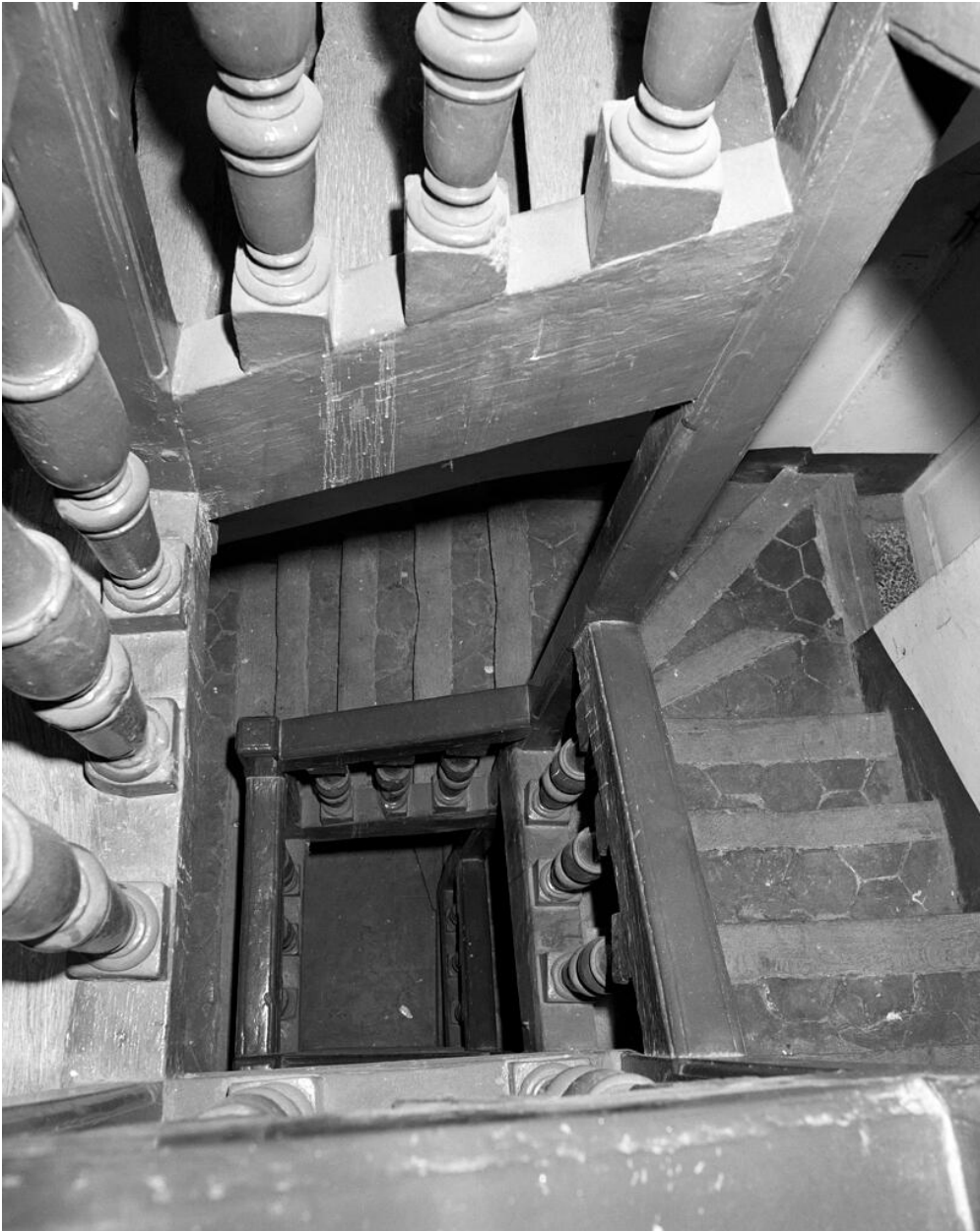
Entrée sud dite porte Pétrous. Pavillon, 56, avenue de Paris; escalier : vue du vide central.
