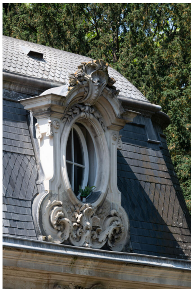
Lucarne du pavillon rocaille à l'entrée est du parc IVR11_20237500190NUC4A
