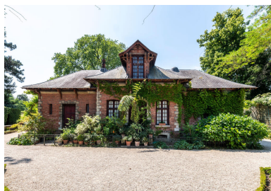
Maison du chef jardinier vue depuis le jardin des vivaces IVR11_20237500207NUC4A
