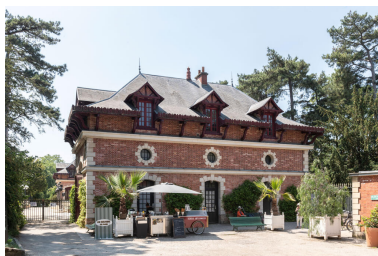
Bâtiment des écuries et de la salle des gardes IVR11_20237500195NUC4A
