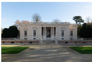
Façade du trianion. Le corps central est percé d'une petite colonnade. Phot. Kruszyk Laurent IVR11_20257501811NUC4A
