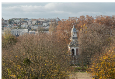
Pompe-à-feu du château de Bagatelle, construite en 1860 par l'architecte Léon de Sanges. Phot. Kruszyk Laurent IVR11_20257501802NUC4A
