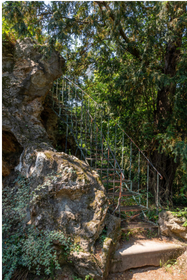
Grotte des quatre vents. Escalier d'accès au belvédère. IVR11_20237500248NUC4A
