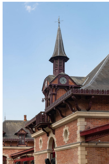
Lanteron sur le bâtiment des anciennes écuries IVR11_20237500196NUC4A
