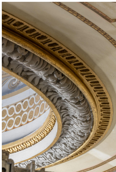
Salon de musique. Détail de la frise de la corniche du dôme. Phot. Kruszyk Laurent IVR11_20257501853NUC4A
