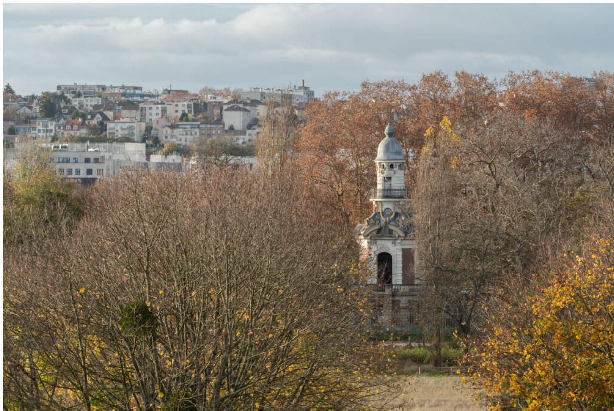
Pompe-à-feu du château de Bagatelle, construite en 1860 par l'architecte Léon de Sanges.
