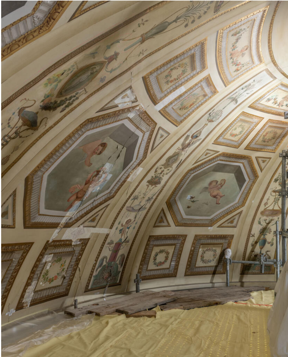
Le dôme du salon de musique en cours de restauration. Les sondages montrent que les décors ont été repeints à l'identique.
