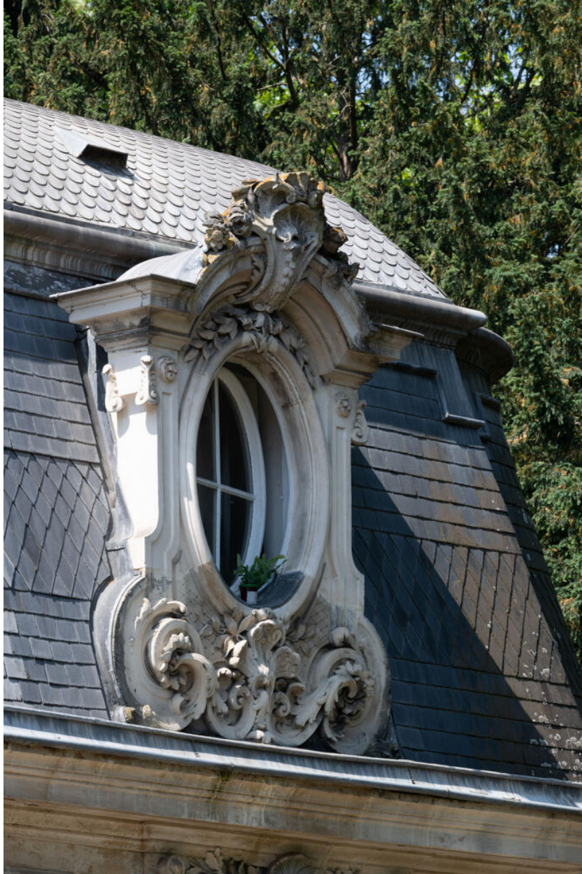
Lucarne du pavillon rocaille à l'entrée est du parc
