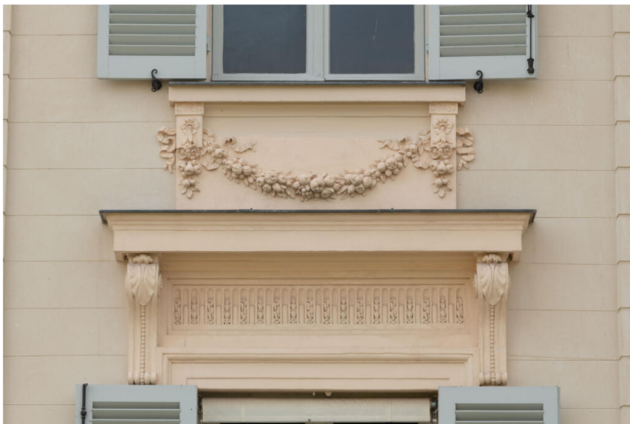
Sur la façade postérieure, flanc gauche, détail d'une imposte et d'une allège dont les décors se rejoignent.
