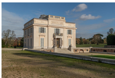
Vue de trois-quarts, angle sud-ouest. Phot. Kruszyk Laurent IVR11_20257501818NUC4A
