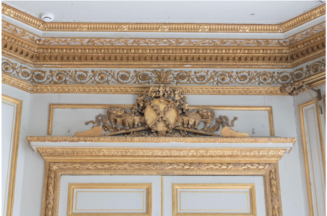
Dans le salon, détail d'un dessus de porte à tambourins et bouffons à grelots.
