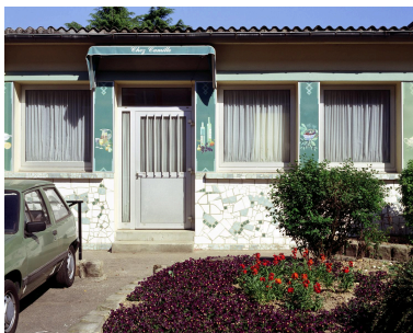
Vue de la façade du "restaurant inter-génération Camille" du groupe scolaire Flammarion. Elle est ornée de panneaux de bois peint (natures mortes) et de céramique cassée blanc et vert.
