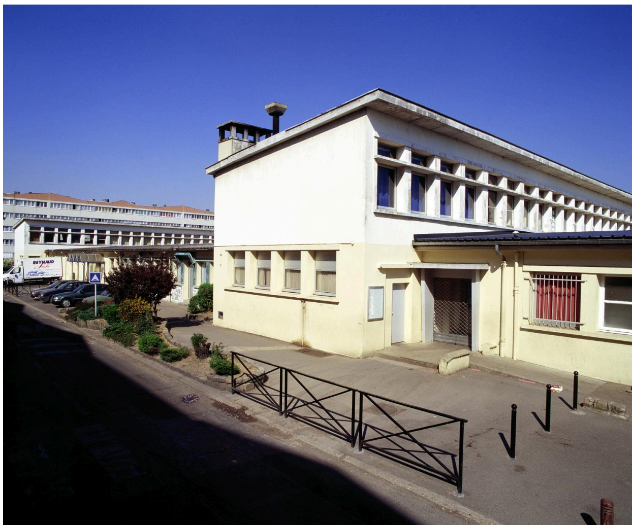
Vue du bâtiment central de l'école primaire Flammarion.
