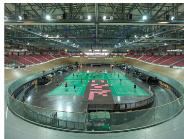
Le vélodrome de Saint-Quentin-en-Yvelines. Phot. Asseline Stéphane IVR11_20207800330NUC4A
