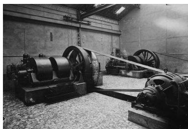
Moteur Ruston (fabriqué en Angleterre) de la salle des générateurs électriques, vers 1960. Photographie. (AD Seine-Saint-Denis. A NB 118) IVR11_20029300102NUC
