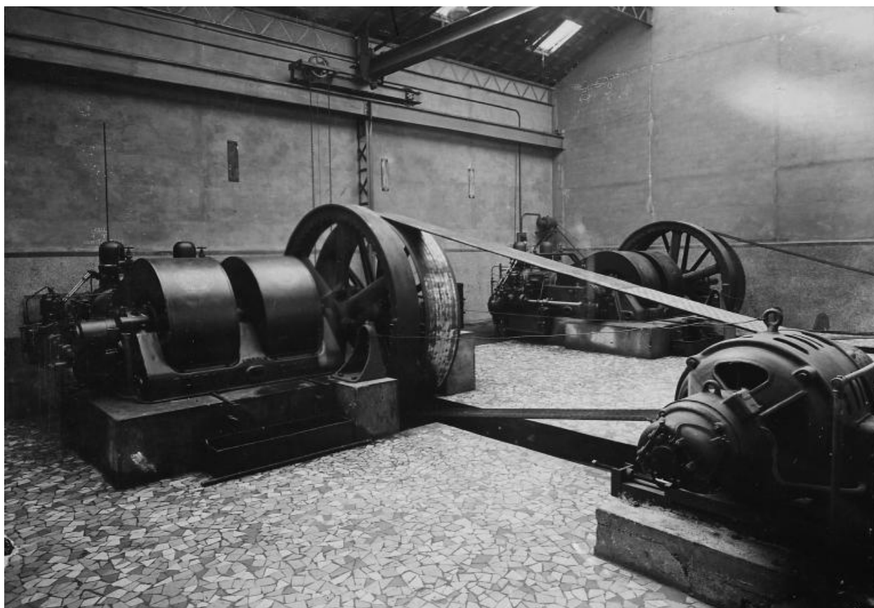
Moteur Ruston (fabriqué en Angleterre) de la salle des générateurs électriques, vers 1960. Photographie. (AD Seine-Saint-Denis. A NB 118)
