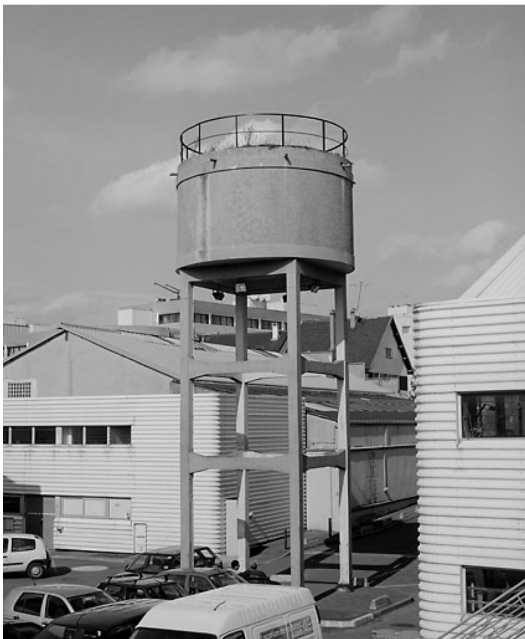
Vue du château d'eau.
