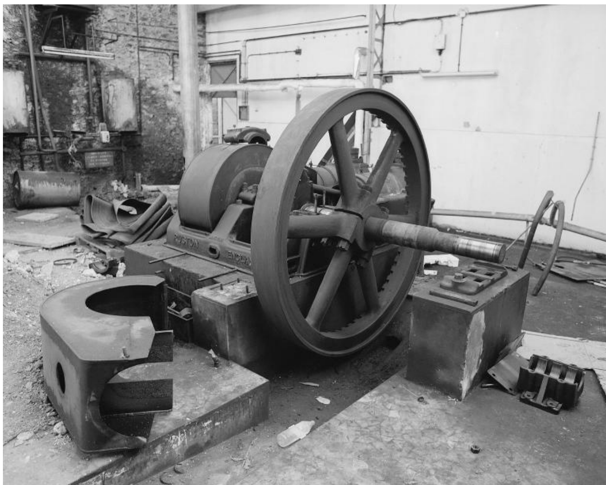
moteur Ruston des générateurs de la centrale électrique, vers 1988. Photographie. (AD Seine-Saint-Denis. A NB 118)
