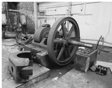
moteur Ruston des générateurs de la centrale électrique, vers 1988. Photographie. (AD Seine-Saint-Denis. A NB 118) IVR11_20029300120NUC
