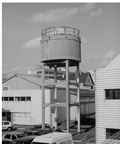
Vue du château d'eau. Phot. Jean-Bernard Vialles IVR11_20019300366X
