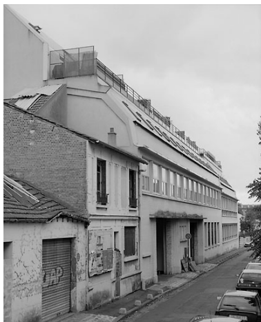
Vue générale depuis la rue Clotilde Gaillard. Phot. Jean-Bernard Vialles IVR11_20019300364X
