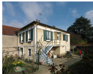
Maison au 3 rue Adeline, présentant la même toiture que
