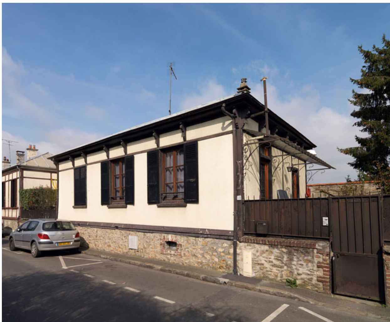
Vue de l'un des "chalets" (12, rue Aristide Briand).
