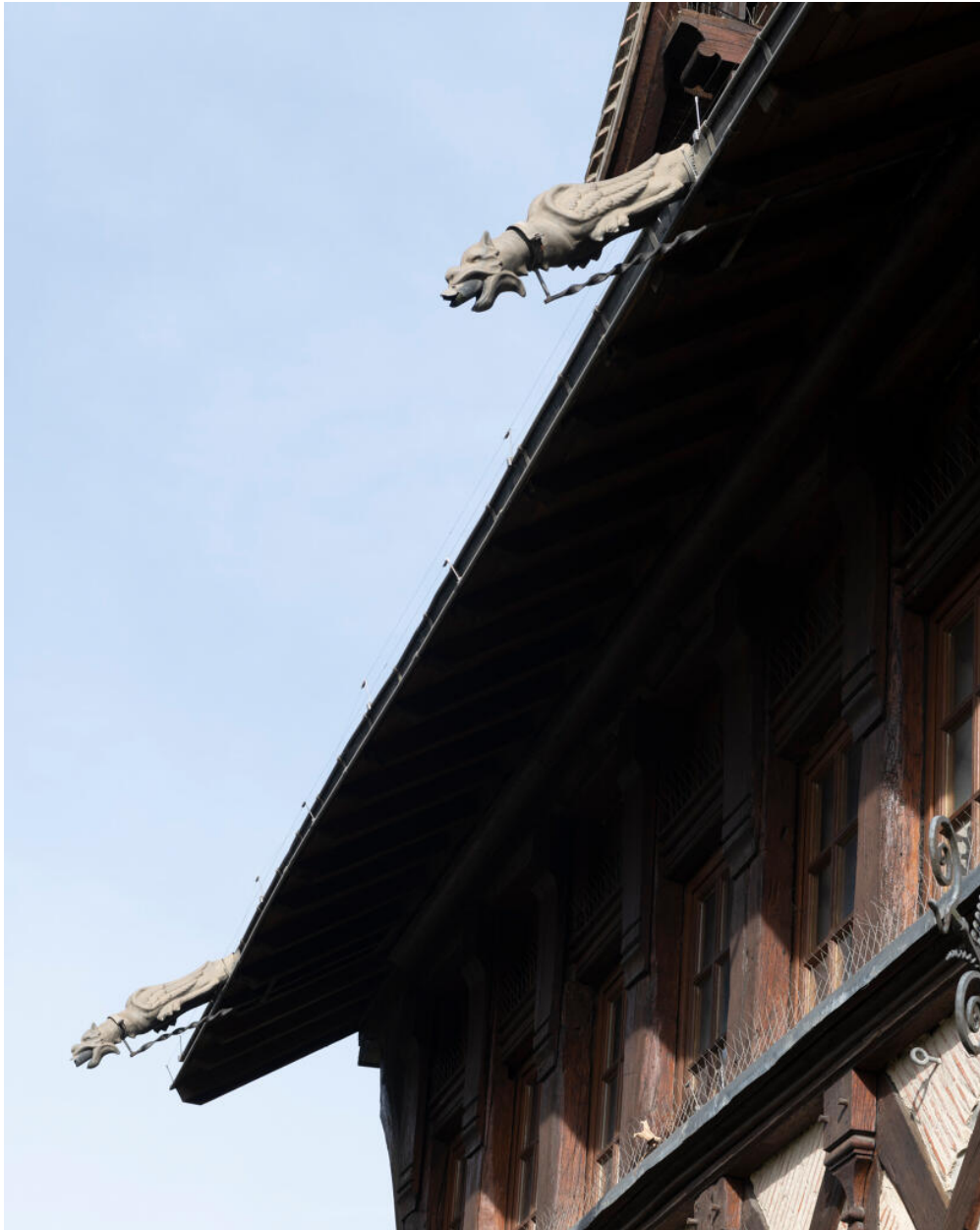
Gargouilles en façade sud.
