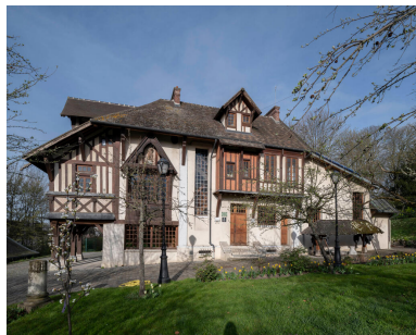
Façade est. Au sud, le porche XVe, au nord l'extension correspondant à la bibliothèque. La maison initiale s'arrêtait, au sud, à la grande baie verticale de l'escalier. IVR11_20239300298NUC4A
