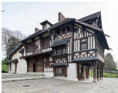
La façade ouest. L'extension sud mise en œuvre en 1893 comprenait un porche et une nouvelle travée, correspondant à une pièce par niveau. On lit cet ajout dans le décrochement du toit, ainsi que dans le positionnement des souches de cheminée qui encadraient les deux extrémités de la première maison. IVR11_20239300316NUC4A
