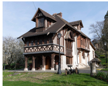
Angle sud-est. Le porche est devenu l'entrée de la maison, qui se trouvait à l'origine en façade est. Phot. Ayrault Philippe IVR11_20239300305NUC4A
