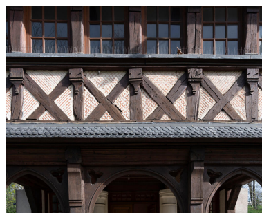
Façade sud, détail du porche rapporté, surmonté de croix de Saint André. Phot. Ayrault Philippe IVR11_20239300300NUC4A
