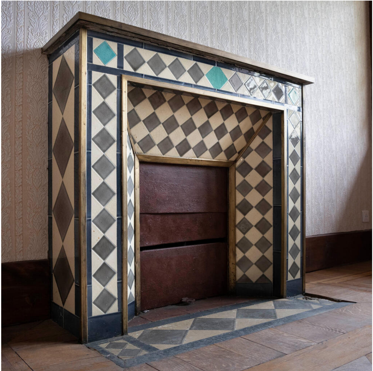
Cheminée à décor émaillé de l'une des chambres à coucher de l'étage.
