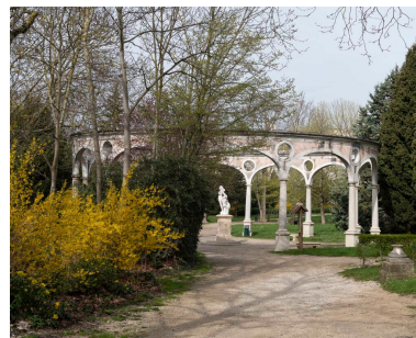
La colonnade dans le parc Courbet. Phot. Ayrault Philippe IVR11_20239300330NUC4A
