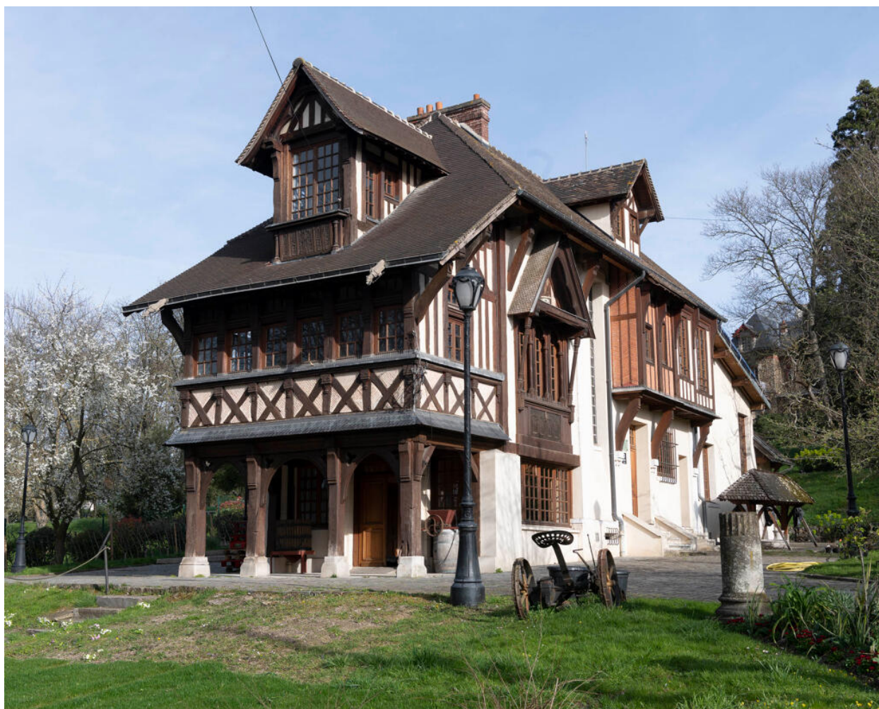
Angle sud-est. Le porche est devenu l'entrée de la maison, qui se trouvait à l'origine en façade est.
