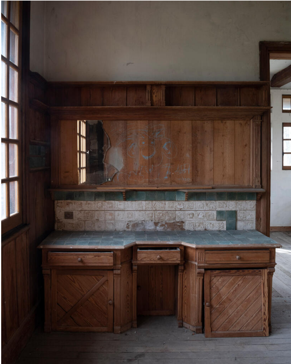
Au premier étage. La pièce avant celle sur le porche.
