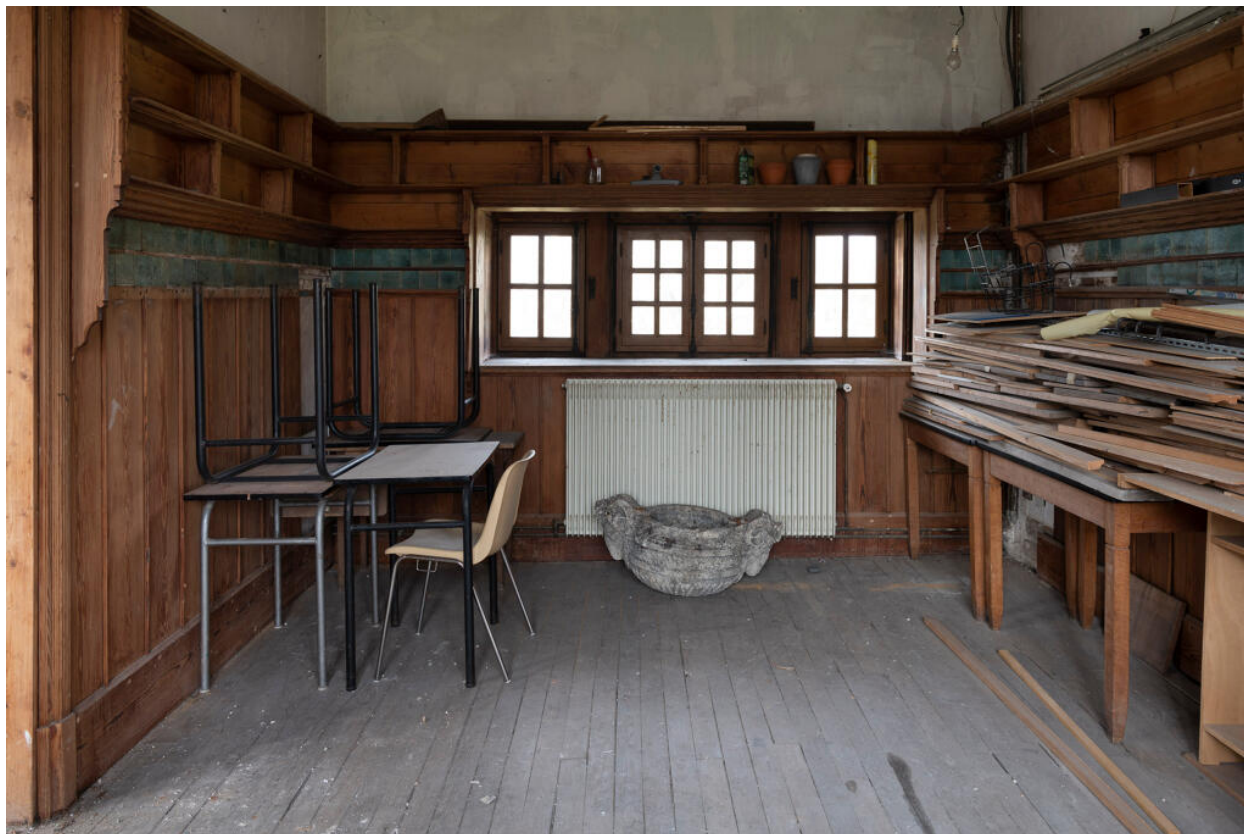
Au premier étage, dans l'extension sud, la pièce avant celle du porche.
