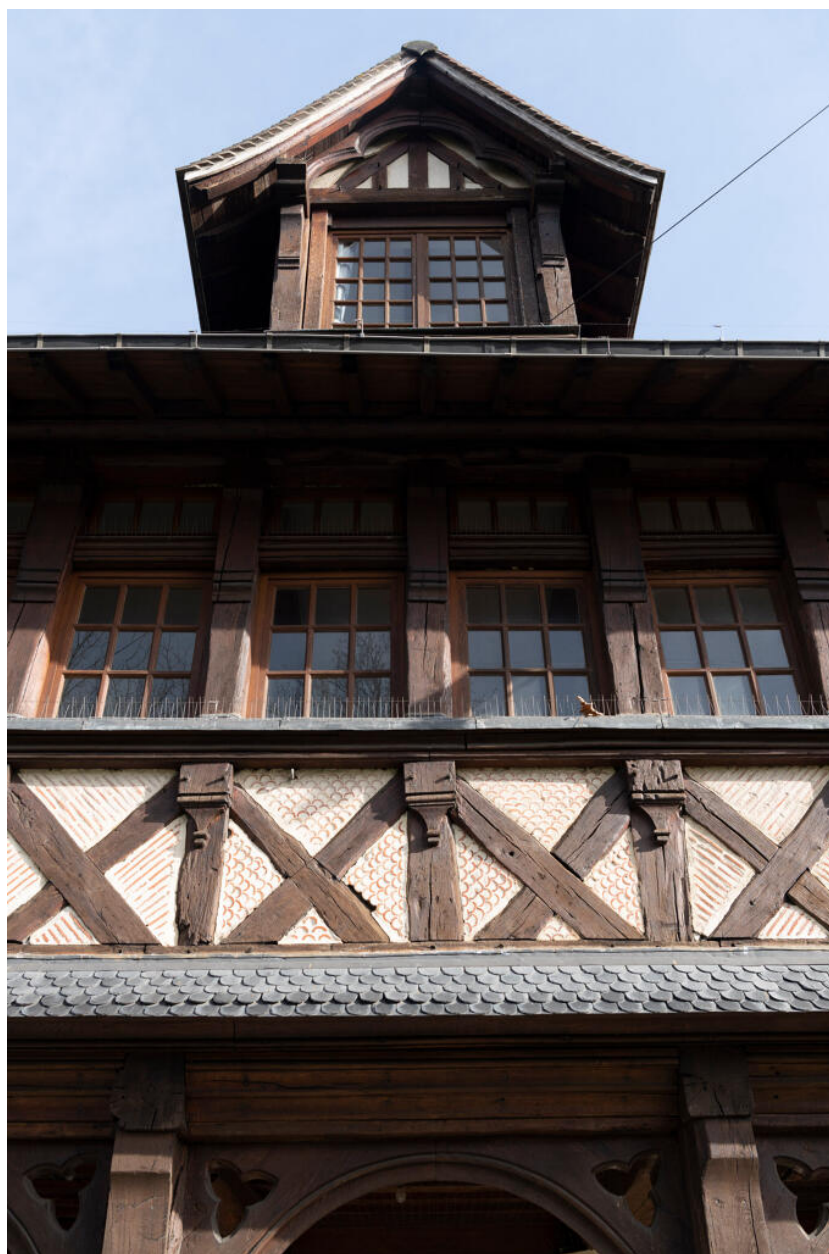
La façade de l'extension sud, ajoutée en 1893.
