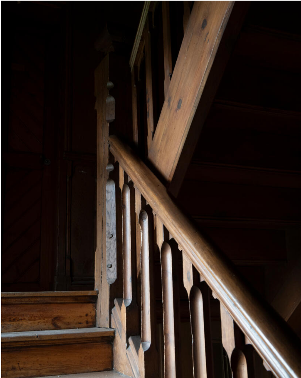
Détail des balustres de l'escalier.
