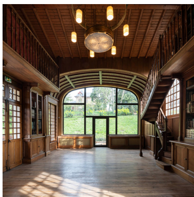
Le mur nord de la bibliothèque est constitué d'une verrière, refaite à neuf.
