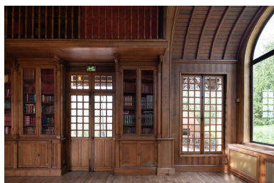
Le mur ouest de la bibliothèque. Une voûte à arc surbaissé assure la transition entre la façade vitrée et les murs à coursives.
