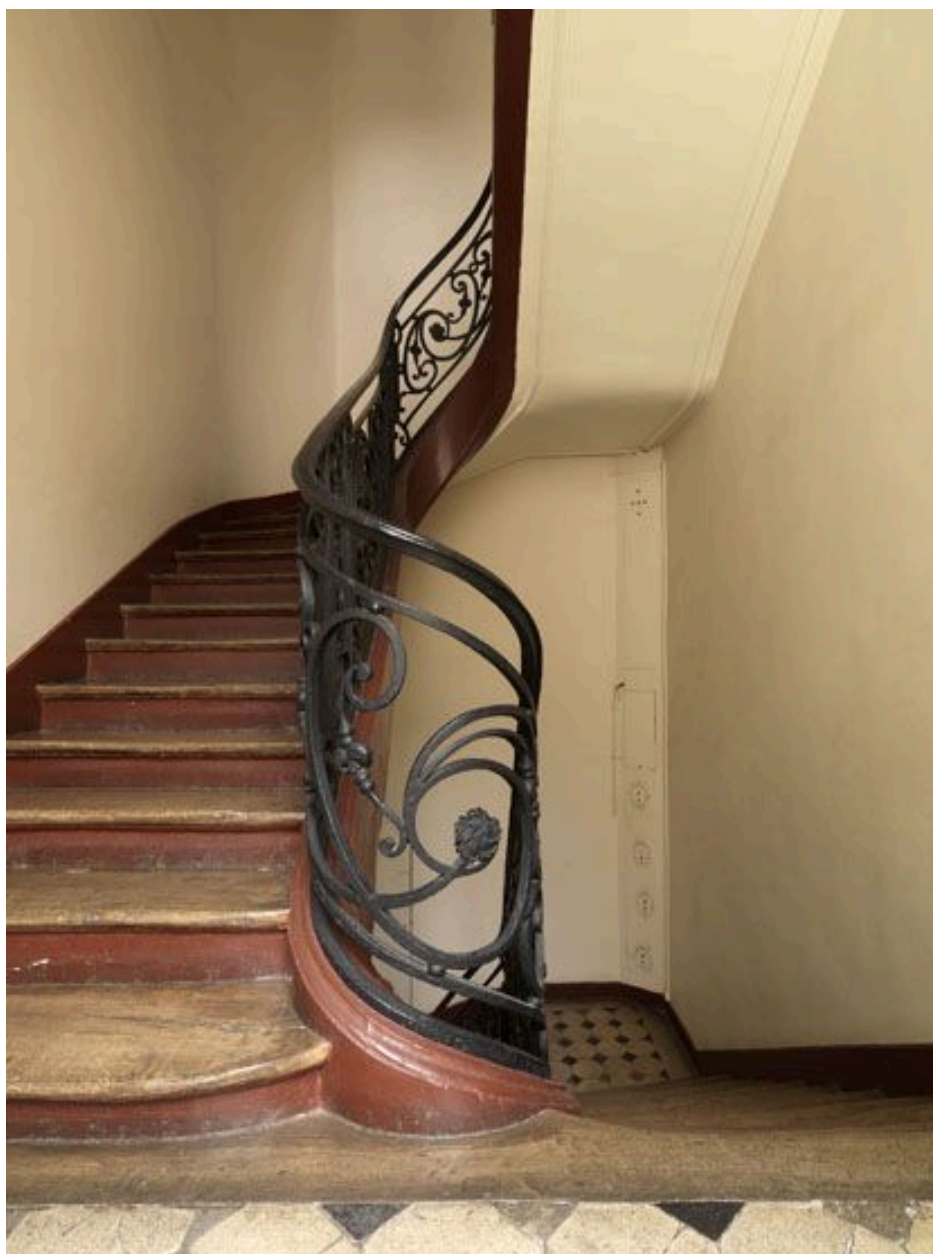
Partie tournante de la rampe.
