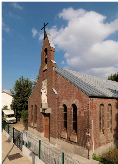
Vue de la façade principale. IVR11_20099300551NUC4A
