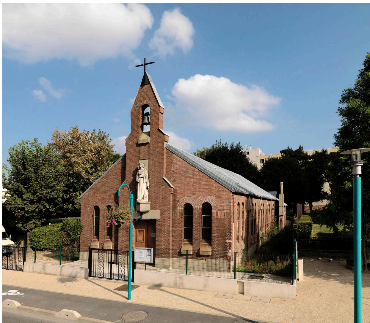
Vue actuelle de la façade.
