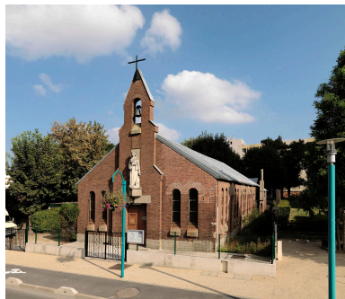
Vue actuelle de la façade. IVR11_20099300550NUC4A
