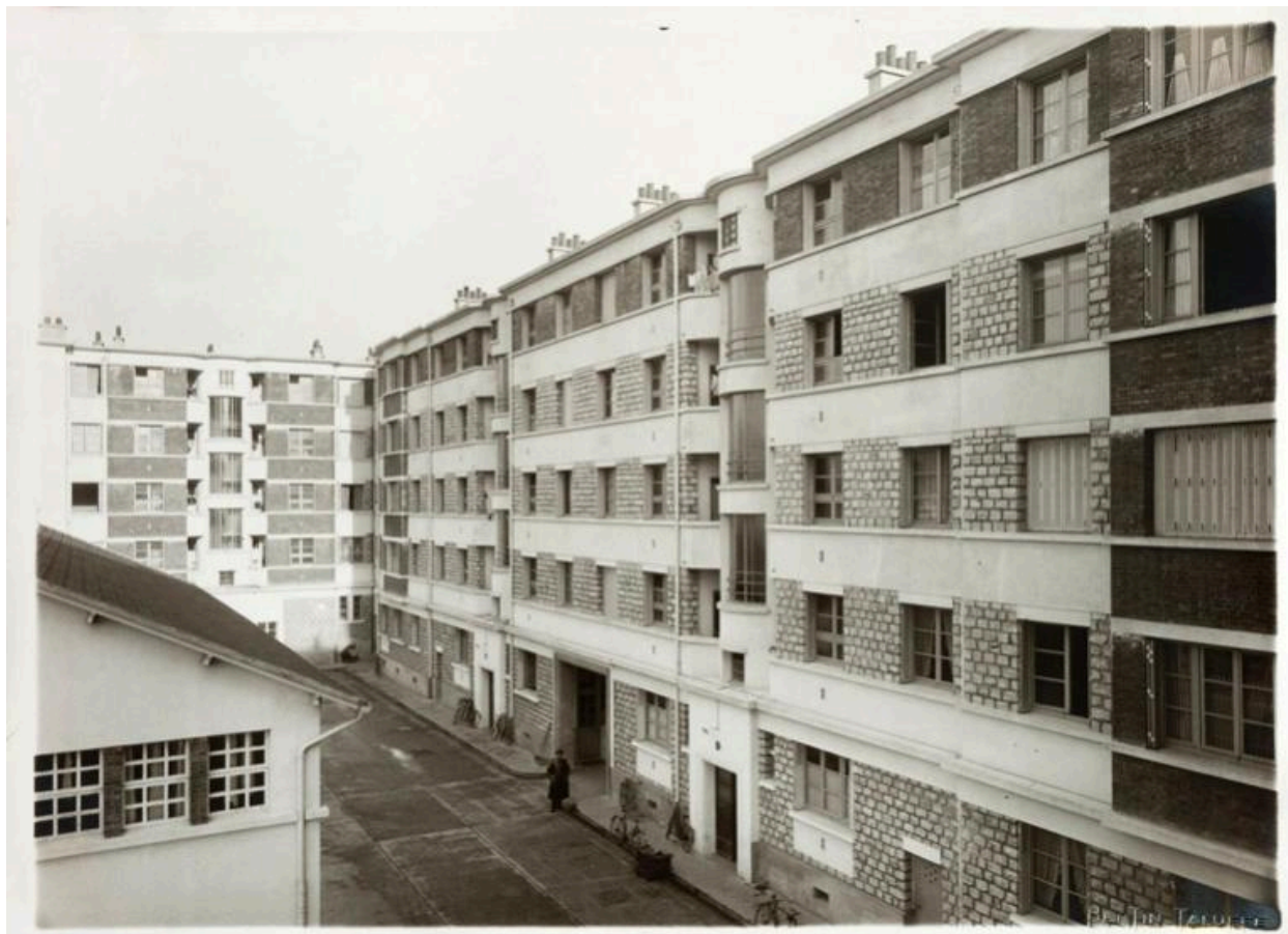
Façade sur la cour. Cliché Bertin-Taluffe. AM Mantes-la-Jolie (non coté).
