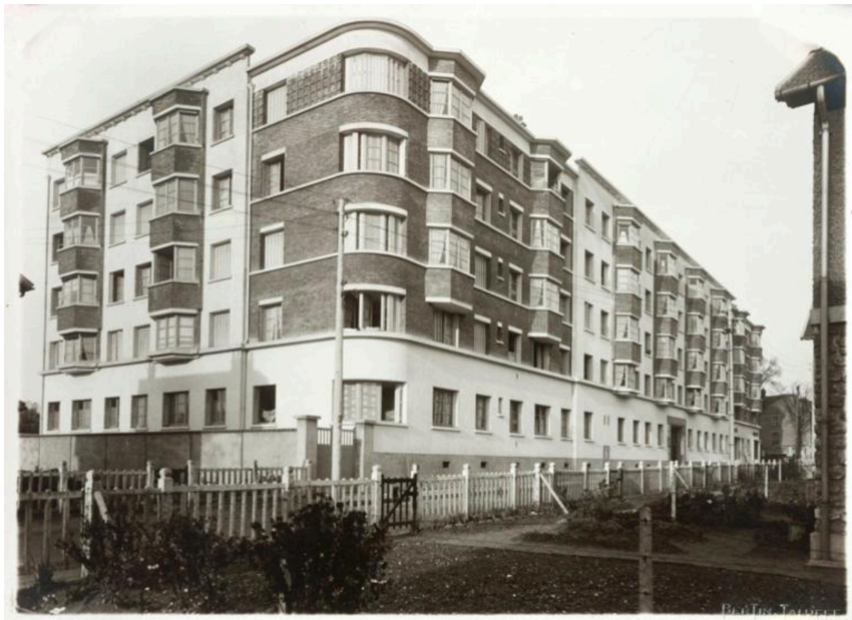
Vue d'ensemble de l'immeuble sur la rue Émile-Zola. Cliché Bertin-Taluffe. AM Mantes-la-Jolie (non coté).
