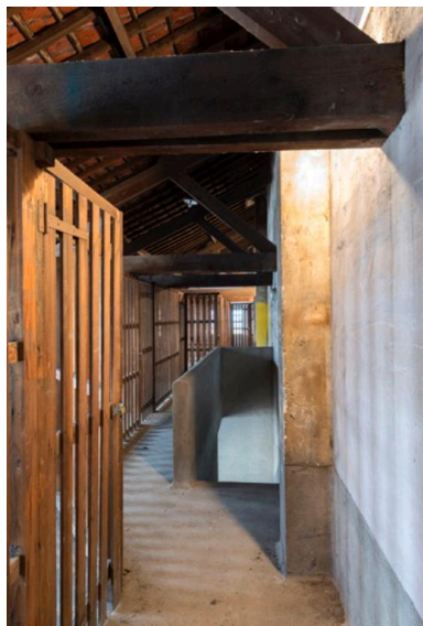
A l'étage de l'annexe se trouvent des séchoirs individualisés par des claire-voies en bois. Phot. Laurent Kruszyk IVR11_20177800122NUC4A
