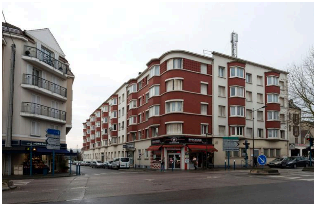
Vue d'ensemble de l'immeuble depuis le boulevard du Maréchal-Juin.
