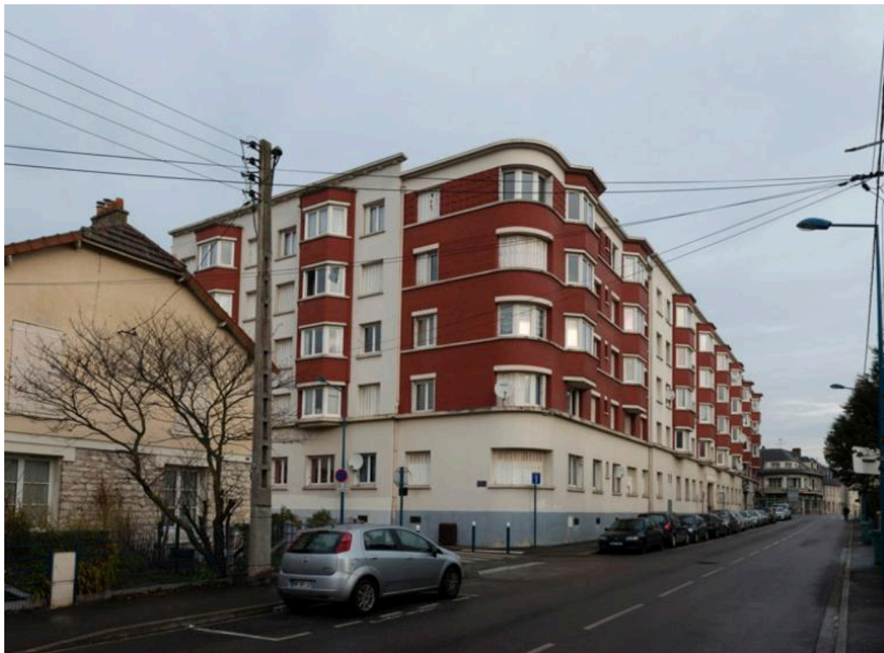
Vue de l'immeuble sur la rue Emile-Zola.
