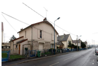
Pavillons rue Emile-Zola faisant partie du programme initial associant habitat collectif et individuel. Phot. Laurent Kruszyk IVR11_20177800125NUC4A
