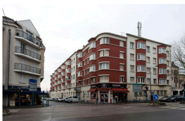
Vue d'ensemble de l'immeuble depuis le boulevard du Maréchal-Juin. Phot. Laurent Kruszyk IVR11_20177800114NUC4A
