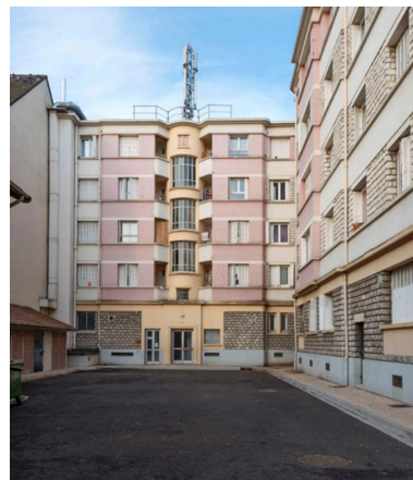
La façade sur cour de l'aile sur le boulevard est en brique. Elle a été repeinte en rose clair. Phot. Laurent Kruszyk IVR11_20177800117NUC4A
