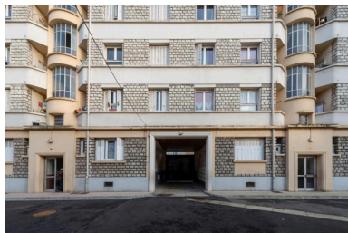
La façade sur cour du bâtiment principal est en moellons de calcaire à assises régulières. Phot. Laurent Kruszyk IVR11_20177800116NUC4A
