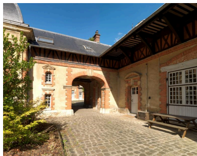
Les communs : passage vers la cour arrière. Phot. Laurent Kruszyk IVR11_20179500413NUC4A
