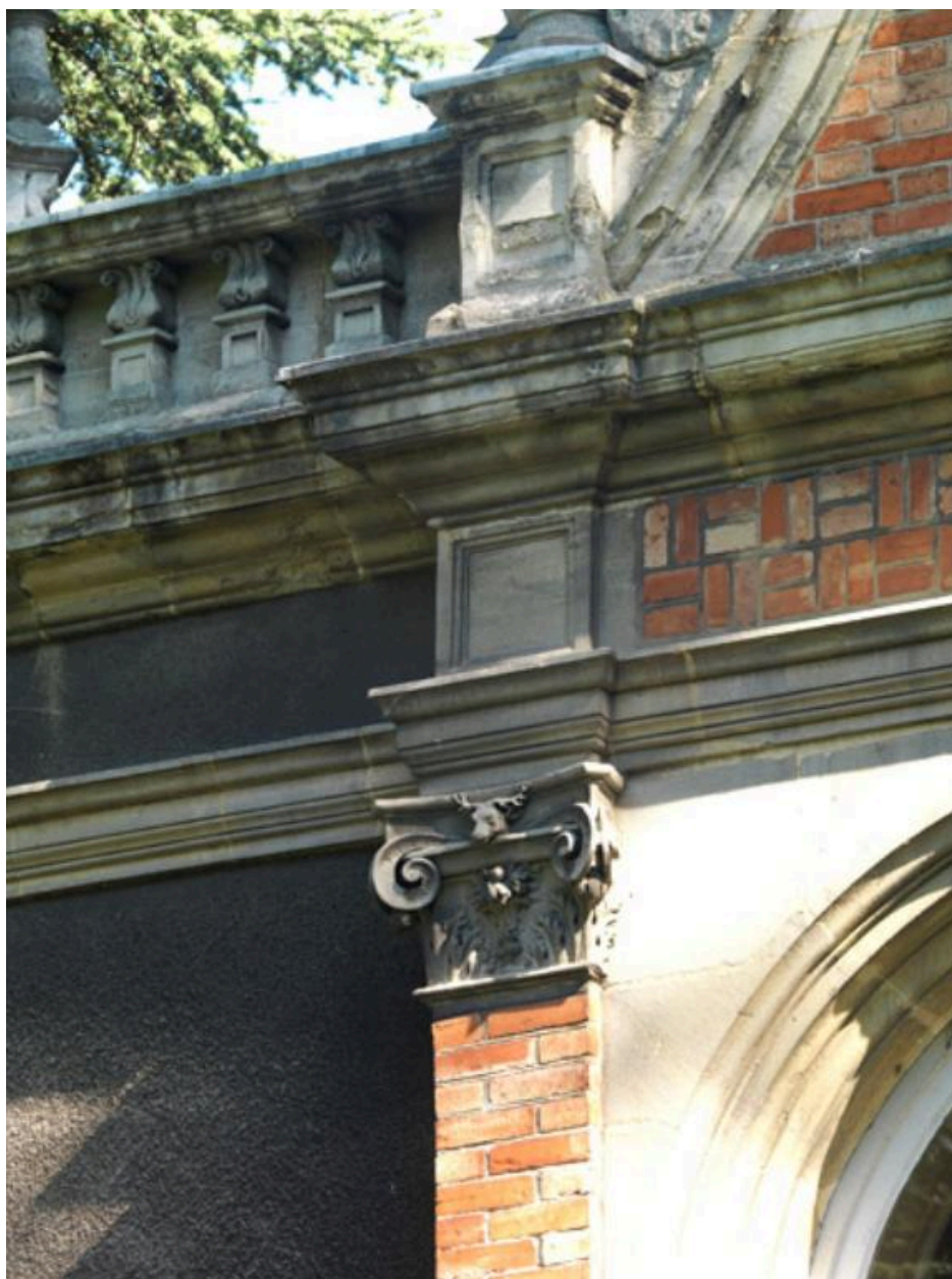
Chapiteau d'un pilastre pendant du précédent avec une tête de cerf dans l'abaque.
