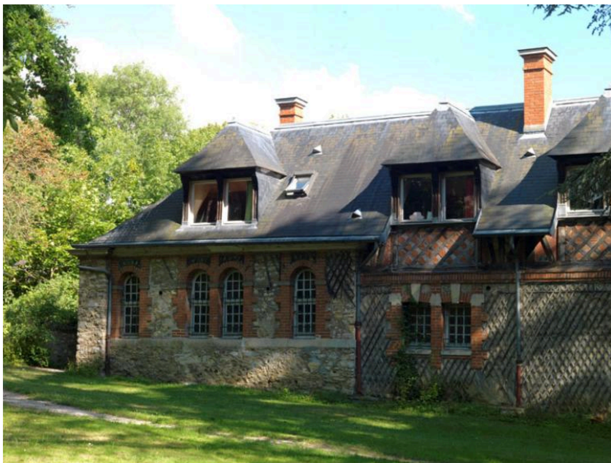
Façade arrière des communs.
