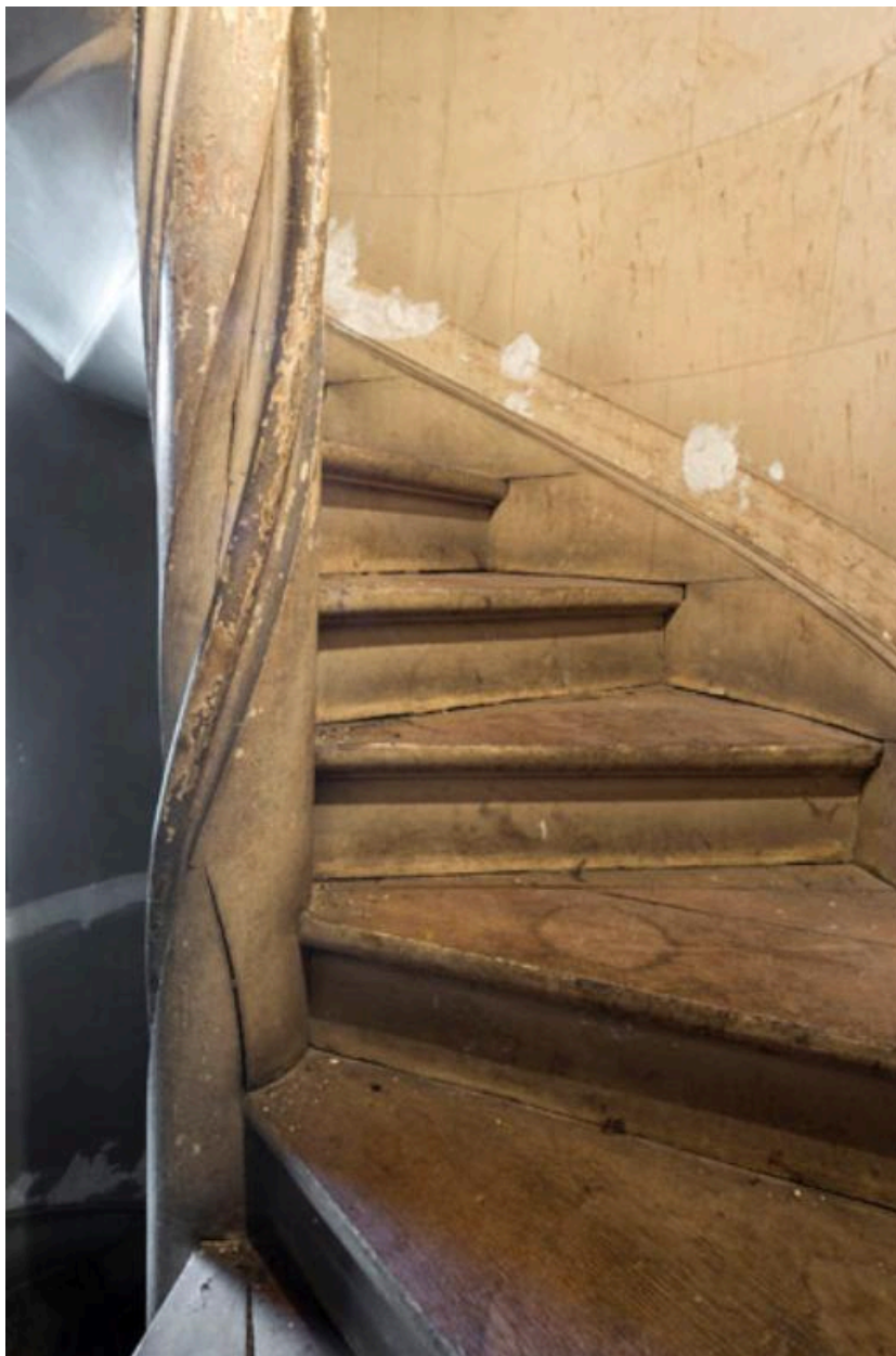
Escalier en vis avec une main courante taillée dans le noyau.
