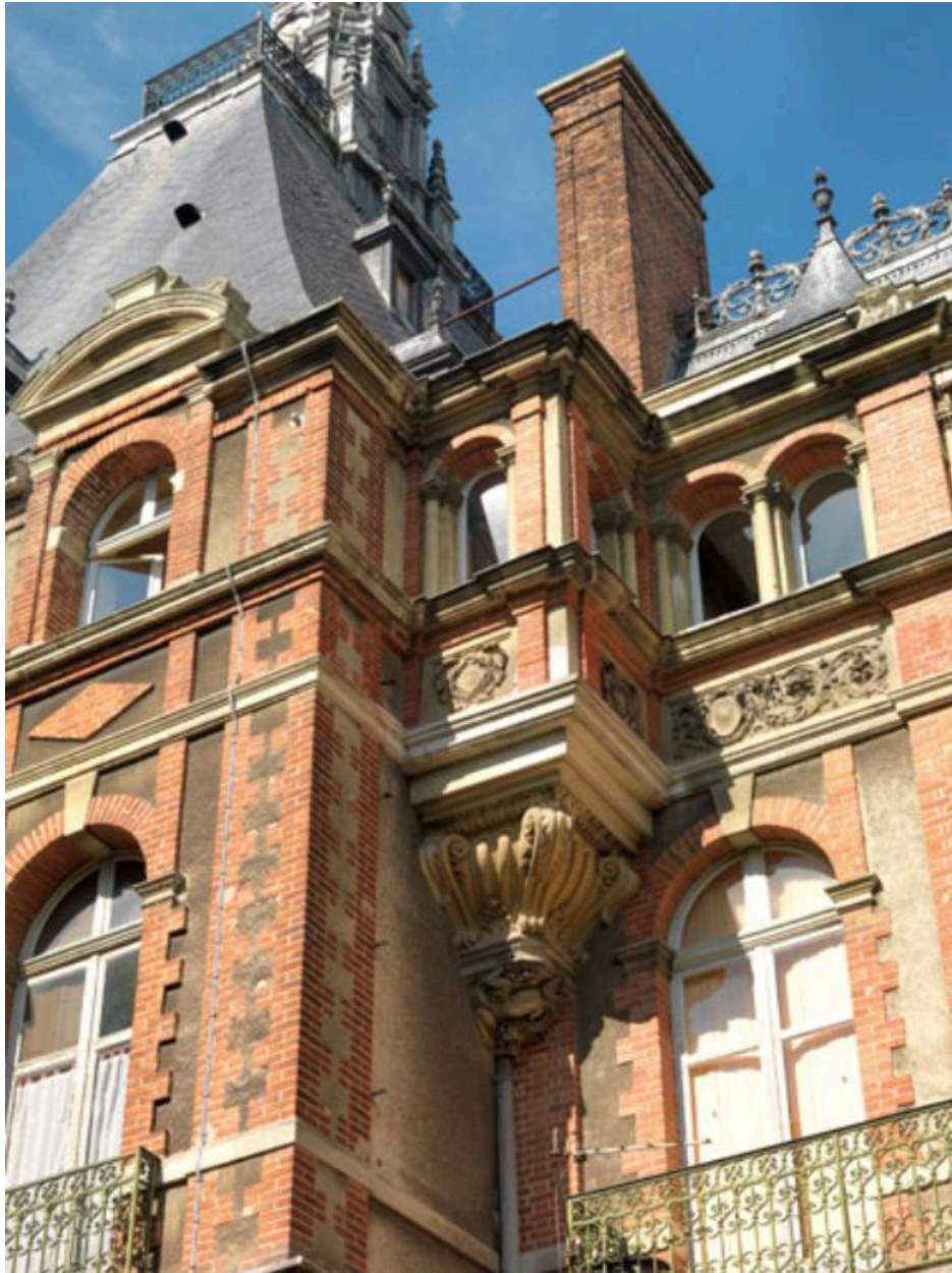
Un cabinet en saillie sur la façade côté jardin.
