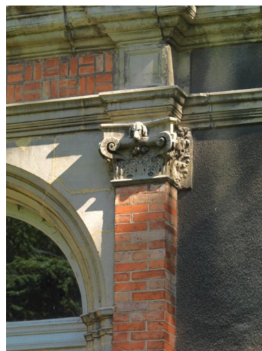
Chapiteau d'un pilastre avec une tête de chien dans l'abaque. Phot. Laurent Kruszyk IVR11_20179500406NUC4A
