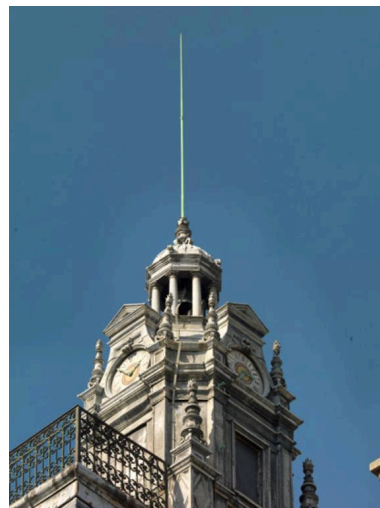
Le belvédère est surmonté d'un campanile. Phot. Laurent Kruszyk IVR11_20179500403NUC4A
