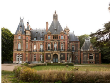
Le corps central et le corps en hors oeuvre sont dus à Pierre Victor Cuvillier. La partie gauche, postérieure est due à Julien Ponsin.
