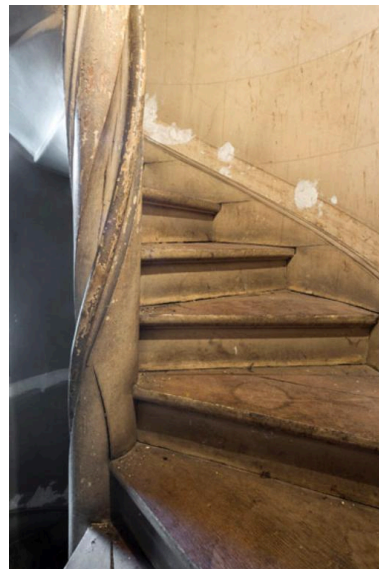
Escalier en vis avec une main courante taillée dans le noyau. Phot. Laurent Kruszyk IVR11_20179500456NUC4A
