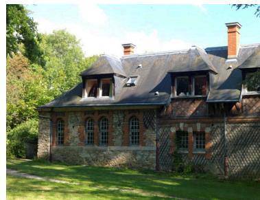
Façade arrière des communs. Phot. Laurent Kruszyk IVR11_20179500415NUC4A
