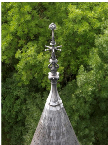
L'épi de faitage très orné d'un tourelle. Phot. Laurent Kruszyk IVR11_20179500396NUC4A
