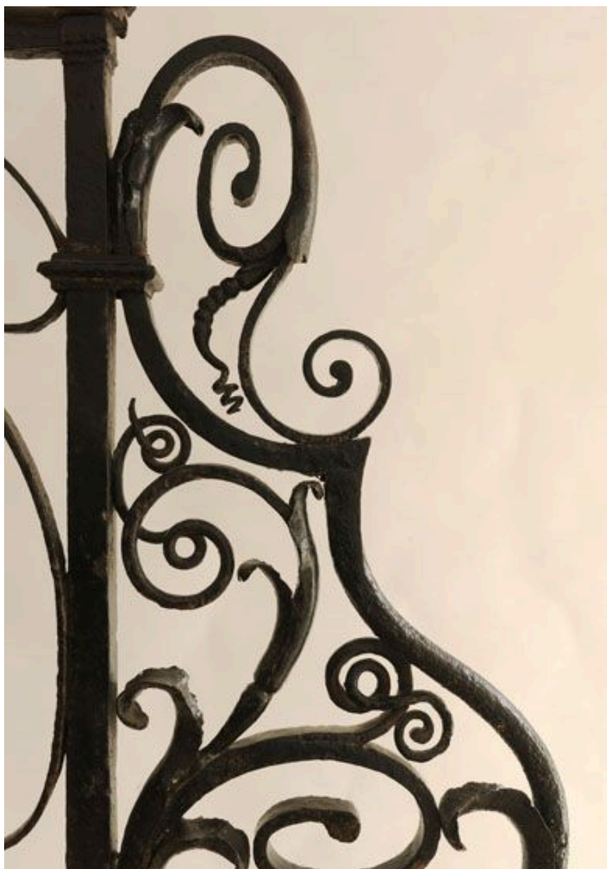
La console : détail de la partie supérieure et de ses nombreuses queues de cochon.
