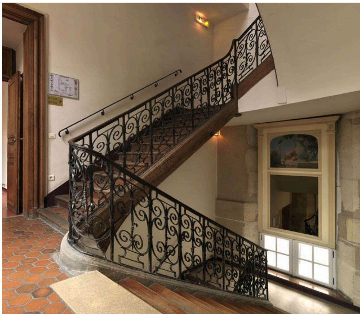
Deuxième et troisième volée de l'escalier.
