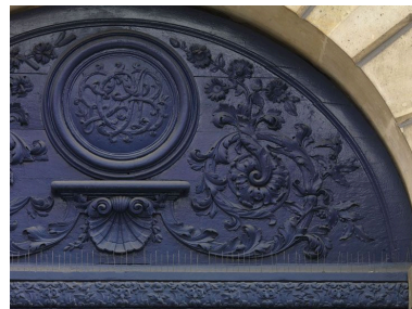
Détail du tympan de menuiserie du portail d'entrée. On distingue dans le chiffre les lettres G C et A B (pour Gilles Charpentier et Anne Binot). Phot. Laurent Kruszyk IVR11_20107500046NUC4A
