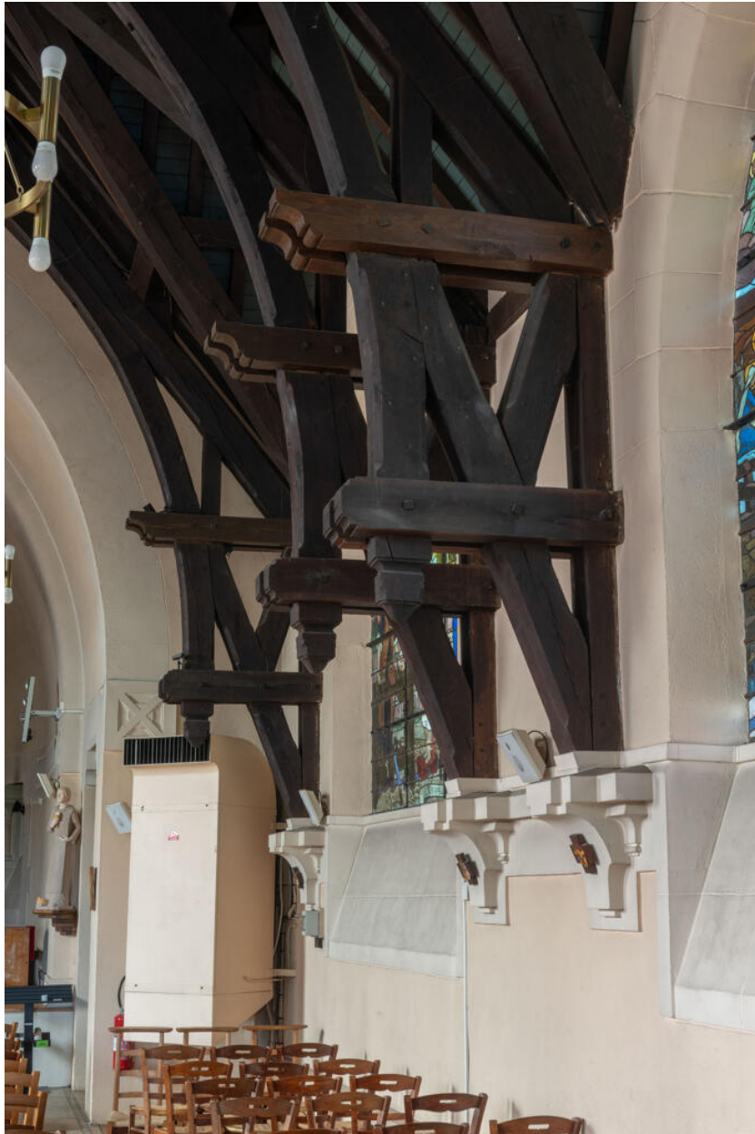
Chapelle Notre-Dame-des-Airs, charpente, vue de détail
