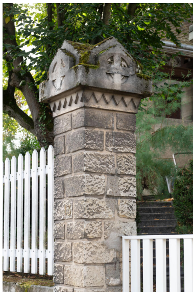
Chapelle Notre-Dame-des-Airs, pilier appareillé de la clôture sur rue Phot. Kruszyk Laurent IVR11_20249200500NUC4A
