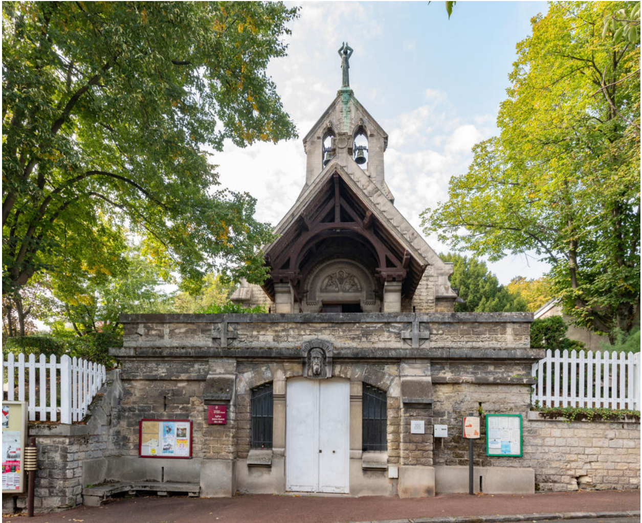
Chapelle Notre-Dame-des-Airs, vue générale depuis la rue
