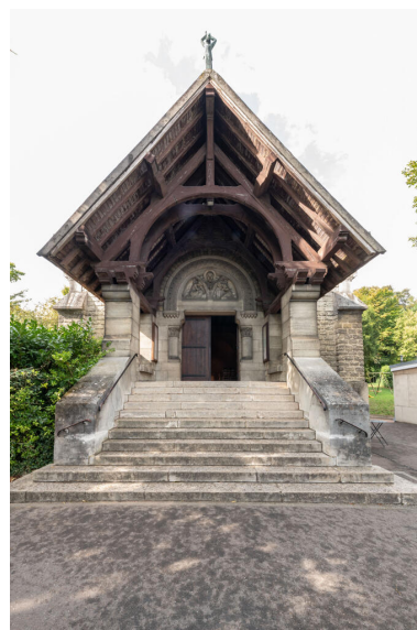
Chapelle Notre-Dame-des-Airs, façade principale, auvent à charpente apparente Phot. Kruszyk Laurent IVR11_20249200504NUC4A
