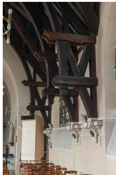
Chapelle Notre-Dame-des-Airs, charpente, vue de détail Phot. Kruszyk Laurent IVR11_20249200512NUC4A
