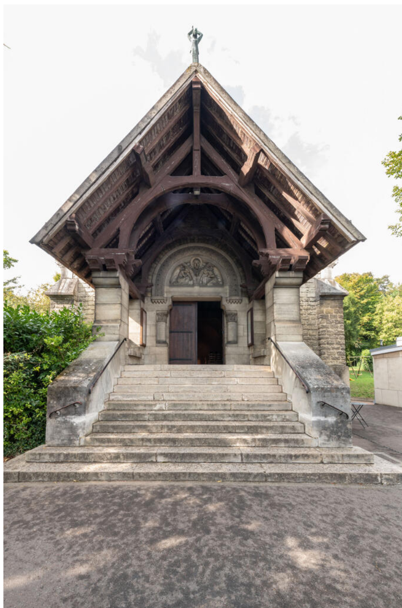
Chapelle Notre-Dame-des-Airs, façade principale, auvent à charpente apparente
