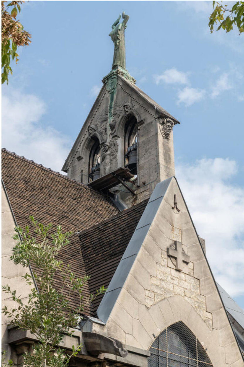
Chapelle Notre-Dame-des-Airs, pignon de la première travée sud et revers du clocher-mur
