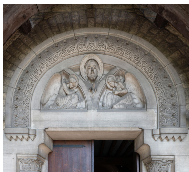
Chapelle Notre-Dame-des-Airs, tympan du portail principal représentant le Christ en buste flanqué de deux anges en adoration Phot. Kruszyk Laurent IVR11_20249200505NUC4A
