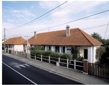
Vue de deux pavillons le long de l'avenue Jules-Vallès (n° 118 et 120). Phot. Philippe Ayrault IVR11_20029101385XA
