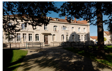
Construction de 1934 en meulière blanche de style arts déco. A l'est, la porte en ferronnerie géométrique est surmontée d'un auvent léger de ciment moulé.. Phot. Philippe Ayrault IVR11_20117700489NUC4A
