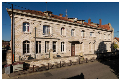
Construction de 1934 en meulière blanche de style arts déco. A l'est, la porte en ferronnerie géométrique est surmontée d'un auvent léger de ciment moulé.. Phot. Philippe Ayrault IVR11_20117700490NUC4A
