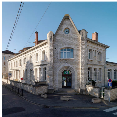
Construction de 1934 en meulière blanche de style arts déco. Façade en pan coupé formant pignon, encadrée par deux piles monumentales surmontées de pinacles à redents. Phot. Philippe Ayrault IVR11_20117700487NUC4A
