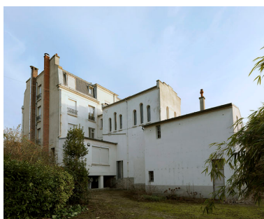
Vue arrière du bâtiment avec successivement le bâtiment de la sacristie, la chapelle et le corps de bâtiment principal. Phot. Jean-Bernard Vialles IVR11_20099500056NUC4A
