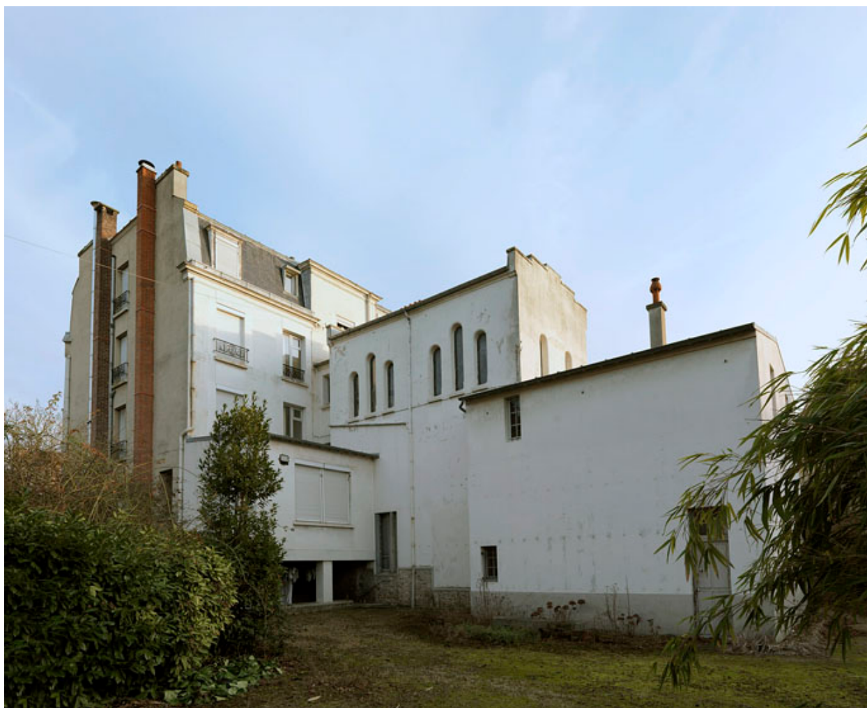
Vue arrière du bâtiment avec successivement le bâtiment de la sacristie, la chapelle et le corps de bâtiment principal.
