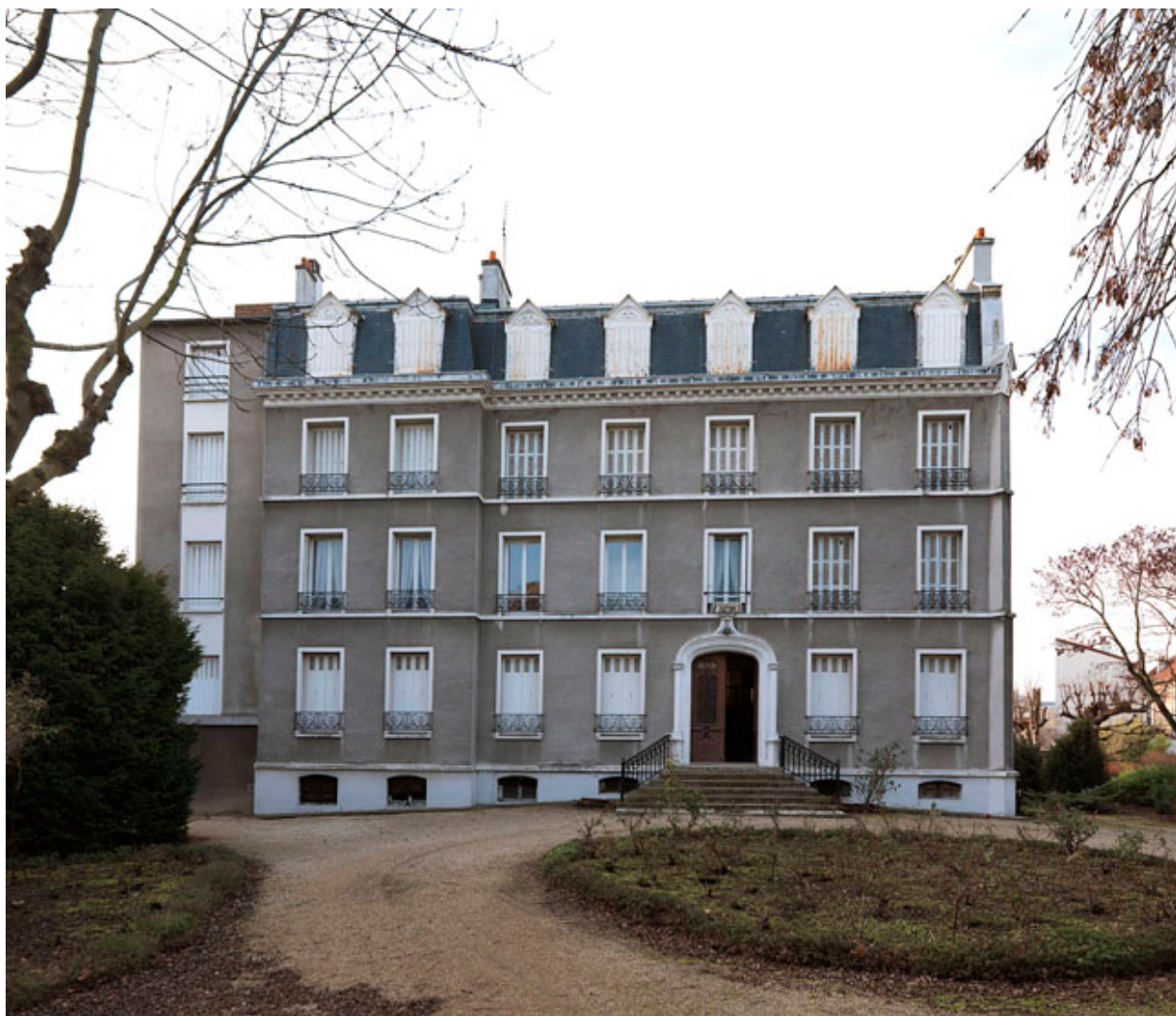
Vue d'ensemble de la façade principale.
