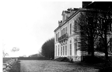
Façade postérieure. Carte postale. (Soc. hist. du Vieux Nogent) Phot. Christian Décamps IVR11_19859400860XB
