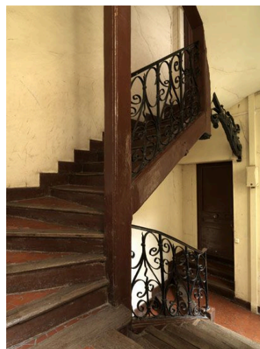
Poteaux continus à l'étage. Phot. Laurent Kruszyk IVR11_20097501048NUC4A
