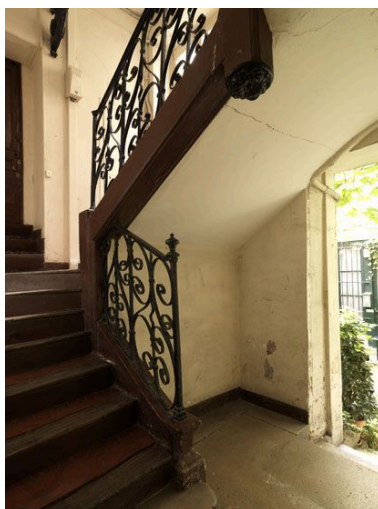
La forme de l'escalier est rampe sur rampe avec poteaux interrompus. Phot. Laurent Kruszyk IVR11_20097501047NUC4A
