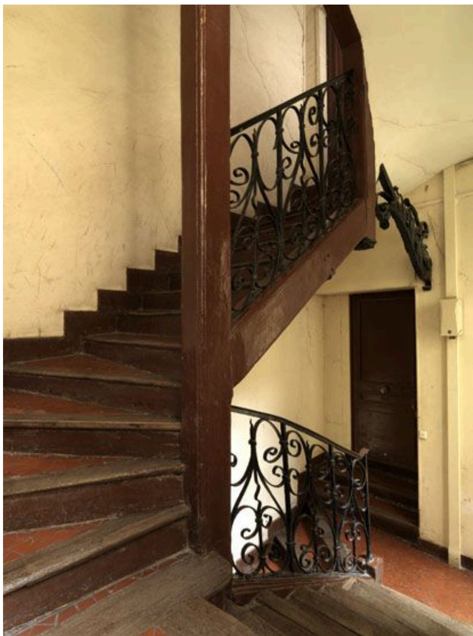
Poteaux continus à l'étage.
