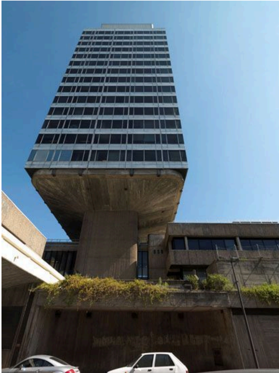
Vue rapprochée de la tour, prise par en dessous.
