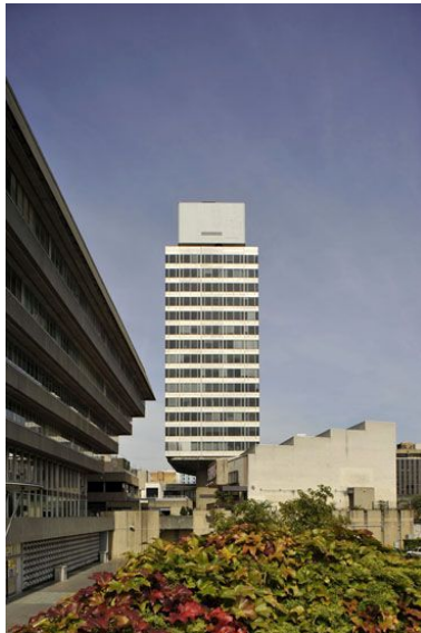
Vue d'ensemble. Phot. Philippe Ayrault IVR11_20119500867NUC2A
