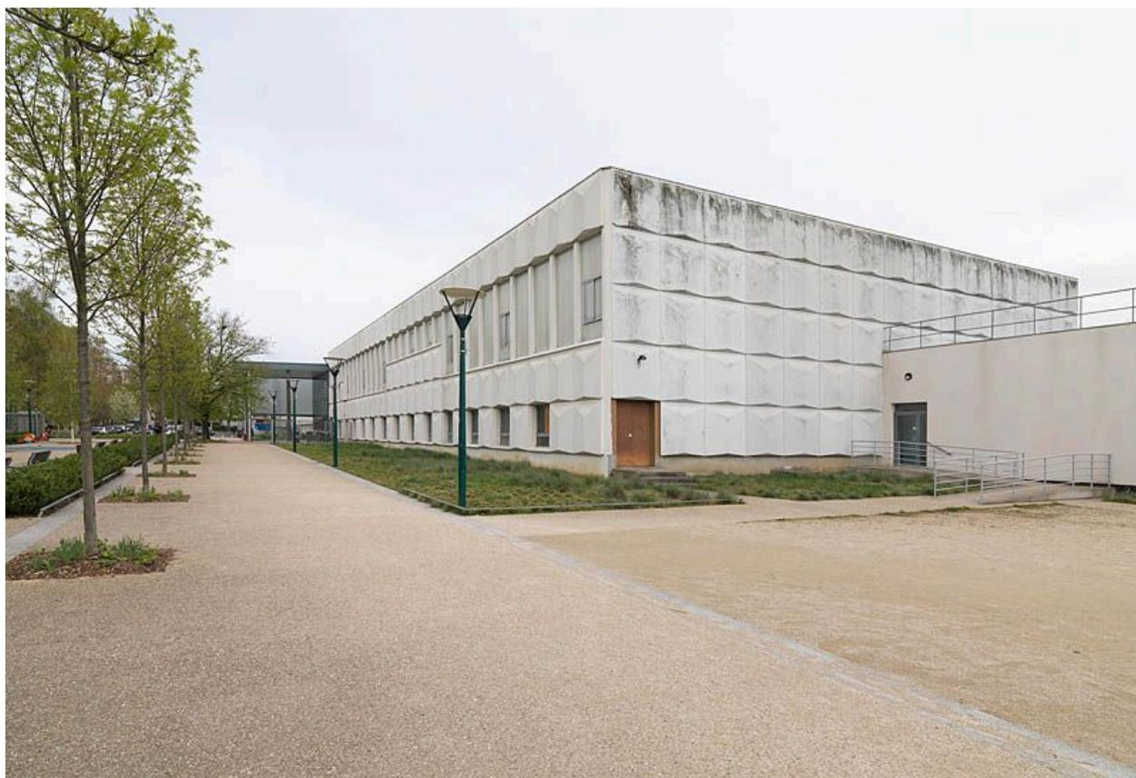
Vue de l'ensemble du bâtiment : la partie de la façade diamantée est d'origine tandis que l'extension a été réalisée en 2005 afin d'aménager une salle de musculation.
