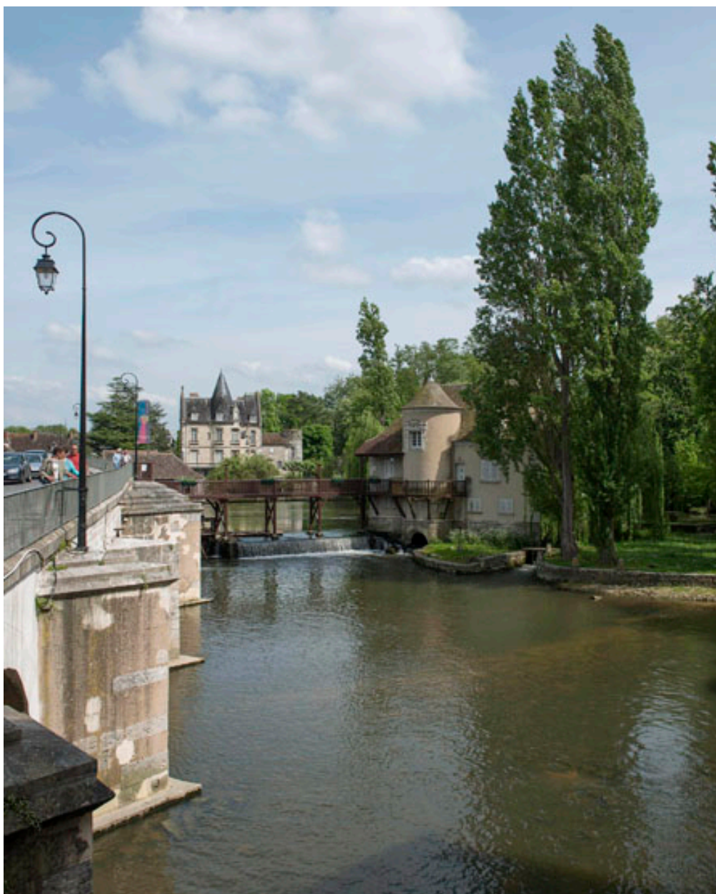
Vue extérieure depuis le pont sur le Loing.
