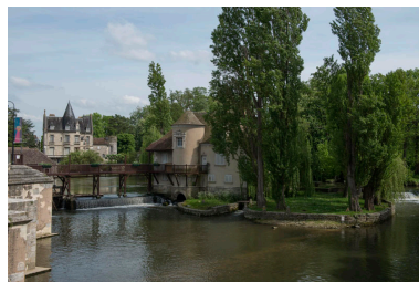
Vue extérieure depuis le pont sur le Loing. Phot. Philippe Ayrault IVR11_20157700328NUC4A
