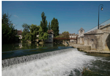
Vue du barrage sur Le Loing. Phot. Philippe Ayrault IVR11_20087701129NUC4A
