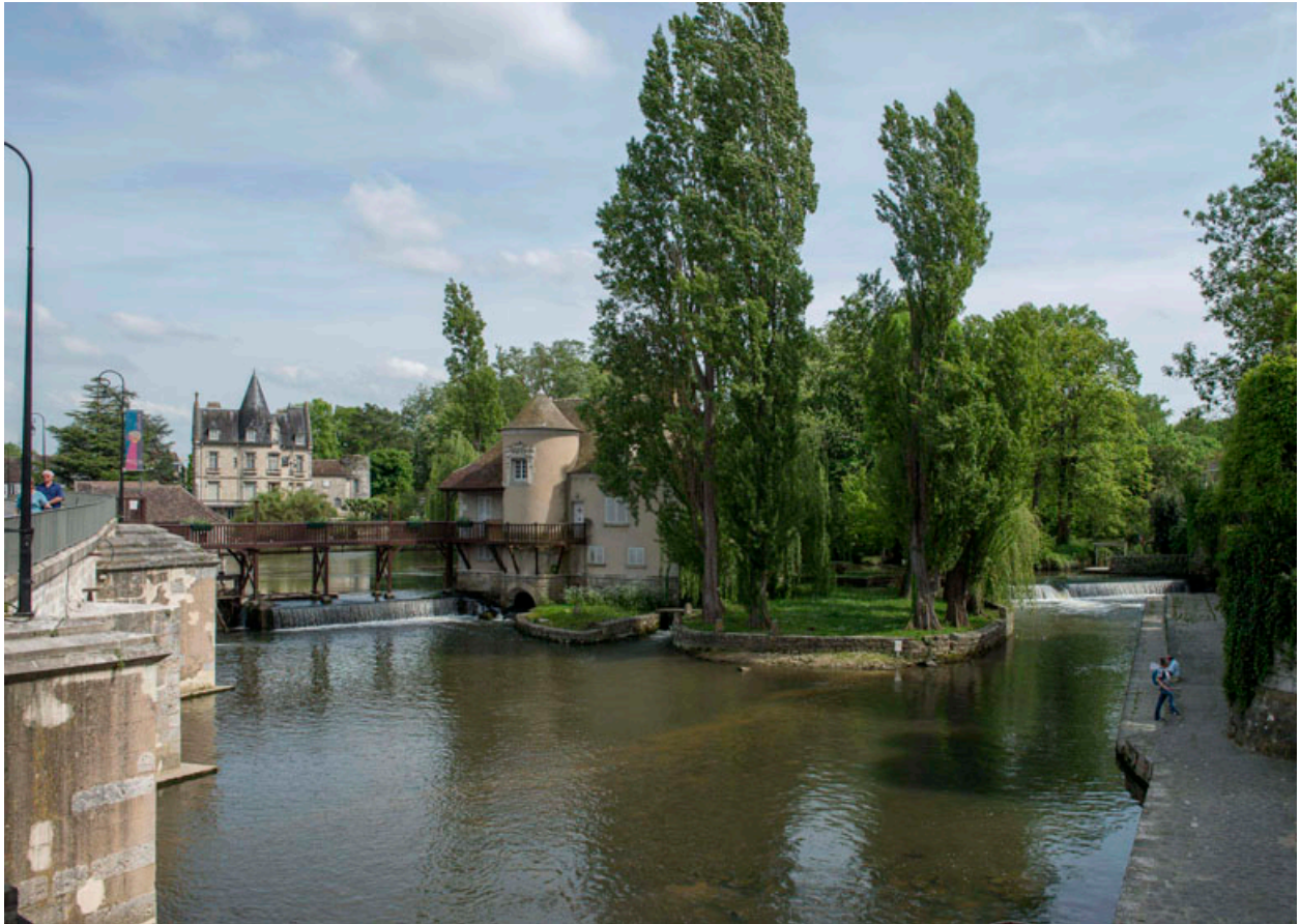
Vue extérieure depuis le pont sur le Loing.
