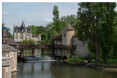
Vue extérieure depuis le pont sur le Loing.
