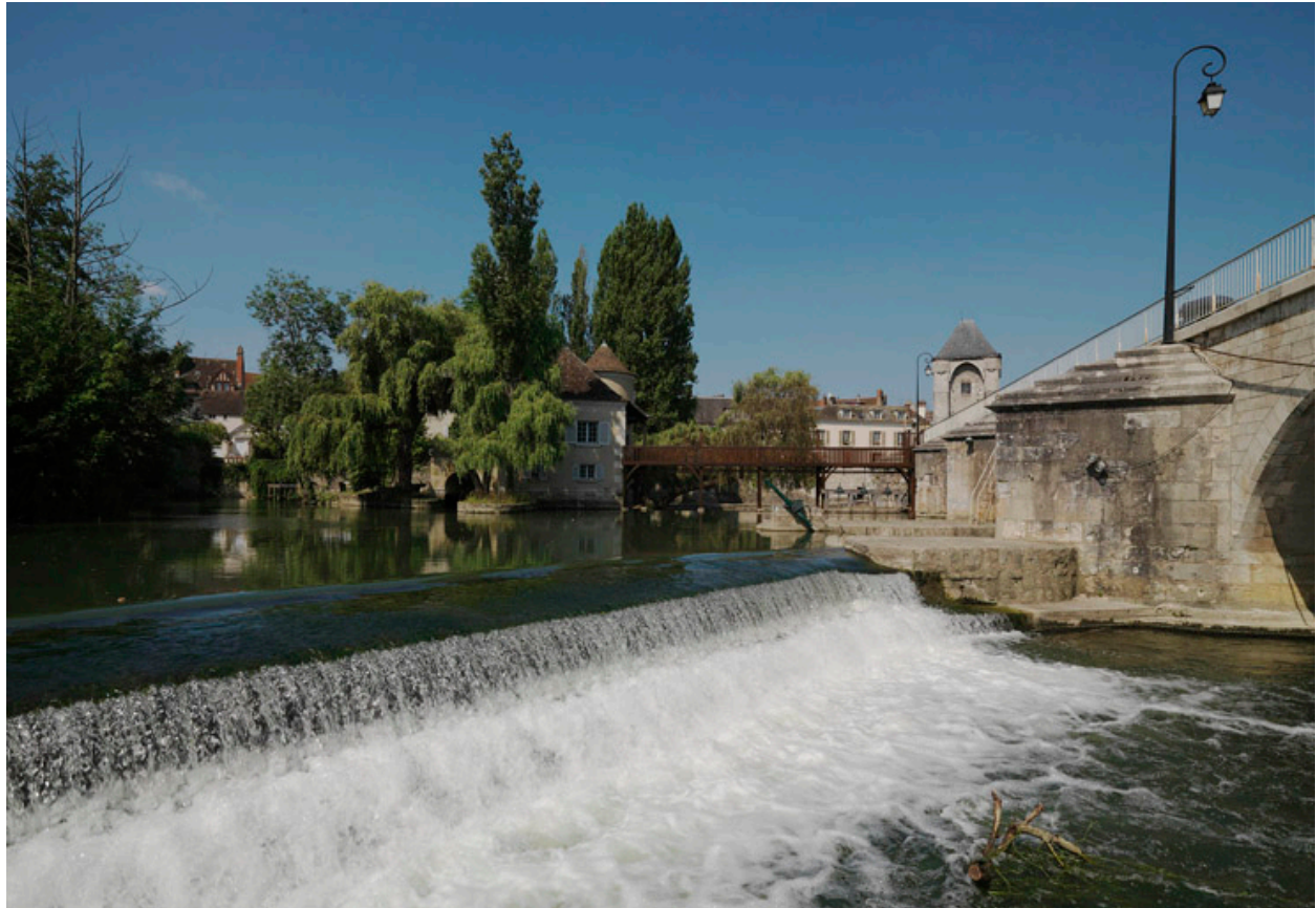
Vue du barrage sur Le Loing.
