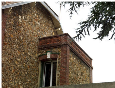
Vue du décor à motifs de tresse du toit terrasse de l'entrée du n°42.
