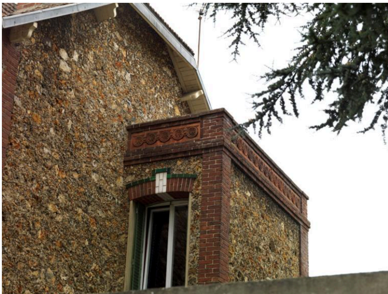
Vue du décor à motifs de tresse du toit terrasse de l'entrée du n°42.
