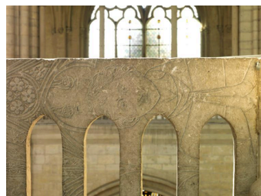
Détail. On reconnaît un clerc en prière. Phot. Laurent Kruszyk IVR11_20177801375NUC4A
