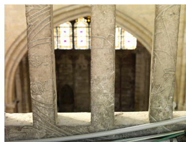
La dalle était double comme le laisse supposer cette partie très découpée. Phot. Laurent Kruszyk IVR11_20177801378NUC4A
