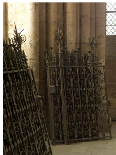
Grilles démontées et entreposées dans la tribune sud. Ce sont les mêmes que celle qui subsistent dans le chœur Phot. Laurent Kruszyk IVR11_20177801283NUC4A
