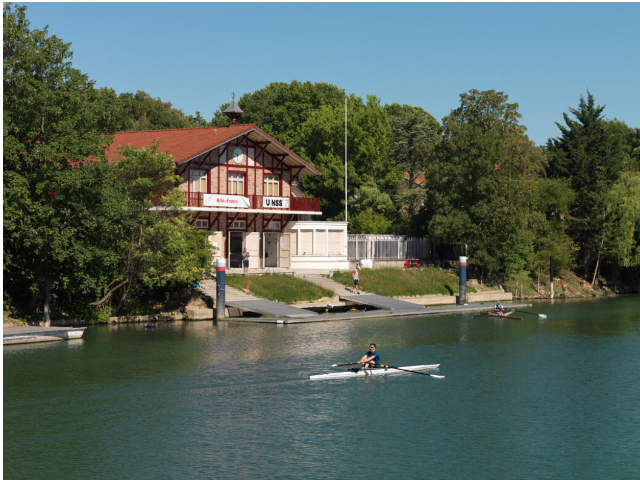
Le club Avirons Marne Joinville, garage à bateaux et club house à Joinville-le-Pont. Vue d'ensemble du boat-house.
