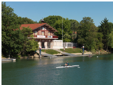
Le club Avirons Marne Joinville, garage à bateaux et club house à Joinville-le-Pont. Vue d'ensemble du boat-house. Phot. Asseline Stéphane IVR11_20209400507NUC4A
