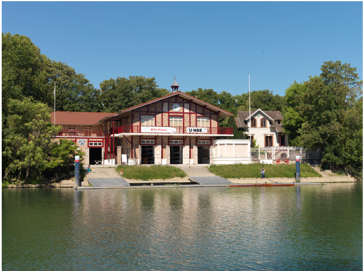
Le club Avirons Marne Joinville, garage à bateaux et club house à Joinville-le-Pont. Vue d'ensemble du boat-house.
