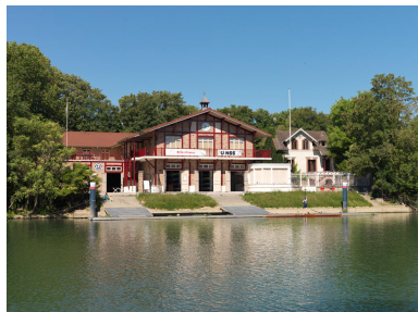
Le club Avirons Marne Joinville, garage à bateaux et club house à Joinville-le-Pont. Vue d'ensemble du boat-house. Phot. Asseline Stéphane IVR11_20209400508NUC4A
