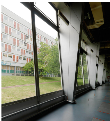
La salle d'escrime (ancienne salle de restaurant) : détail des travées vitrées du mur ouest. Elles donnent sur la Maison du Liban. Restaurant Sud, actuellement édifice sportif dit Espace Sud Phot. Ayrault Philippe IVR11_20117500665NUC4A
