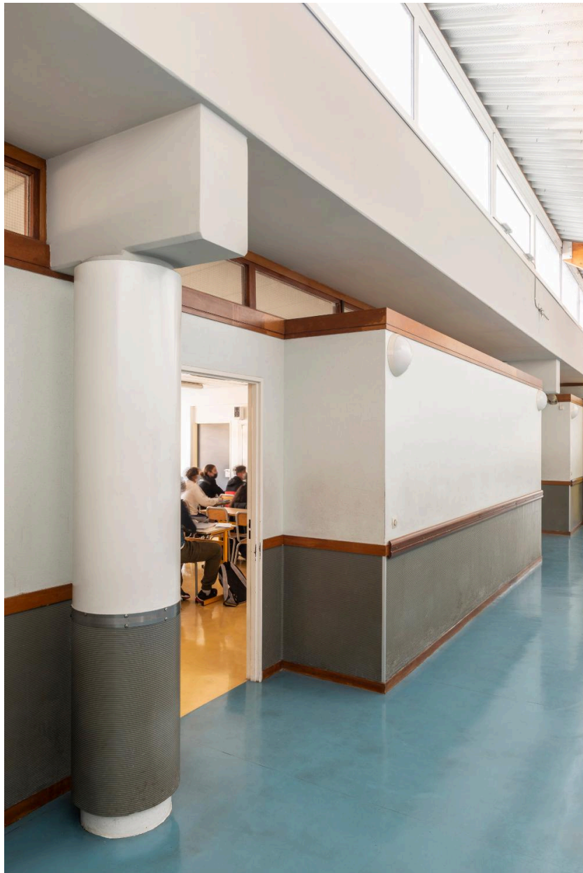
Un couloir avec les impostes qui fournissent aux salles de classes un éclairage de second jour.
