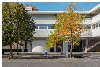
Vue de l'une des ailes enserrant la cour. L'impression d'horizontalité domine, avec les fenêtres en bandeaux. Phot. Laurent Kruszyk IVR11_20209300683NUC4A
