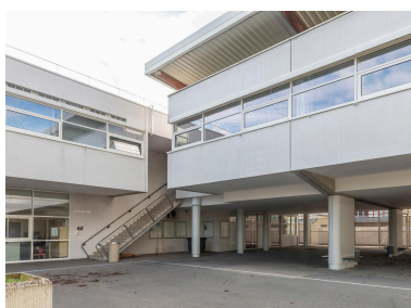
La structure des bâtiments est composée d'un système poteaux-poutres. Phot. Laurent Kruszyk IVR11_20209300687NUC4A
