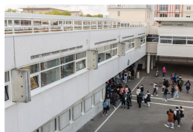
Aux quatre angles se développent les escaliers et les sanitaires. Phot. Laurent Kruszyk IVR11_20209300685NUC4A
