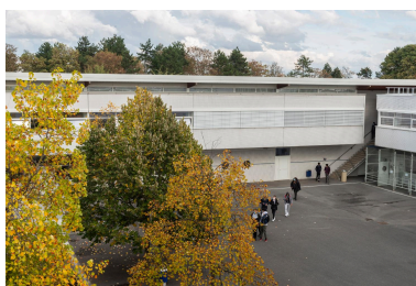
Le plan carré du lycée, très fonctionnel, est bien visible. Phot. Laurent Kruszyk IVR11_20209300684NUC4A
