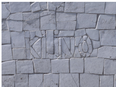
Détail de la mosaïque couvrant le pignon Ouest du gymnase : signature du cartonnier. Phot. Philippe Ayrault IVR11_20059100588XA
