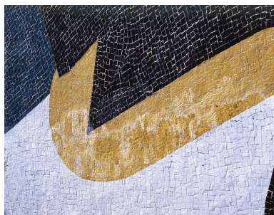
Détail de la mosaïque couvrant le pignon Ouest du gymnase. Phot. Philippe Ayrault IVR11_20059100584XA
