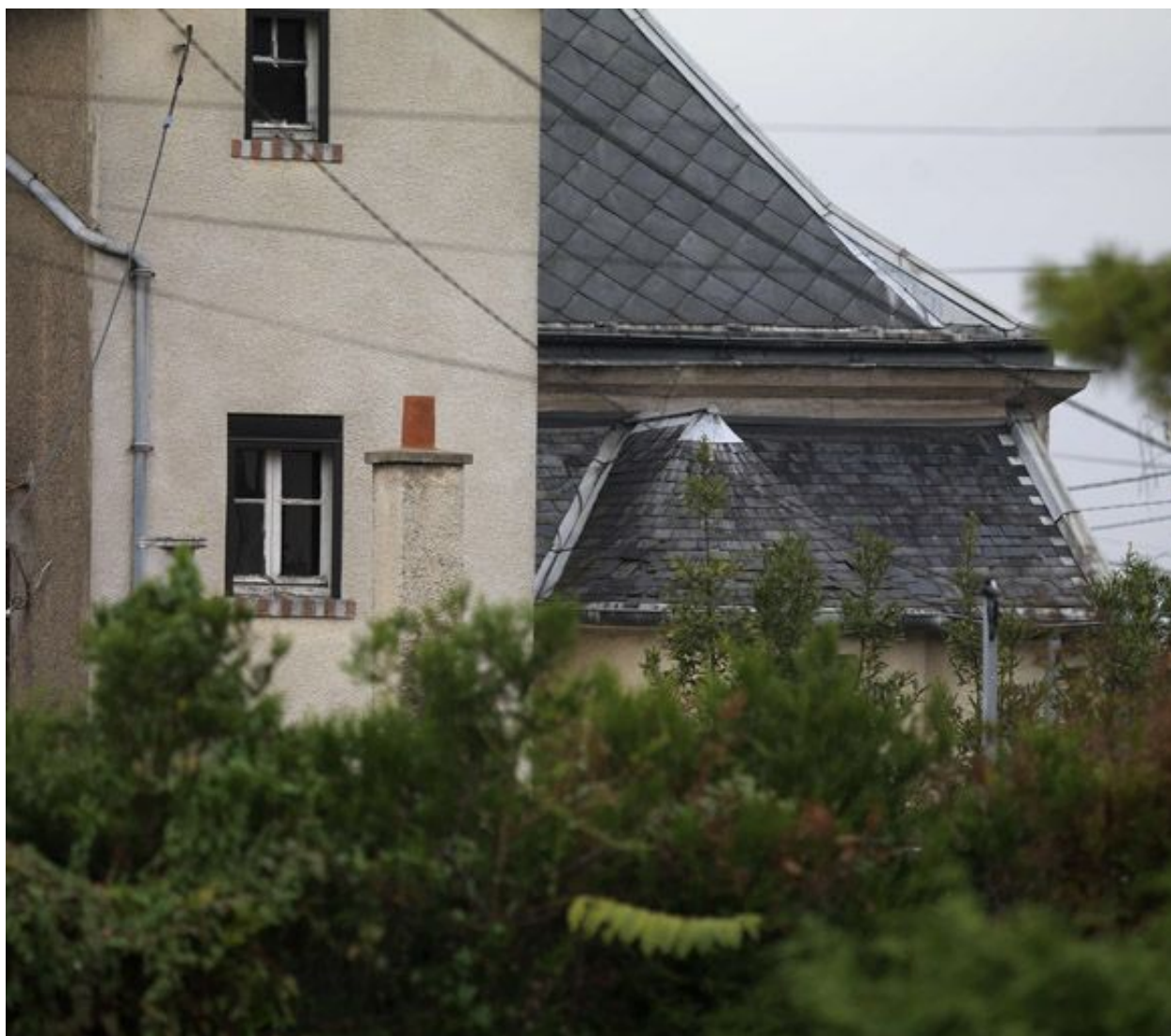
Vue de la tour en poivrière et d'une partie de la toiture sur la façade sud de la partie orientale de l'ancien château.
