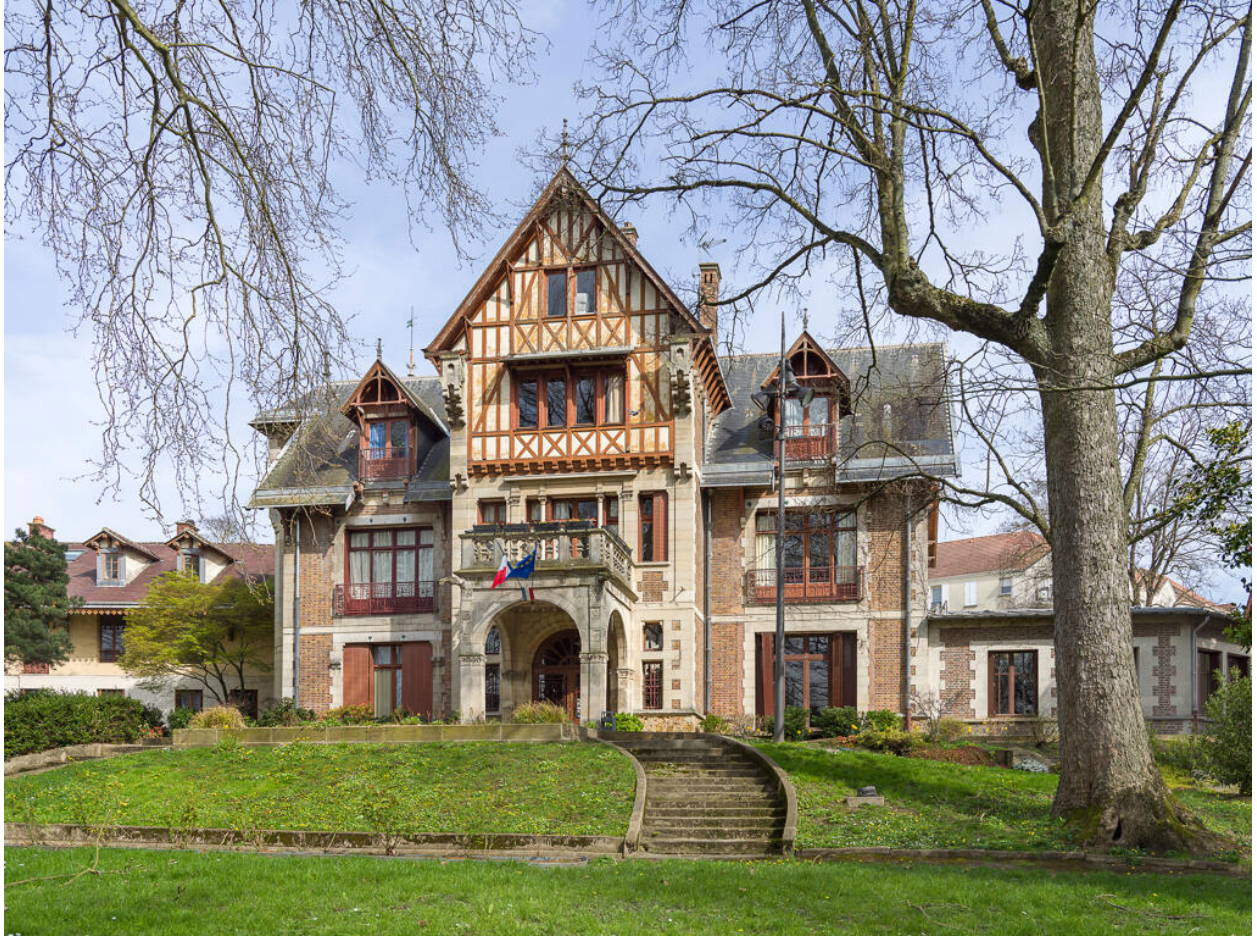
Vue d'ensemble de la façade principale, flanquée à droite d'une extension moderne d'un seul niveau, et à gauche d'une aile latérale qui accueillait les cuisines au rez-de-chaussée.
