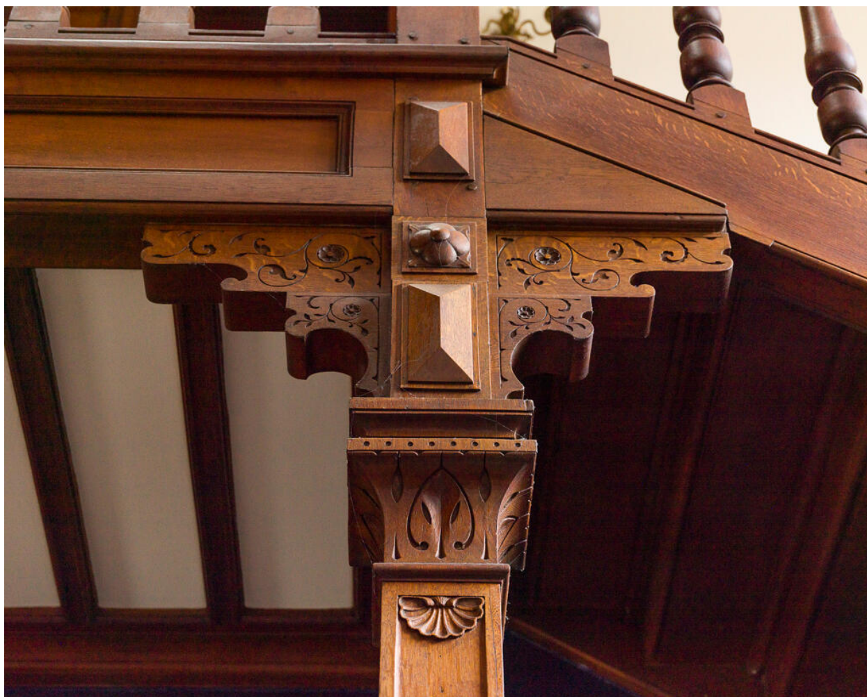
Assemblage de colonne de la coursive, au rez-de-chaussée.
