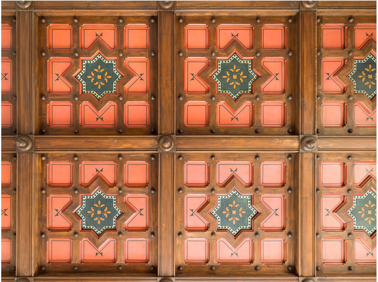
Détail du plafond à caissons de l'appartement sud, au premier étage.
