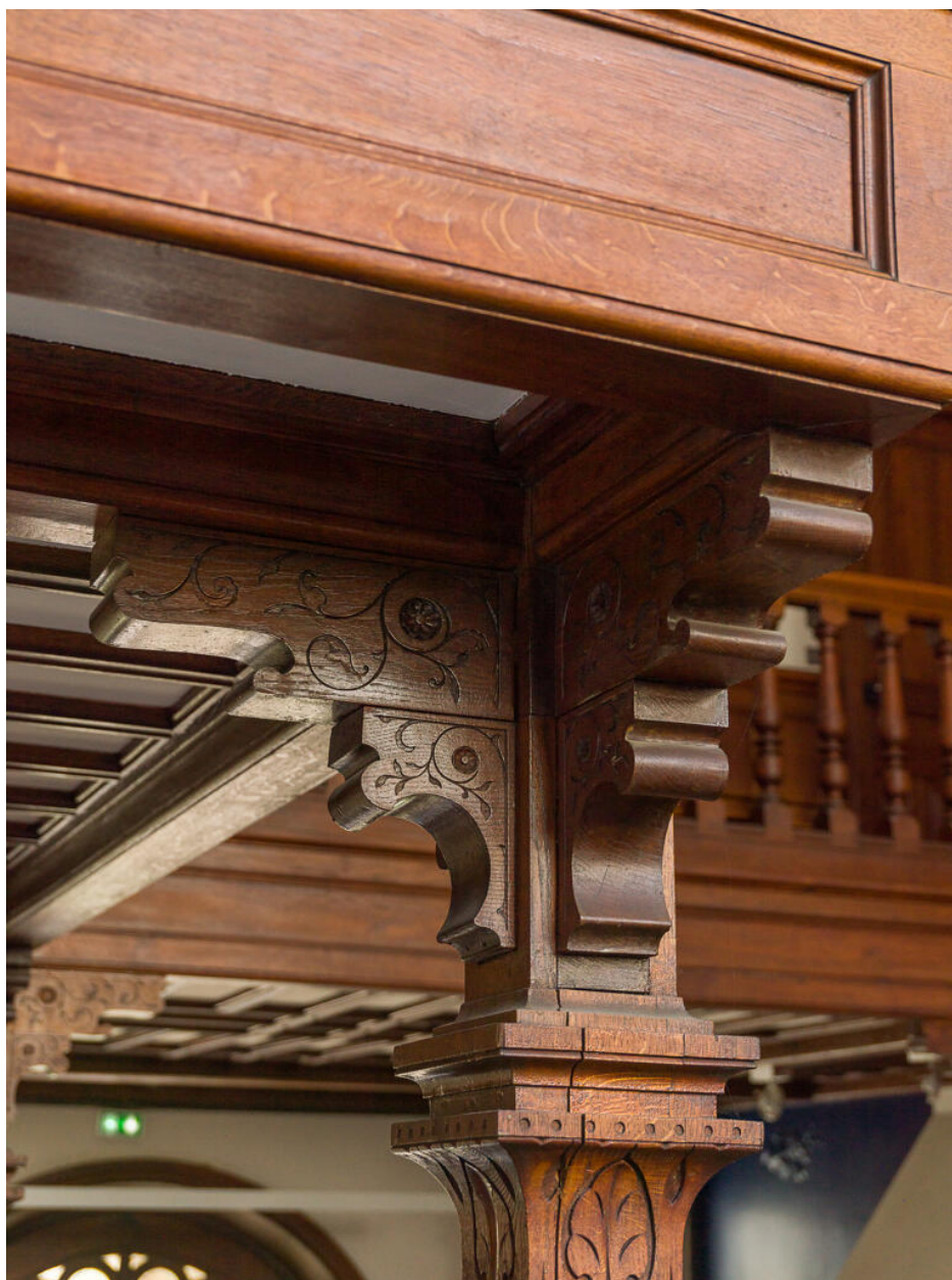
Assemblage de colonne de la coursive, au rez-de-chaussée.
