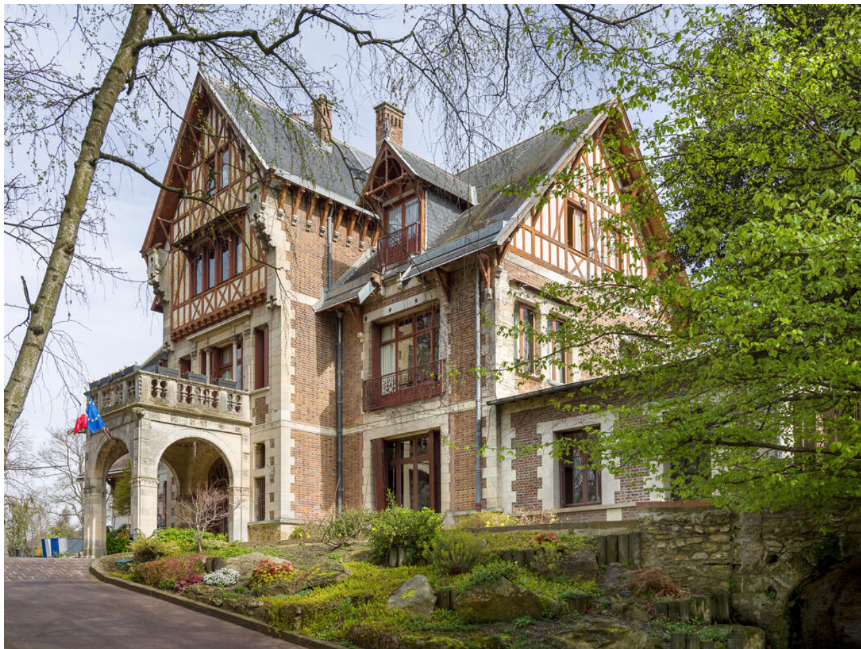
Façades ouest et sud.
