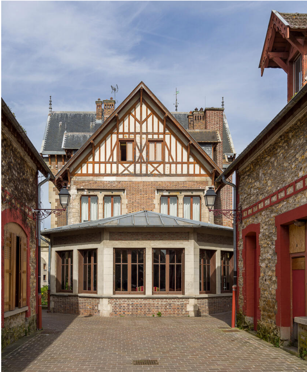
La façade sud, et son extension, vue depuis la cour des communs.
