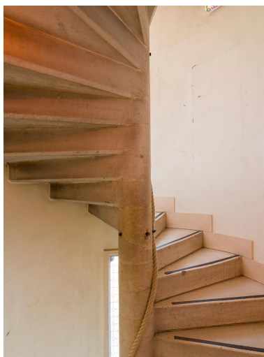
L'escalier à vis dans la tourelle. Phot. Asseline Stéphane IVR11_20249500037NUC4A
