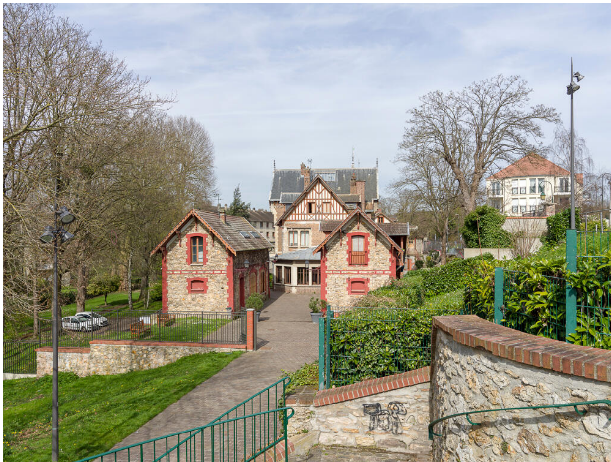
Vue générale depuis les communs, au sud est de la propriété. La forte déclivité du terrain est ici bien visible.
