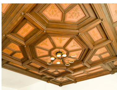
Détail du plafond à caissons de l'appartement nord, au premier étage. Phot. Asseline Stéphane IVR11_20249500043NUC4A
