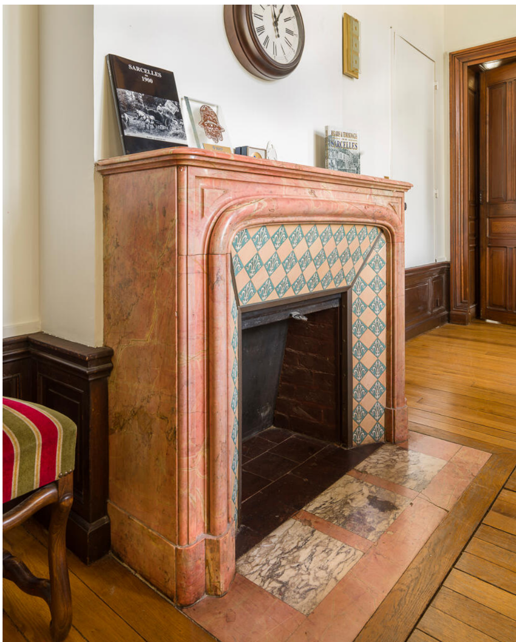
Détail de la cheminée du salon de transition entre les deux appartements, premier étage, côté ouest.
