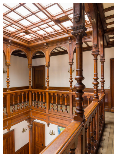
Deuxième niveau de la coursive. On aperçoit la verrière à charpente métallique. Phot. Asseline Stéphane IVR11_20249500024NUC4A
