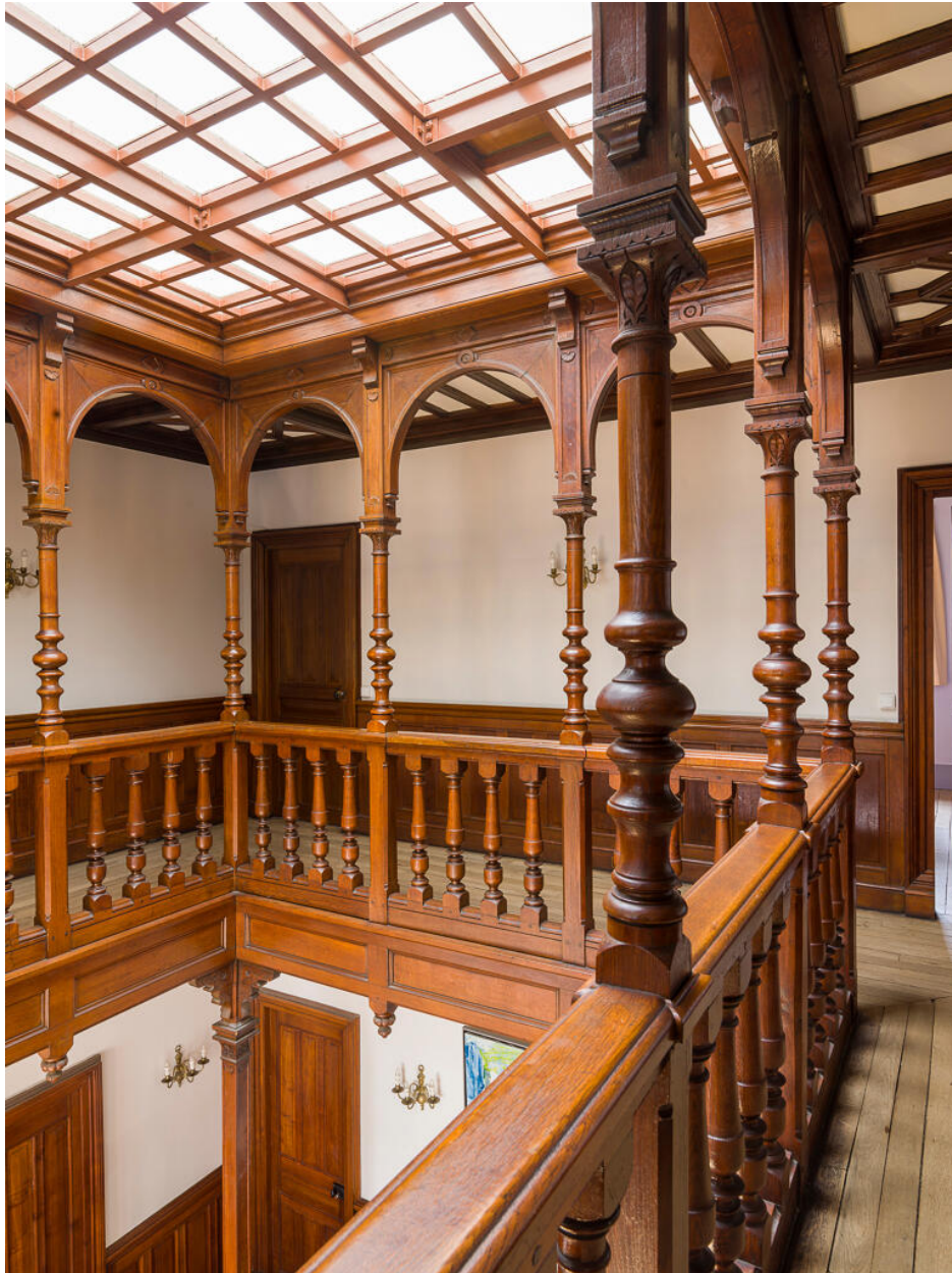
Deuxième niveau de la coursive. On aperçoit la verrière à charpente métallique.
