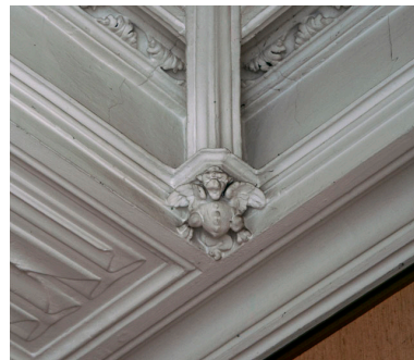
Salon du rez-de-chaussée, donnant sur le lac ; détail du plafond à caissons : les petits culots amortissant les angles sont ornés d'animaux fantastiques appartenant au répertoire ornemental néogothique, ici une harpie. Phot. Jean-Bernard Vialles IVR11_20069500106XA
