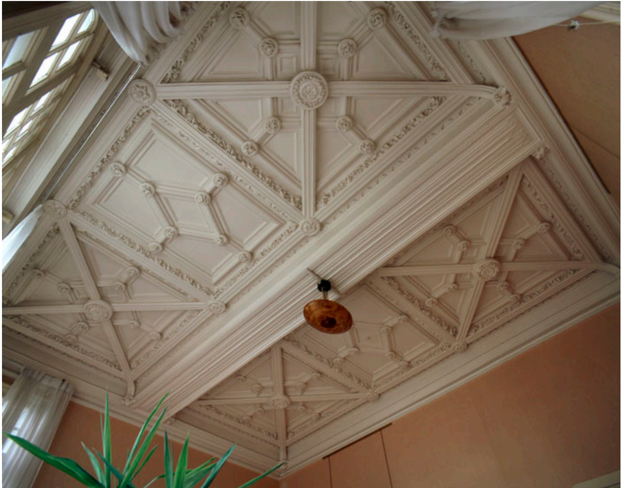
Salle à manger au rez-de-chaussée : vue d'ensemble du plafond.
