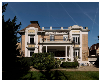
Vue d'ensemble depuis le jardin. Phot. Jean-Bernard Vialles IVR11_20099500505NUC4A
