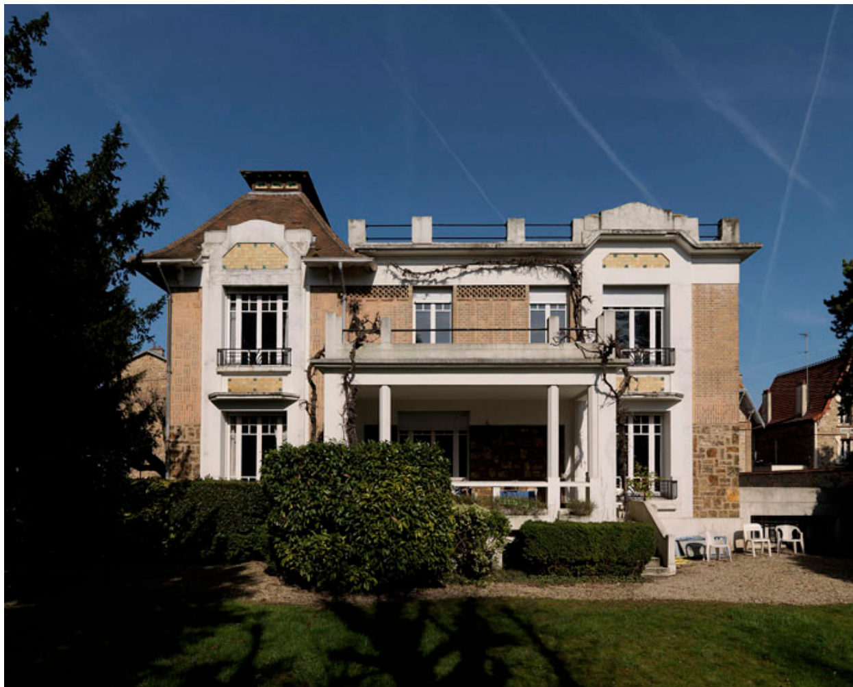
Vue d'ensemble depuis le jardin.
