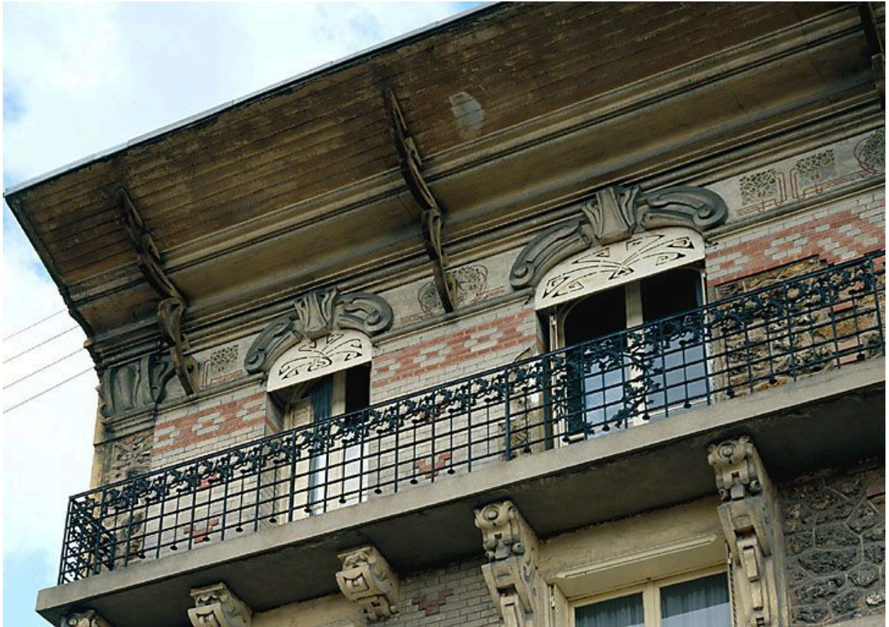
Demier étage et toit débordant de la façade antérieure; balcon.
