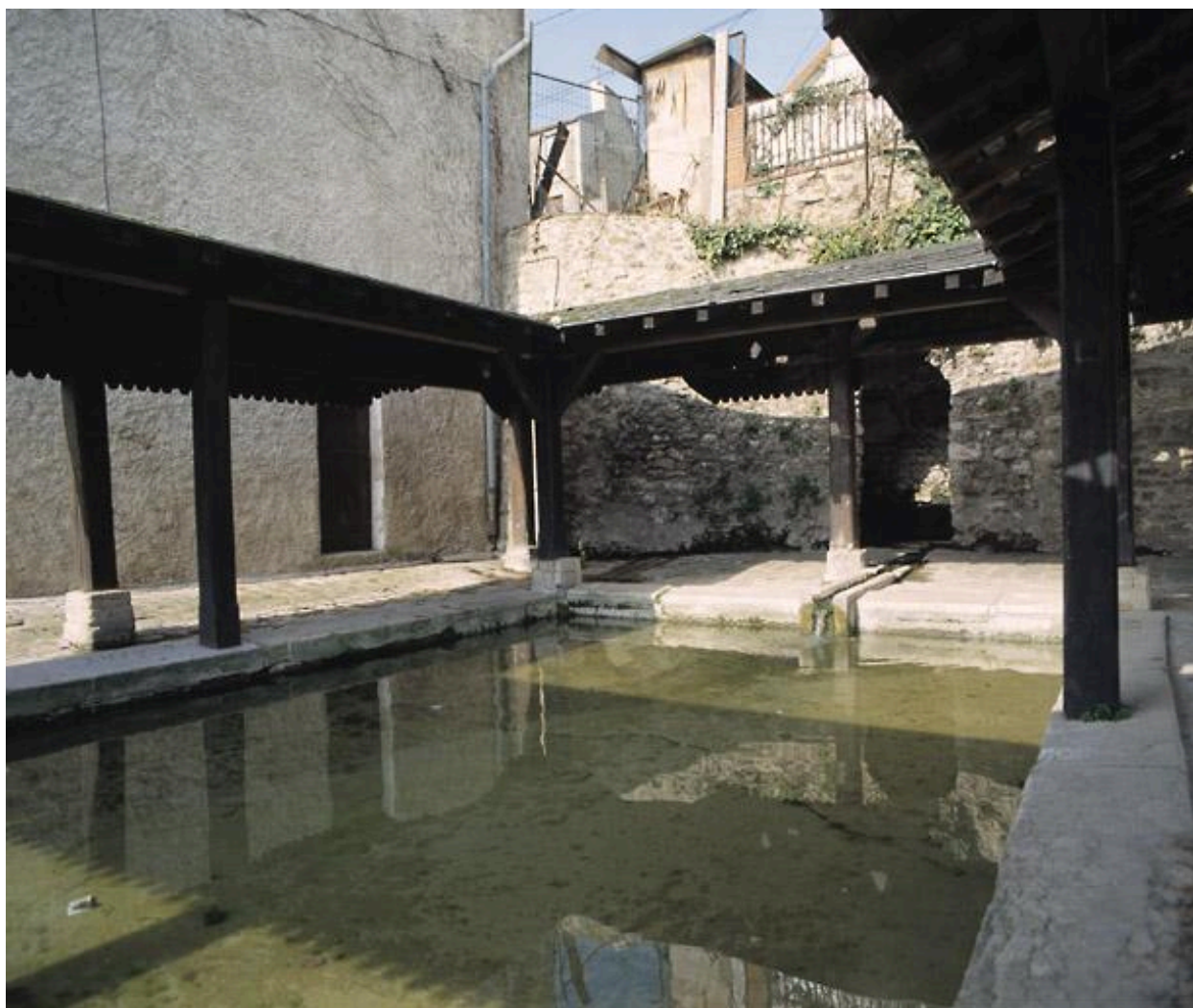
Vue du bassin.
