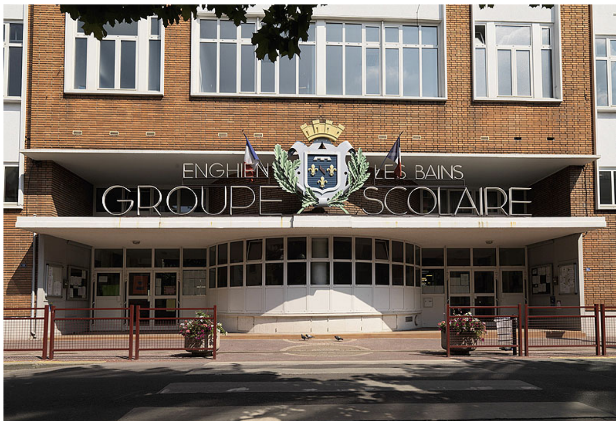
Détail de l'entrée du bâtiment donnant sur le boulevard d'Ormesson.
