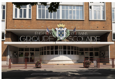
Détail de l'entrée du bâtiment donnant sur le boulevard d'Ormesson. Phot. Jean-Bernard Vialles IVR11_20089500384NUC4A
