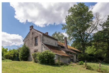
Corps de logis, façade postérieure (nord) et façade est Phot. Laurent Kruszyk IVR11_20227800217NUC4A
