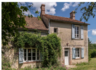
Corps de logis, façade principale, côté rue, orientée sud Phot. Laurent Kruszyk IVR11_20227800211NUC4A
