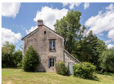
Corps de logis, façade est Phot. Laurent Kruszyk IVR11_20227800218NUC4A
