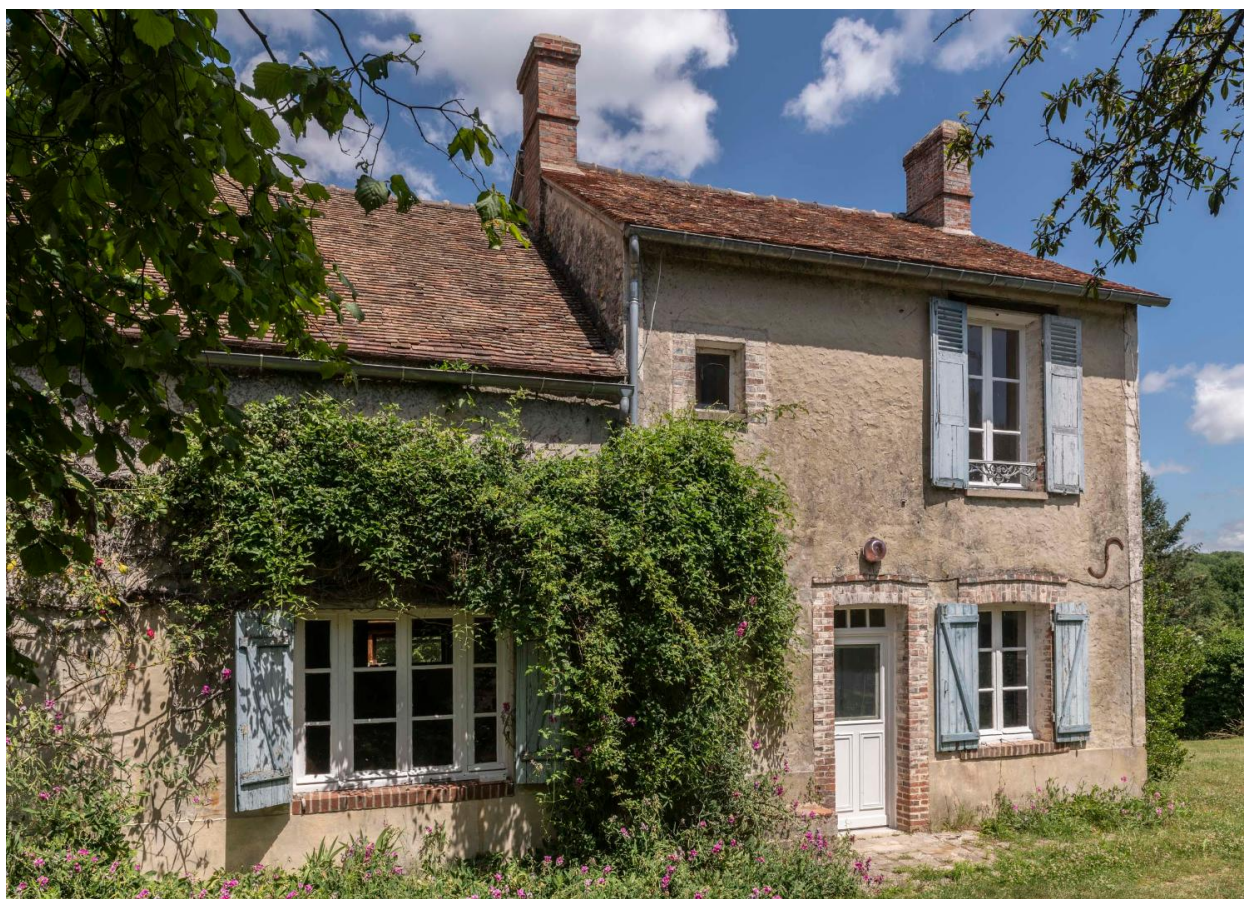
Corps de logis, façade principale, côté rue, orientée sud
