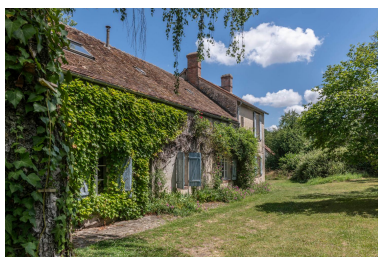
Corps de logis, façade principale côté rue Phot. Laurent Kruszyk IVR11_20227800215NUC4A
