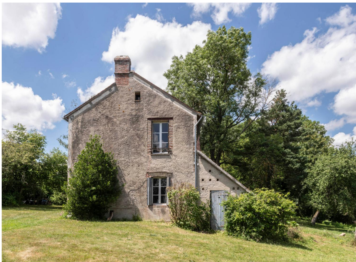
Corps de logis, façade est
