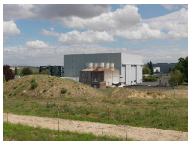
Hall C27 construit en 1981 pour abriter les boucles d'essais de centrales REP (Réacteur eau pressurisée). Début de l'émancipation vis-a-vis de la charte esthétique originelle des Renardières.
