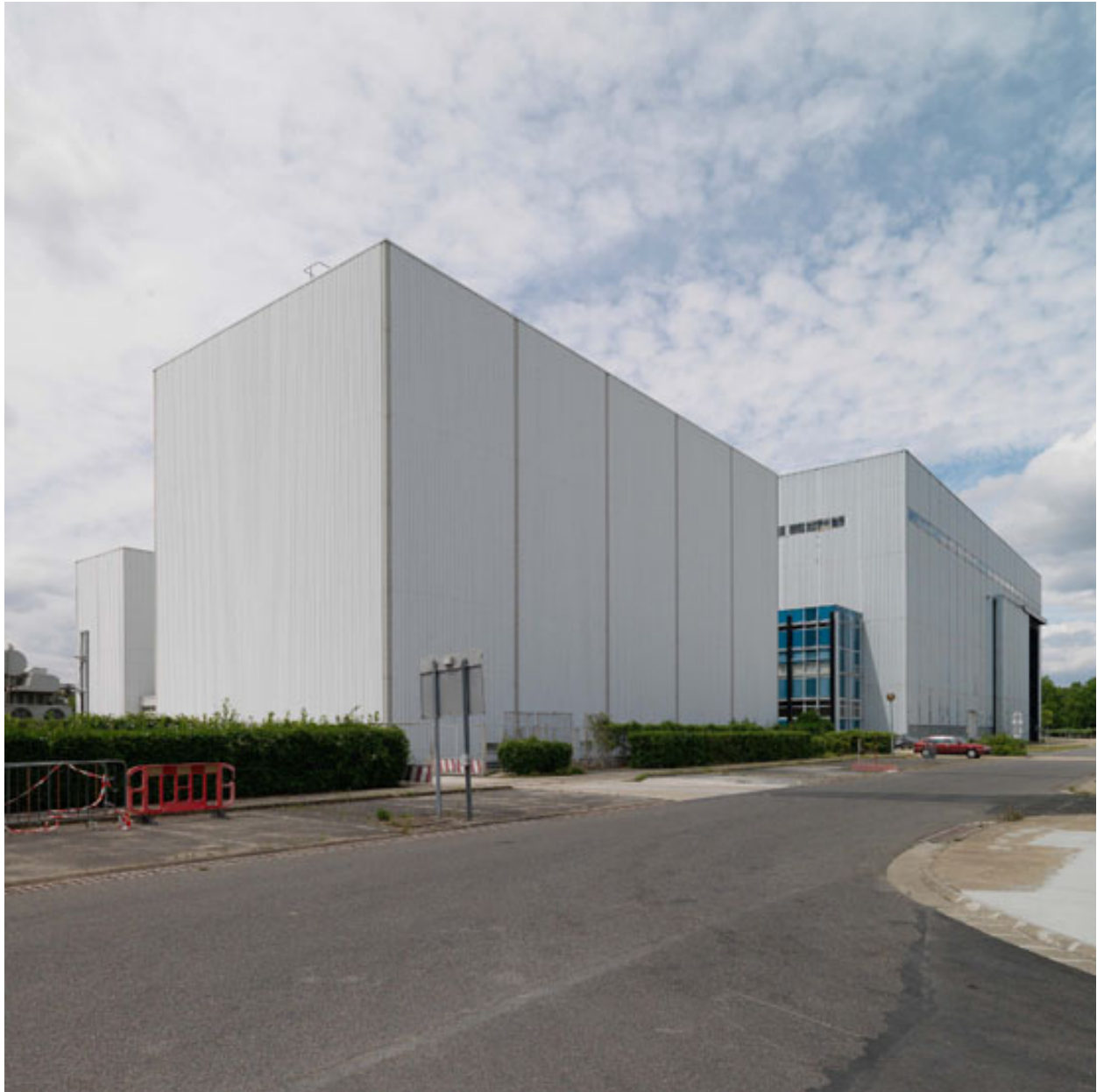
Le LEHT (Laboratoire d'essais haute tension) en bardage clair avec un module de bureaux bleu a deux étages.
