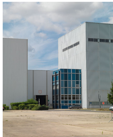
Le LEHT (Laboratoire d'essais haute tension) en bardage clair avec un module de bureaux bleu a deux étages.
