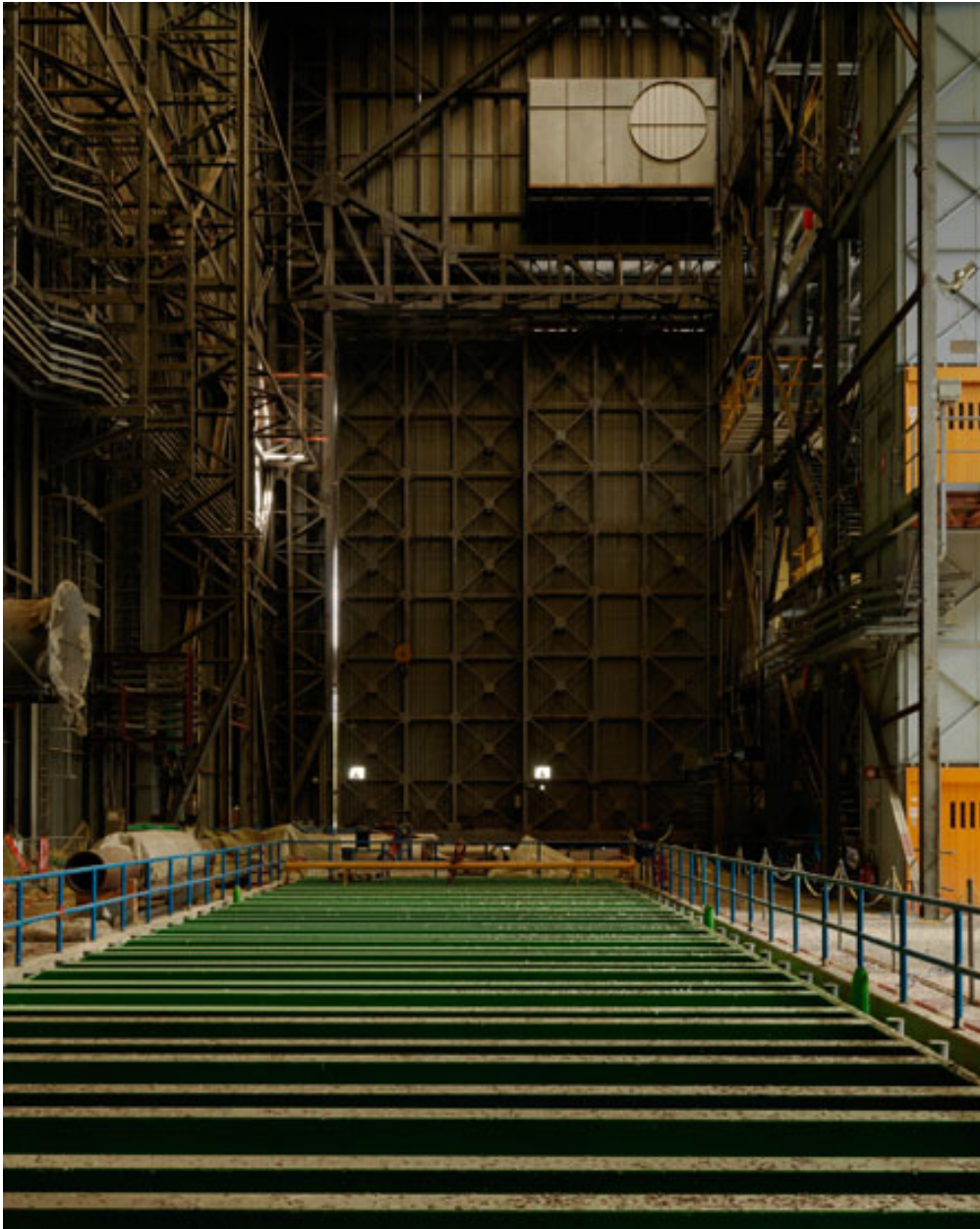
Intérieur du Hall CGVS (Circuit d'essais de Générateurs de Vapeur chauffés au Sodium).
