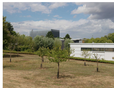
Traitement paysager du site des Renardières. De droite à gauche : un Laboratoire d'essais classique blanc de type Prouvé, le nouveau bâtiment MAI (Materials Ageing Institut) et en arrière-plan le Hall CGVS (Circuit d'essais de Générateurs de Vapeur chauffés au Sodium). Phot. Philippe Ayrault IVR11_20117700805NUC4A
