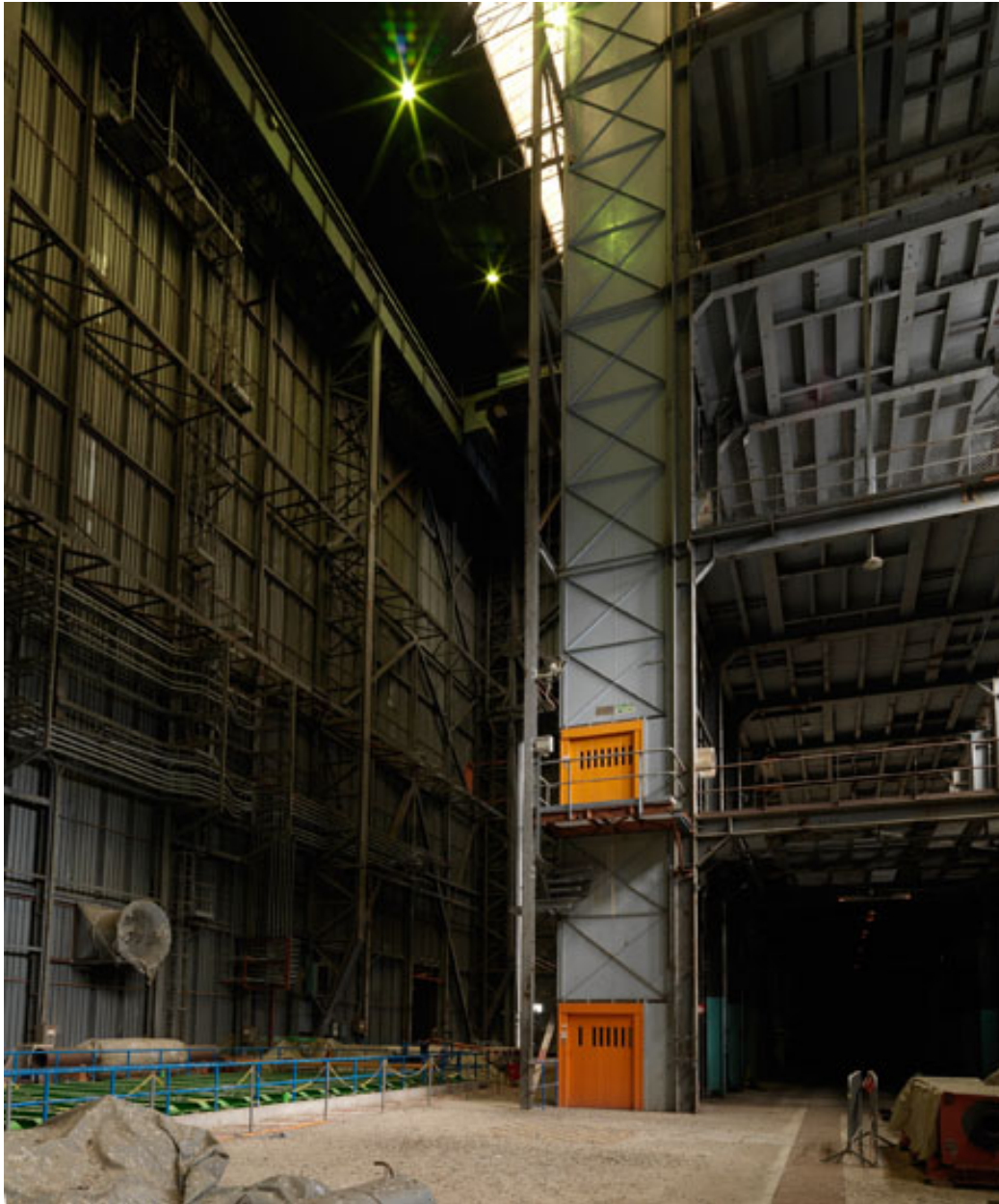
Intérieur du Hall CGVS (Circuit d'essais de Générateurs de Vapeur chauffés au Sodium). Monte-charges.
