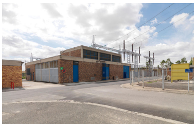
Constructions en briques pour la logistique aux abords de la charpente électrique extérieure.
