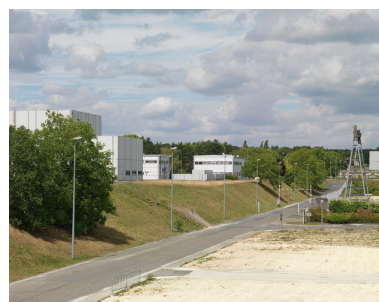
Ensemble construit entre 1981 et 1995 ( ?) constitué de laboratoires d'essais blancs et de halls de seconde génération. Département CIMA (Câbles, condensateurs, Isolants, Matériels d'Automatisme).
