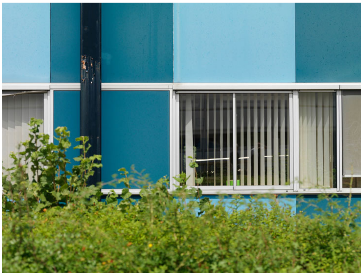
Bâtiment de bureaux bleu. Etat d'origine. Détail façade.
