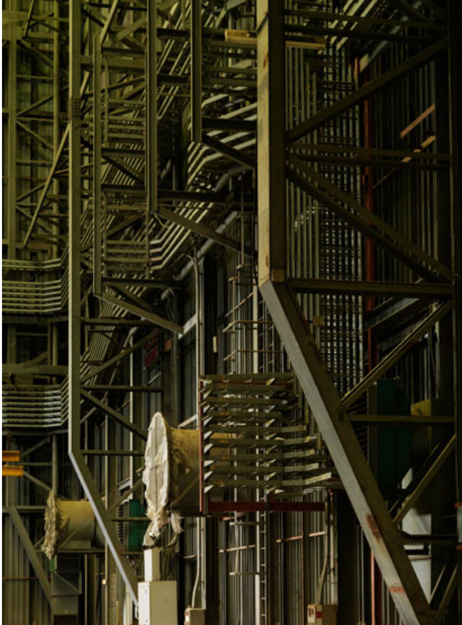
Intérieur du Hall CGVS (Circuit d'essais de Générateurs de Vapeur chauffés au Sodium).
