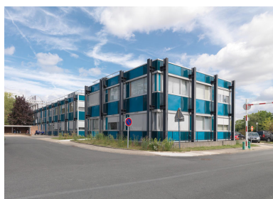
Bâtiments de bureaux bleus a un étage. Etat d'origine. En arriere-plan la charpente électrique extérieure. Département LEP (Laboratoire d'essais de puissance).
