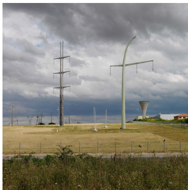
Paysage aux abords du site des Renardières. Pylônes et lignes d'alimentation. Phot. Philippe Ayrault IVR11_20117700888NUC4A
