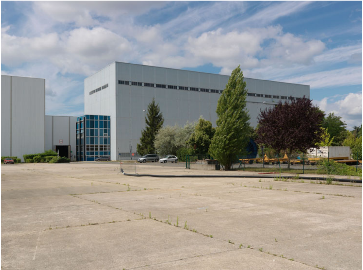
Le LEHT (Laboratoire d'essais haute tension) en bardage clair avec un module de bureaux bleu a deux étages.
