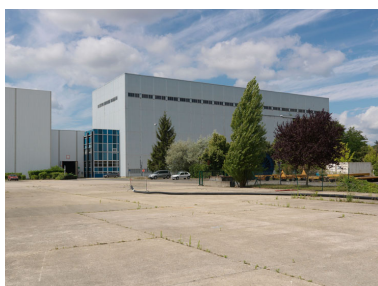
Le LEHT (Laboratoire d'essais haute tension) en bardage clair avec un module de bureaux bleu à deux étages. Phot. Philippe Ayrault IVR11_20117700840NUC4A
