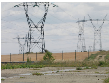
Paysage aux abords du site des Renardières. Pylônes et lignes d'alimentation. Phot. Philippe Ayrault IVR11_20117700886NUC4A
