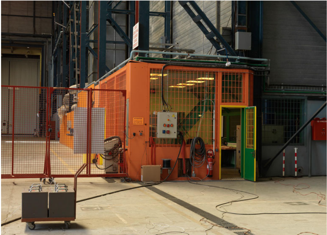
Intérieur du Hall d'essais synthétiques. Postes de commande.
