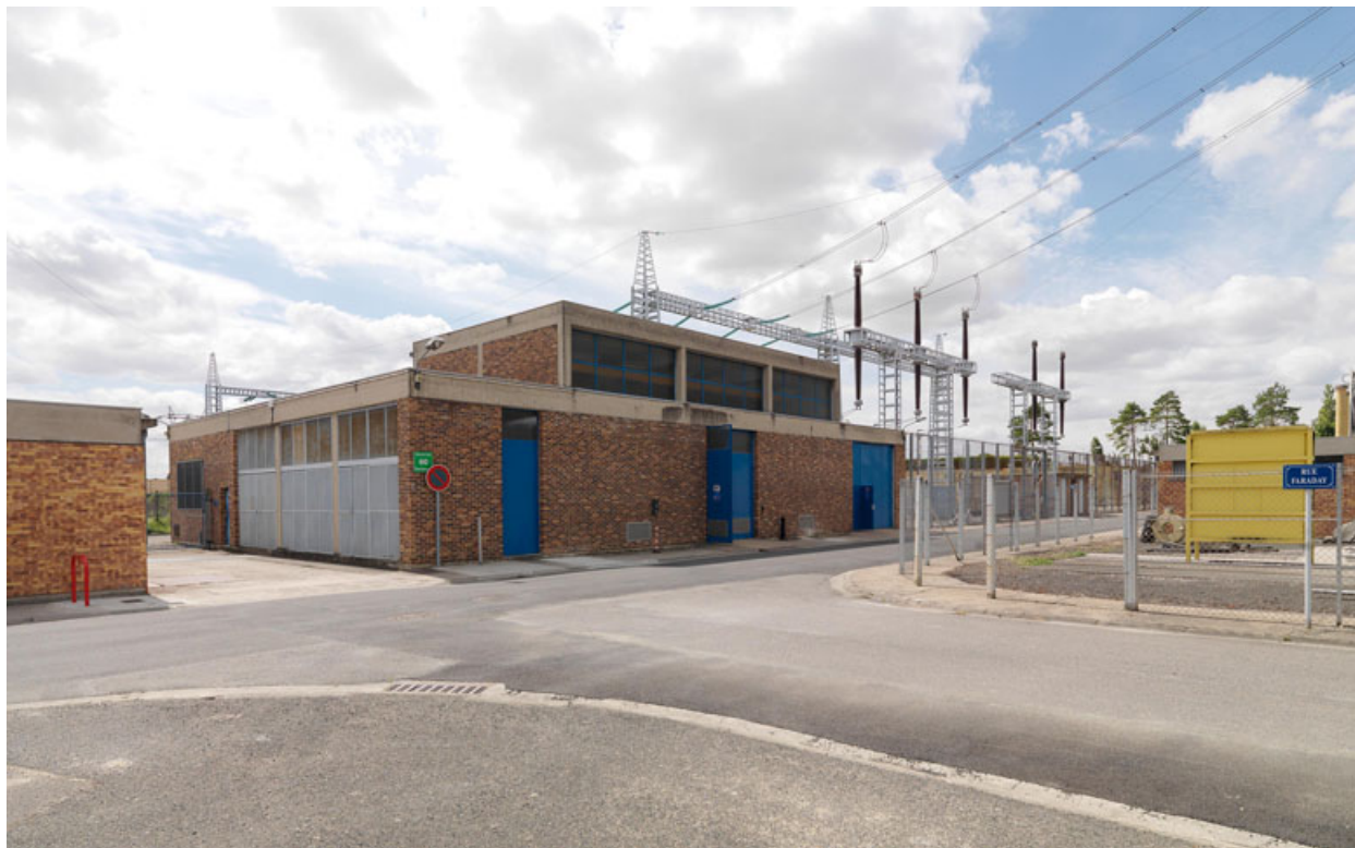
Constructions en briques pour la logistique aux abords de la charpente électrique extérieure.
