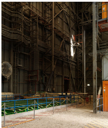
Intérieur du Hall CGVS (Circuit d'essais de Générateurs de Vapeur chauffés au Sodium). Phot. Philippe Ayrault IVR11_20117700813NUC4A
