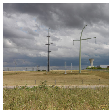
Paysage aux abords du site des Renardières. Pylônes et lignes d'alimentation.
