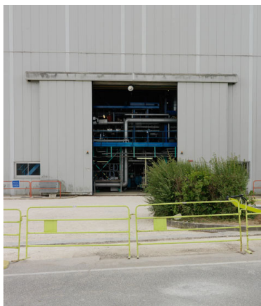
Hall C27 construit en 1981 pour abriter les boucles d'essais de centrales REP (Réacteur eau pressurisée). Début de l'émancipation vis-a-vis de la charte esthétique originelle des Renardières. Phot. Philippe Ayrault IVR11_20117700780NUC4A
