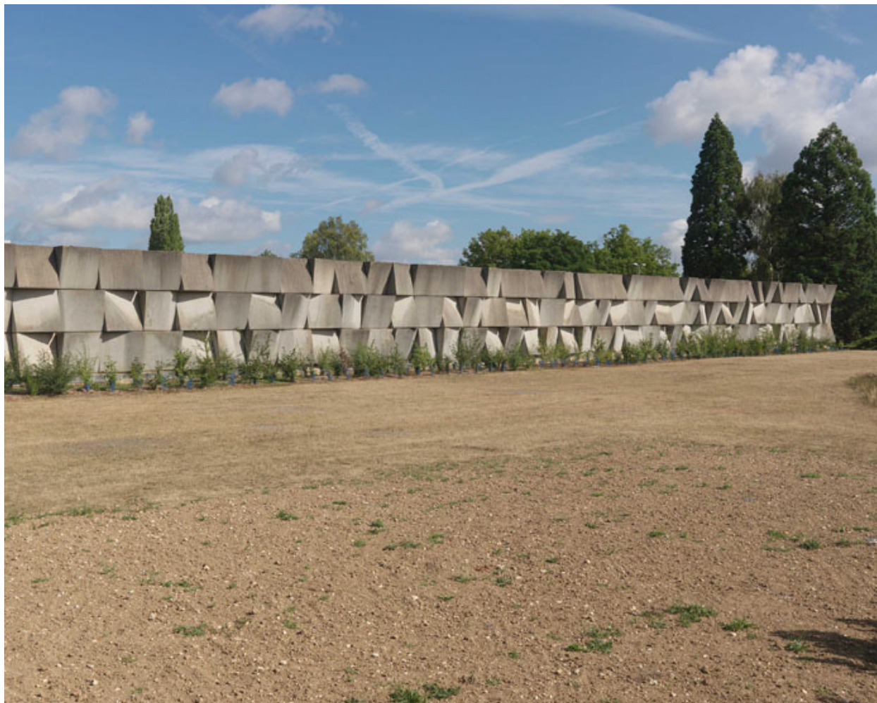
Le mur décoratif d'Etienne Martin a l'entrée du site pour dissimuler des bâtiments techniques.
