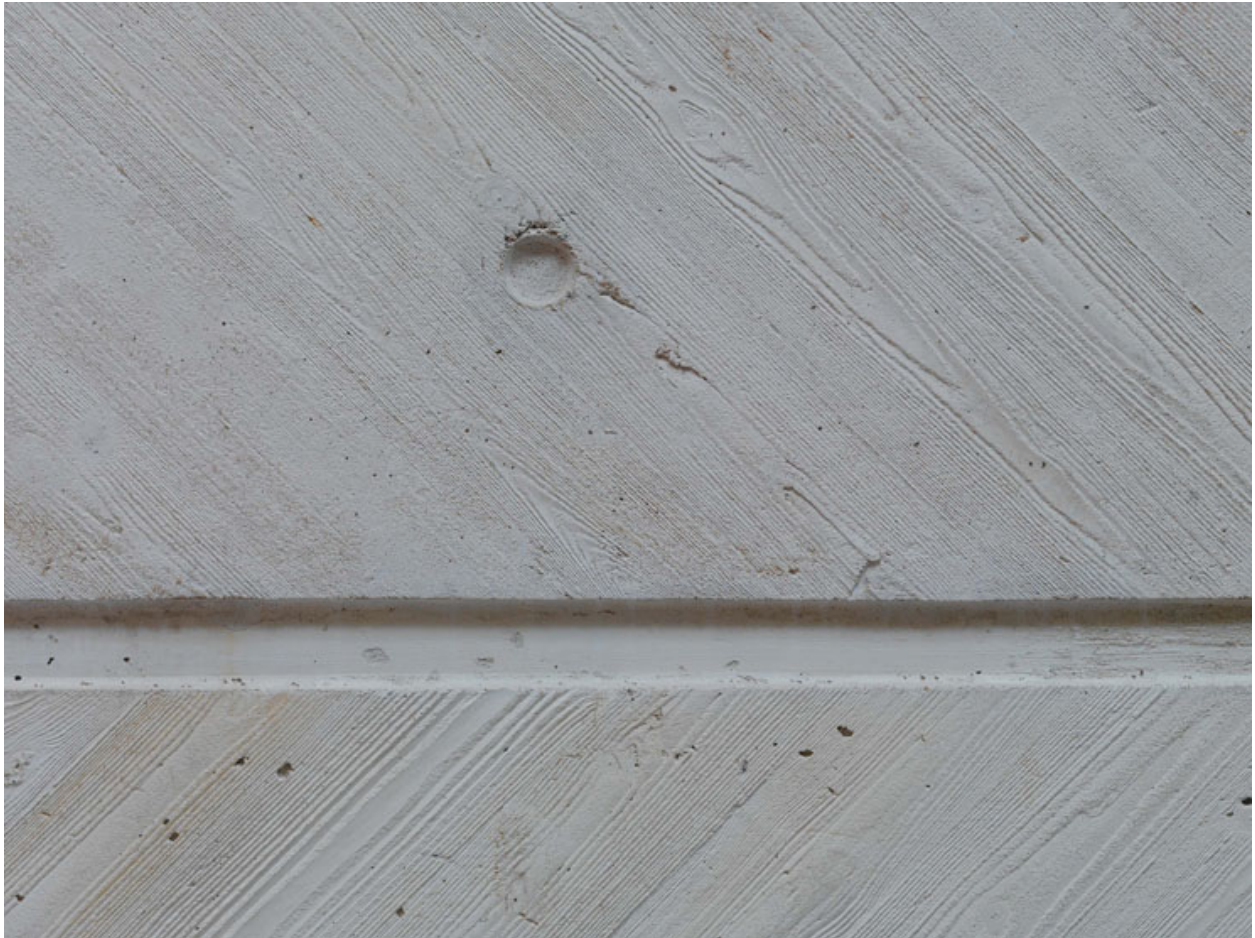
Restaurant infirmerie du site des Renardières. Vue intérieure de la cage d'escalier. Traitement des matériaux.
