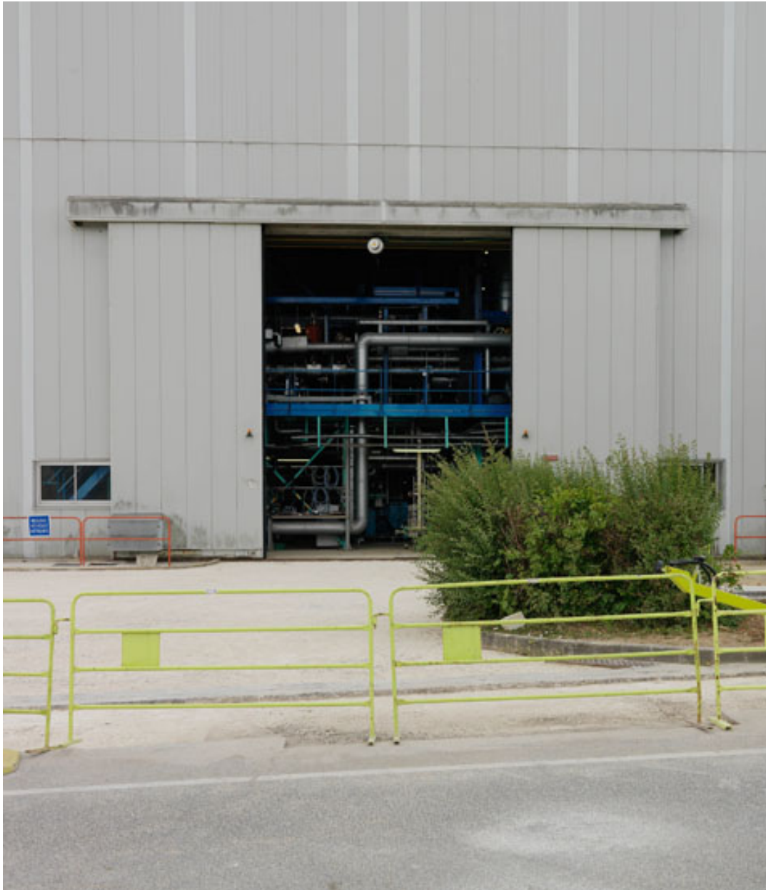
Hall C27 construit en 1981 pour abriter les boucles d'essais de centrales REP (Réacteur eau pressurisée). Début de l'émancipation vis-a-vis de la charte esthétique originelle des Renardières.
