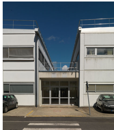
Liaison de deux laboratoires d'essais classiques blancs de type Prouvé par galerie basse. Phot. Philippe Ayrault IVR11_20117700754NUC4A
