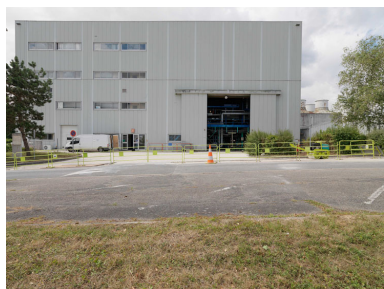
Hall C27 construit en 1981 pour abriter les boucles d'essais de centrales REP (Réacteur eau pressurisée). Début de l'émancipation vis-a-vis de la charte esthétique originelle des Renardières. Phot. Philippe Ayrault IVR11_20117700779NUC4A
