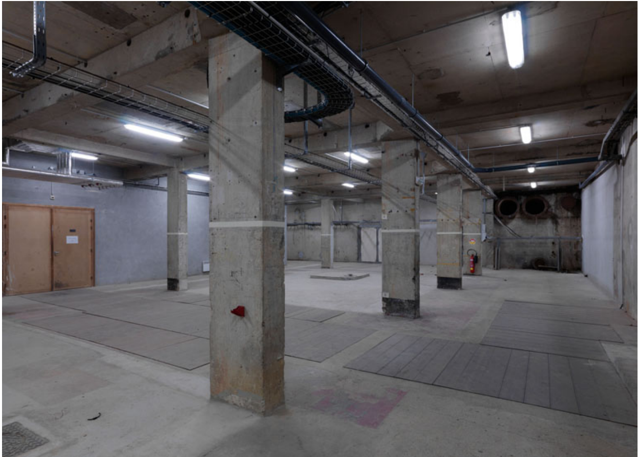
Sous-sol du Hall CGVS (Circuit d'essais de Générateurs de Vapeur chauffés au Sodium).
