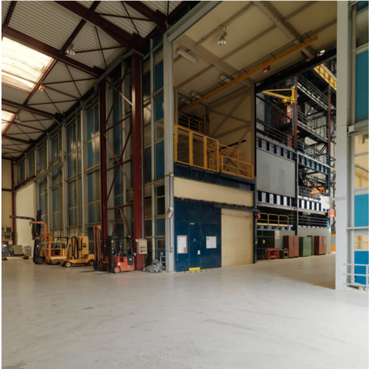
Intérieur du Hall d'essais synthétiques en bardage gris.
