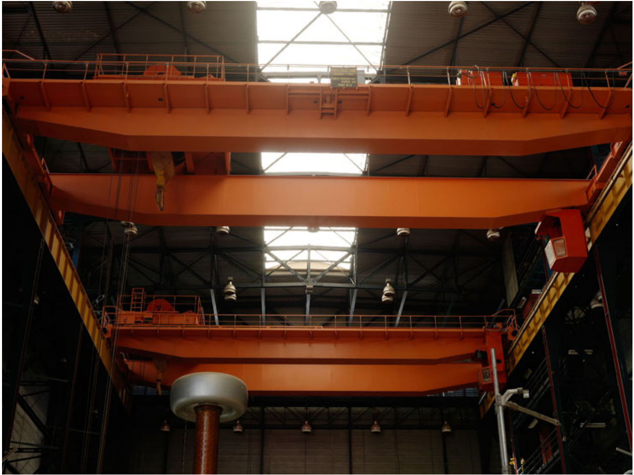
Intérieur du Hall d'essais synthétiques. Ponts roulants.
