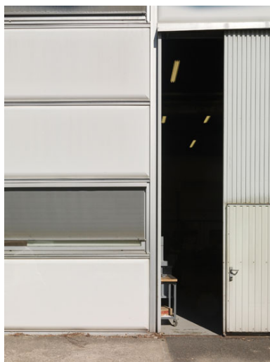
Détail de façade d'un laboratoire d'essais classique blanc de type Prouvé au niveau d'une grande porte, état d'origine. Phot. Philippe Ayrault IVR11_20117700755NUC4A
