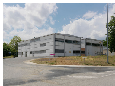
Deux laboratoires d'essais classiques blancs de type Prouvé couplés. Département ADE (Application de d'électricité). Phot. Philippe Ayrault IVR11_20117700793NUC4A
