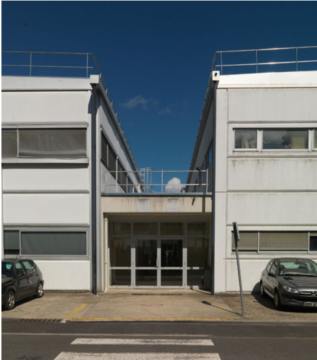
Liaison de deux laboratoires d'essais classiques blancs de type Prouvé par galerie basse.
