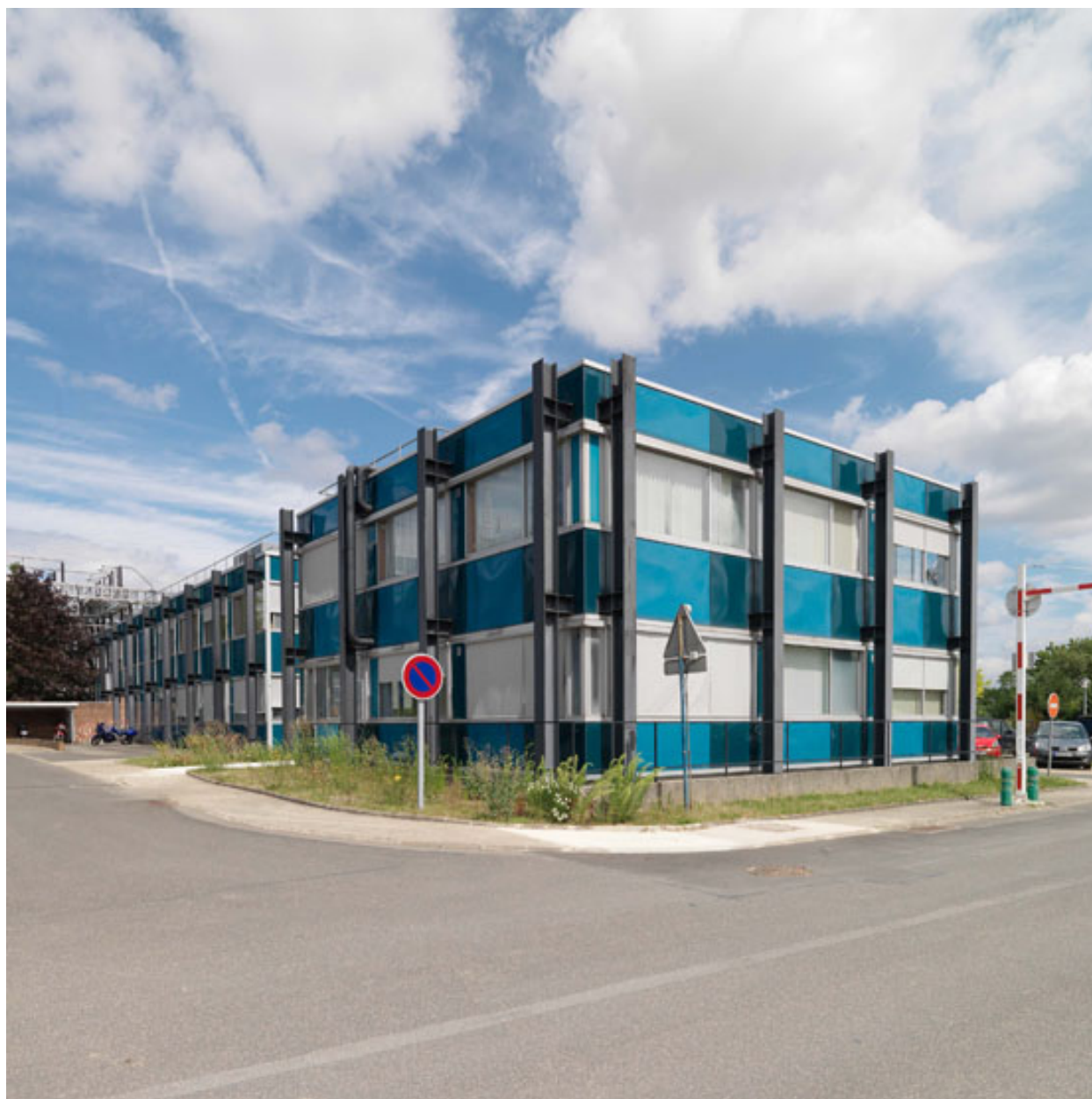
Bâtiments de bureaux bleus à un étage. Etat d'origine. En arriere-plan la charpente électrique extérieure. Département LEP (Laboratoire d'essais de puissance).
