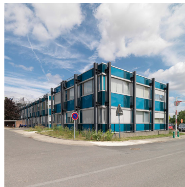
Bâtiments de bureaux bleus à un étage. Etat d'origine. En arrière-plan la charpente électrique extérieure. Département LEP (Laboratoire d'essais de puissance). Phot. Philippe Ayrault IVR11_20117700894NUC4A
