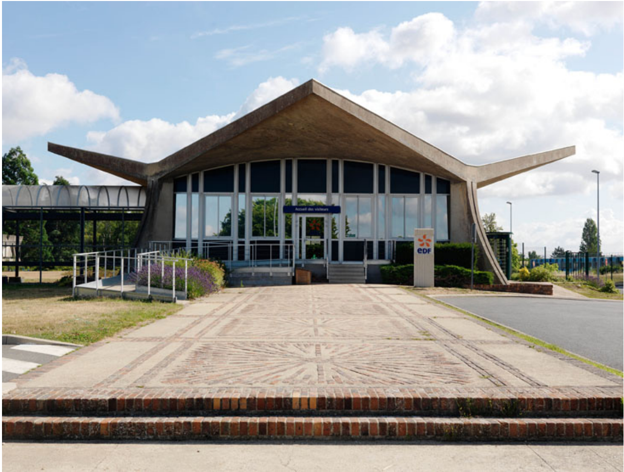
Le pavillon d'accueil des Renardières de René Sarger. Au premier plan, traitement du sol pour les piétons.
