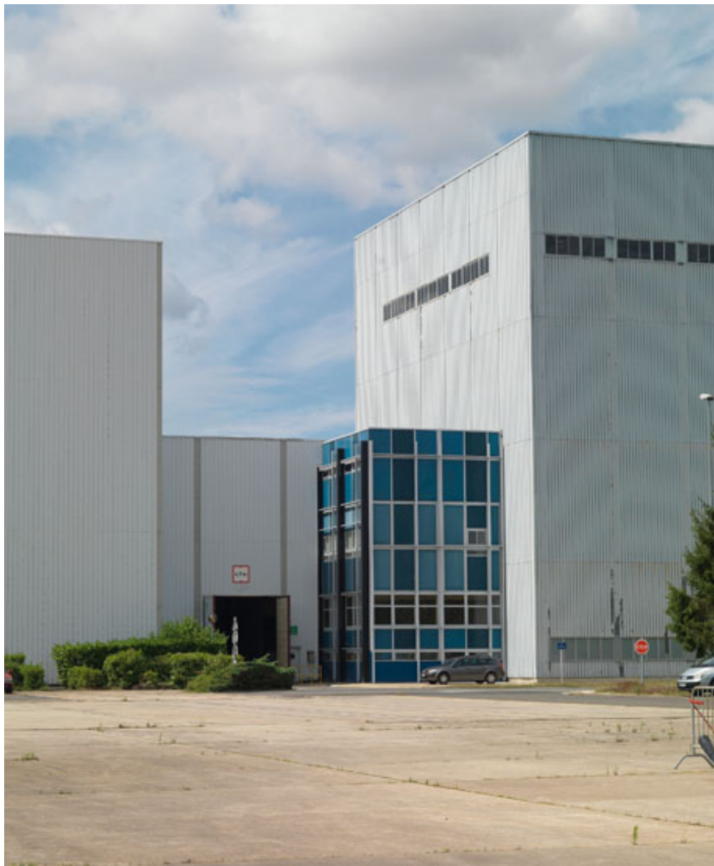
Le LEHT (Laboratoire d'essais haute tension) en bardage clair avec un module de bureaux bleu a deux étages.
