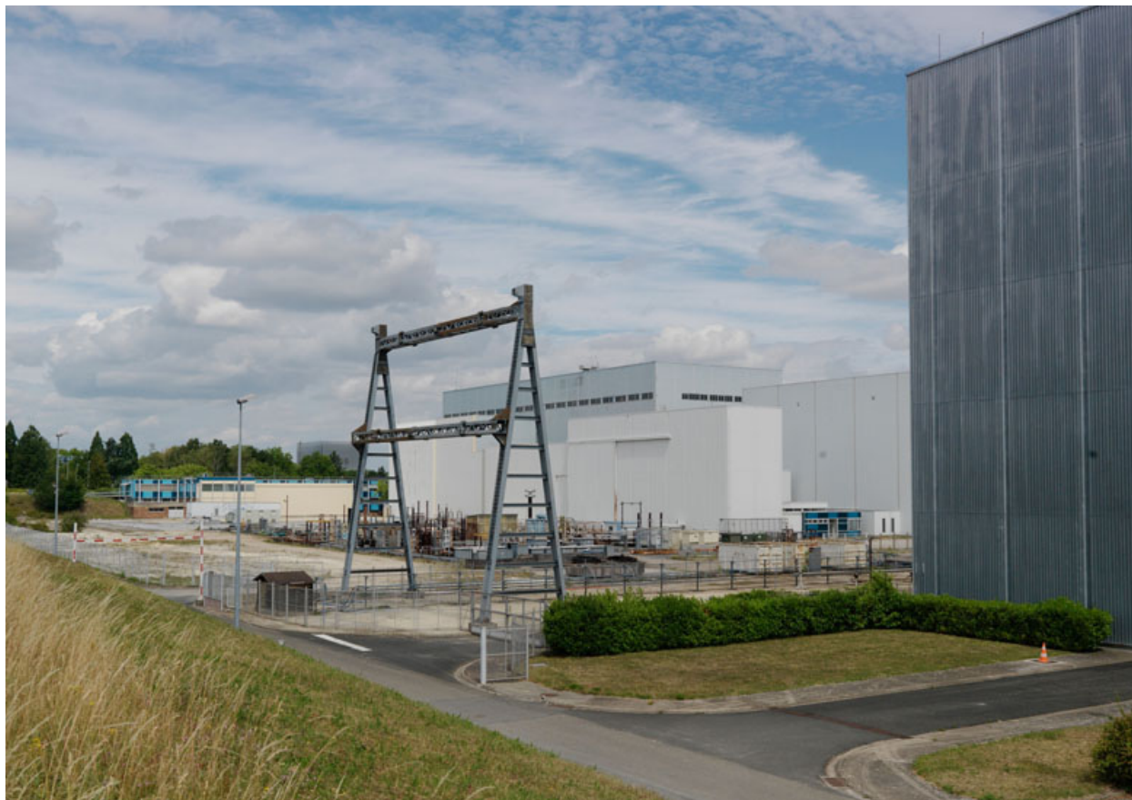
Le LEHT (Laboratoire d'essais haute tension) en bardage clair. A droite le Hall d'essais synthétiques en bardage gris. A gauche en arriere-plan le bâtiment de bureaux bleu du LTHT disparu (Laboratoire tres haute tension).
