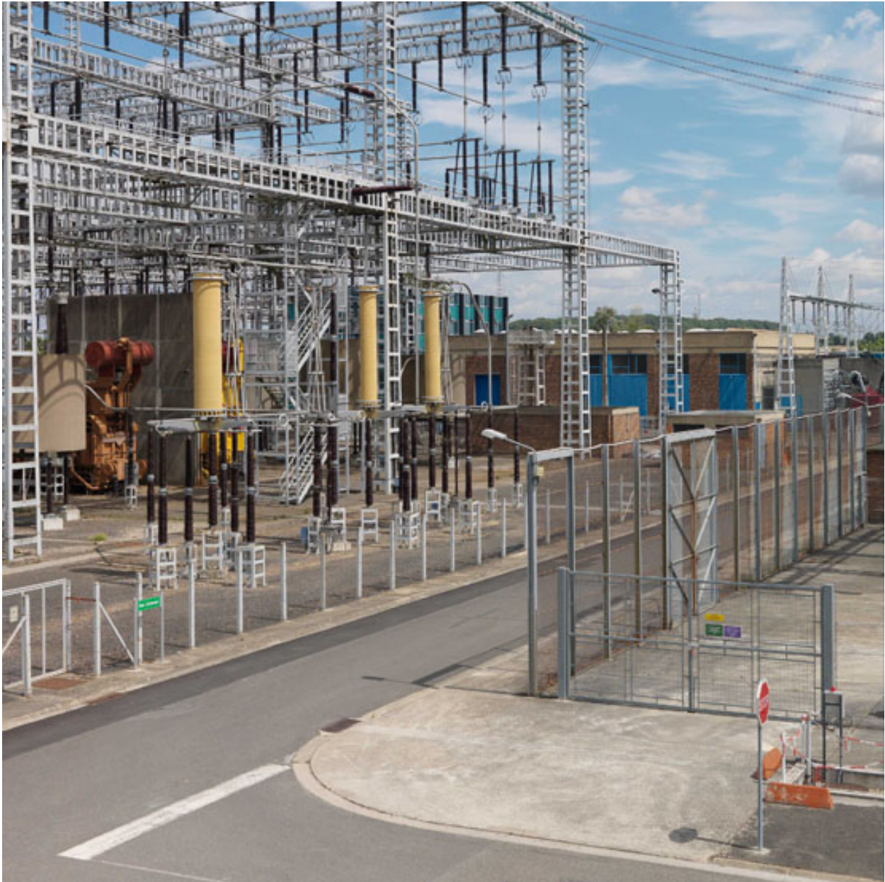
Charpente électrique extérieure. Détail.
