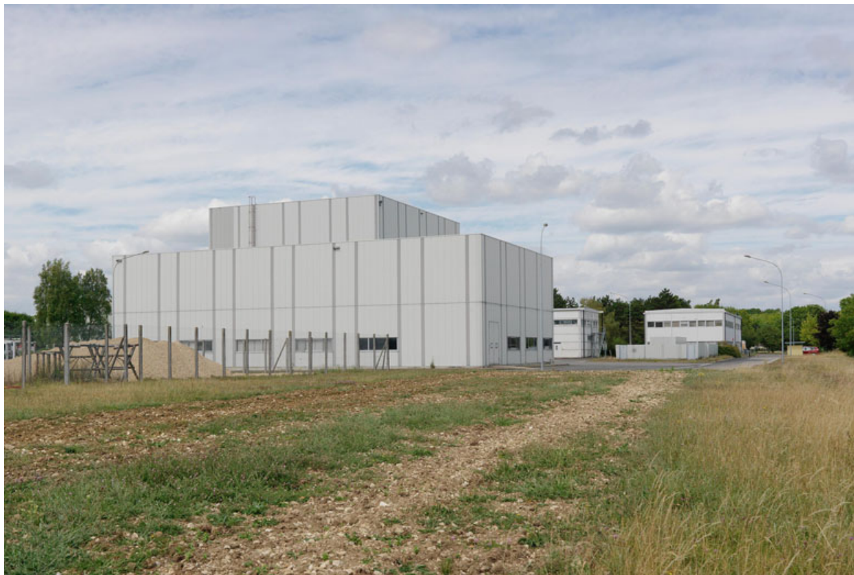
Détail du pôle CIMA (Câbles, condensateurs, Isolants, Matériels d'Automatisme). Juxtaposition de halls de seconde génération et de laboratoires d'essais blancs.
