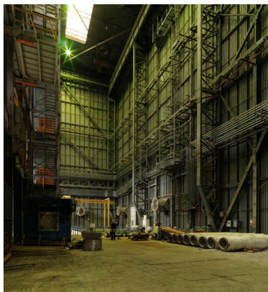
Intérieur du Hall CGVS (Circuit d'essais de Générateurs de Vapeur chauffés au Sodium). Phot. Philippe Ayrault IVR11_20117700810NUC4A
