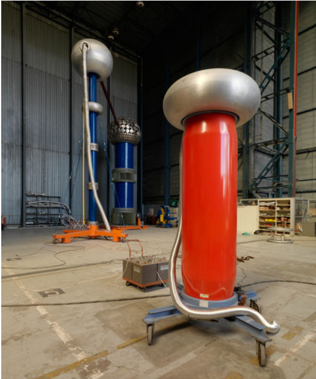
Intérieur du Hall d'essais synthétiques. Matériel d'essais.
