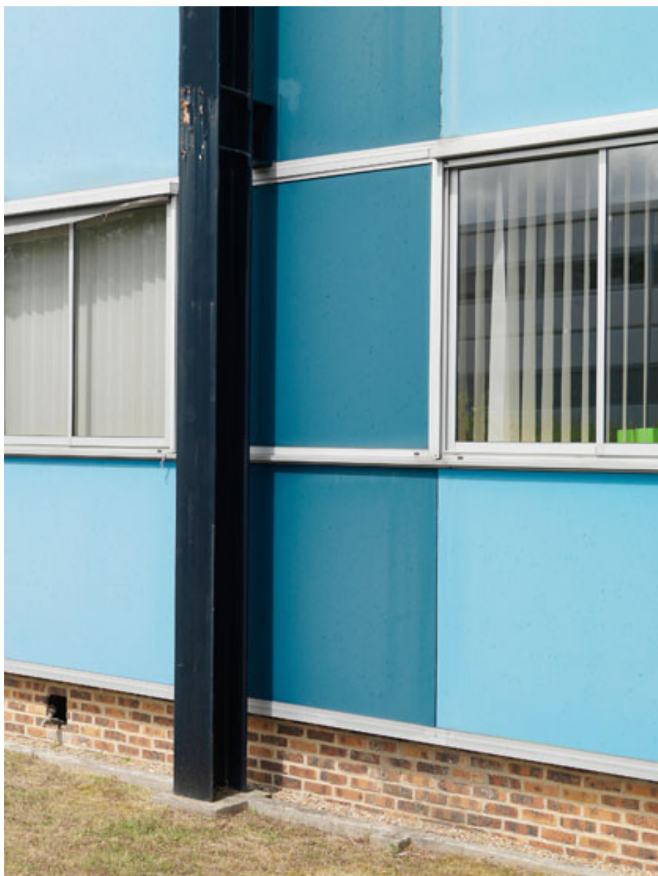
Bâtiment de bureaux bleu. Etat d'origine. Détail façade.
