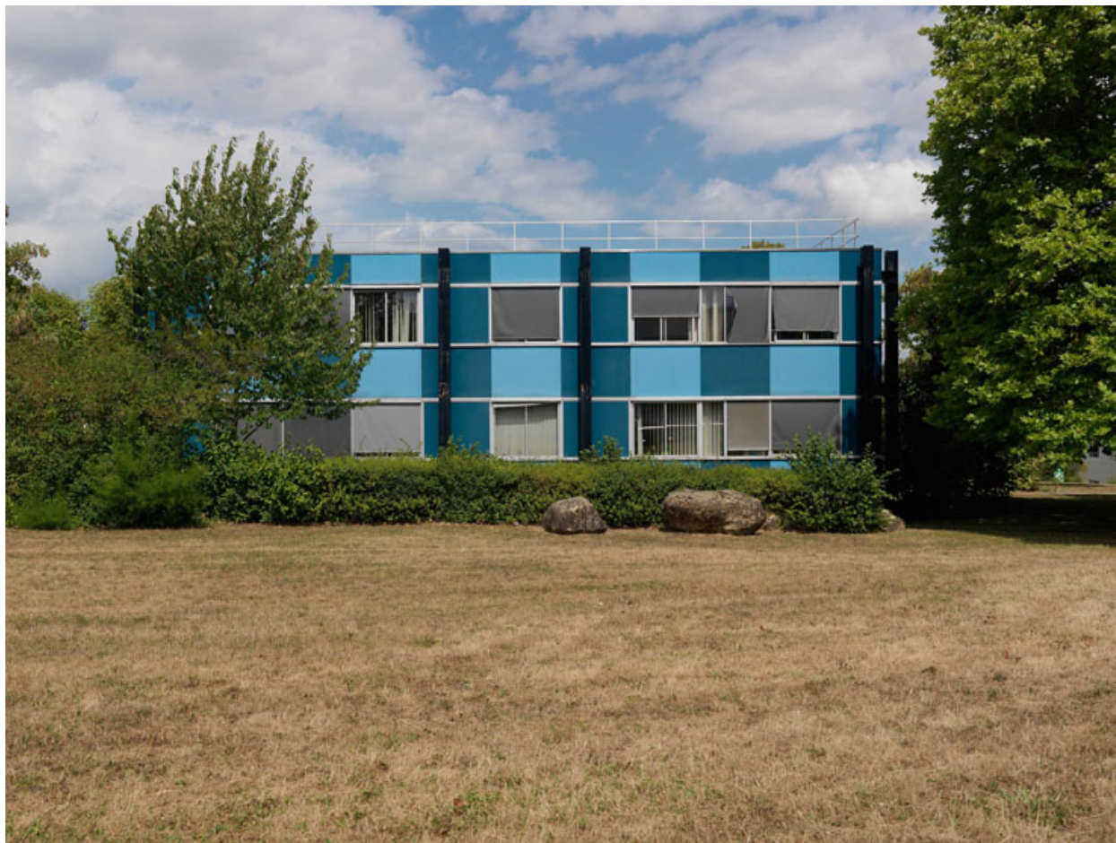
Bâtiment de bureaux bleu a 1 étage. Etat d'origine. Façade.
