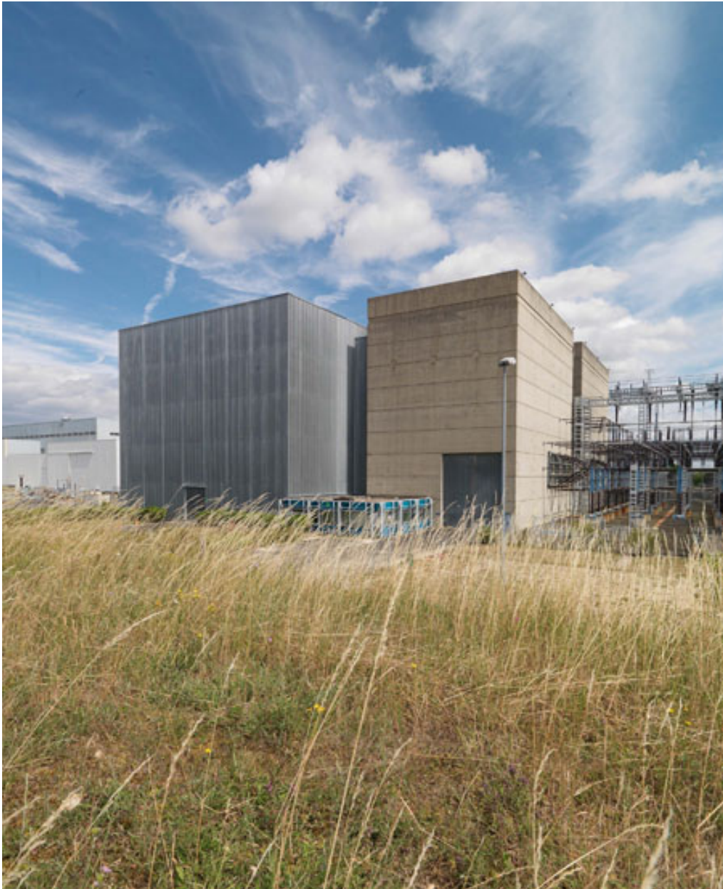
Hall STGP (Station d'essais grande puissance), Hall d'essais synthétiques et module de bureaux bleu. En arrière-plan à gauche le LEHT (Laboratoire d'essais haute tension) et à droite la charpente électrique extérieure.
