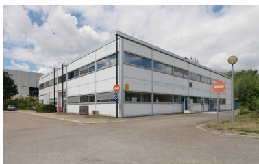
Deux laboratoires d'essais classiques blancs de type Prouvé couplés. Département ADE (Application de d'électricité). En arriere- plan a gauche le hall CGVS (Circuit d'essais de Générateurs de Vapeur chauffés au Sodium).
