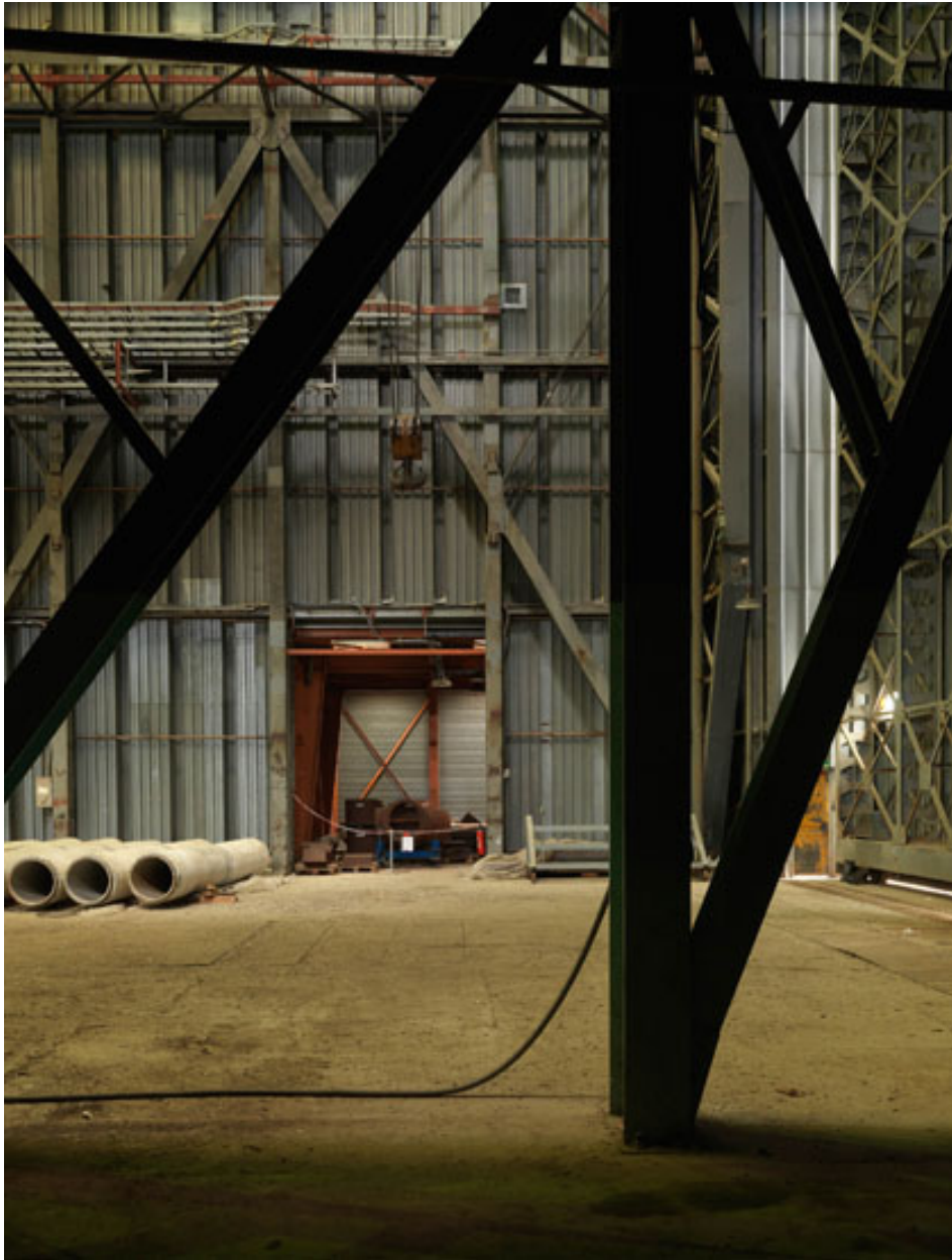
Intérieur du Hall CGVS (Circuit d'essais de Générateurs de Vapeur chauffés au Sodium).
