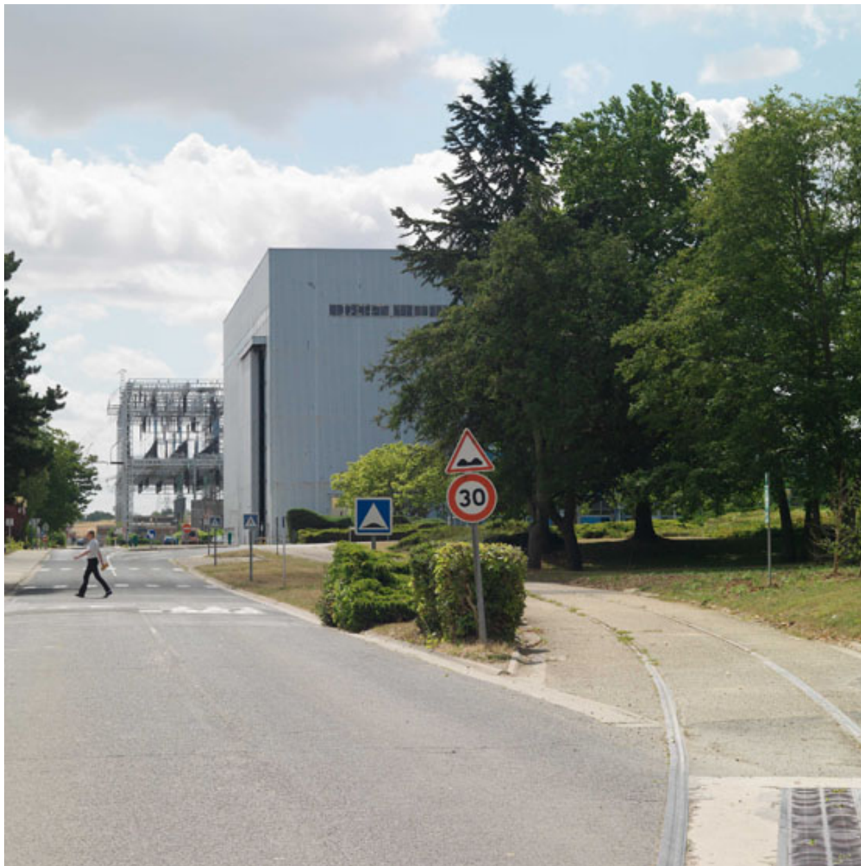
Le LEHT (Laboratoire d'essais haute tension) en bardage clair avec sa grande porte. En arrière-plan la charpente électrique extérieure et au premier plan les rails qui se raccordent à la gare de Saint-Mammes.
