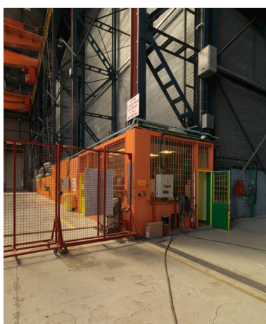
Intérieur du Hall d'essais synthétiques. Postes de commande. Phot. Philippe Ayrault IVR11_20117700846NUC4A
