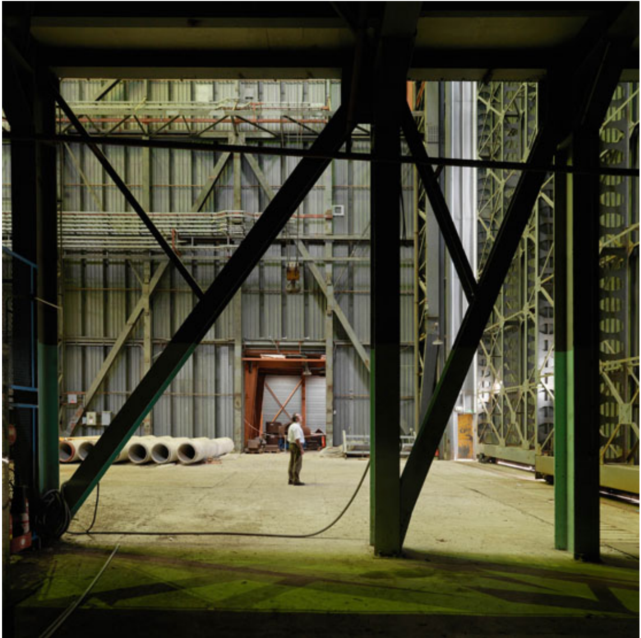
Intérieur du Hall CGVS (Circuit d'essais de Générateurs de Vapeur chauffés au Sodium).
