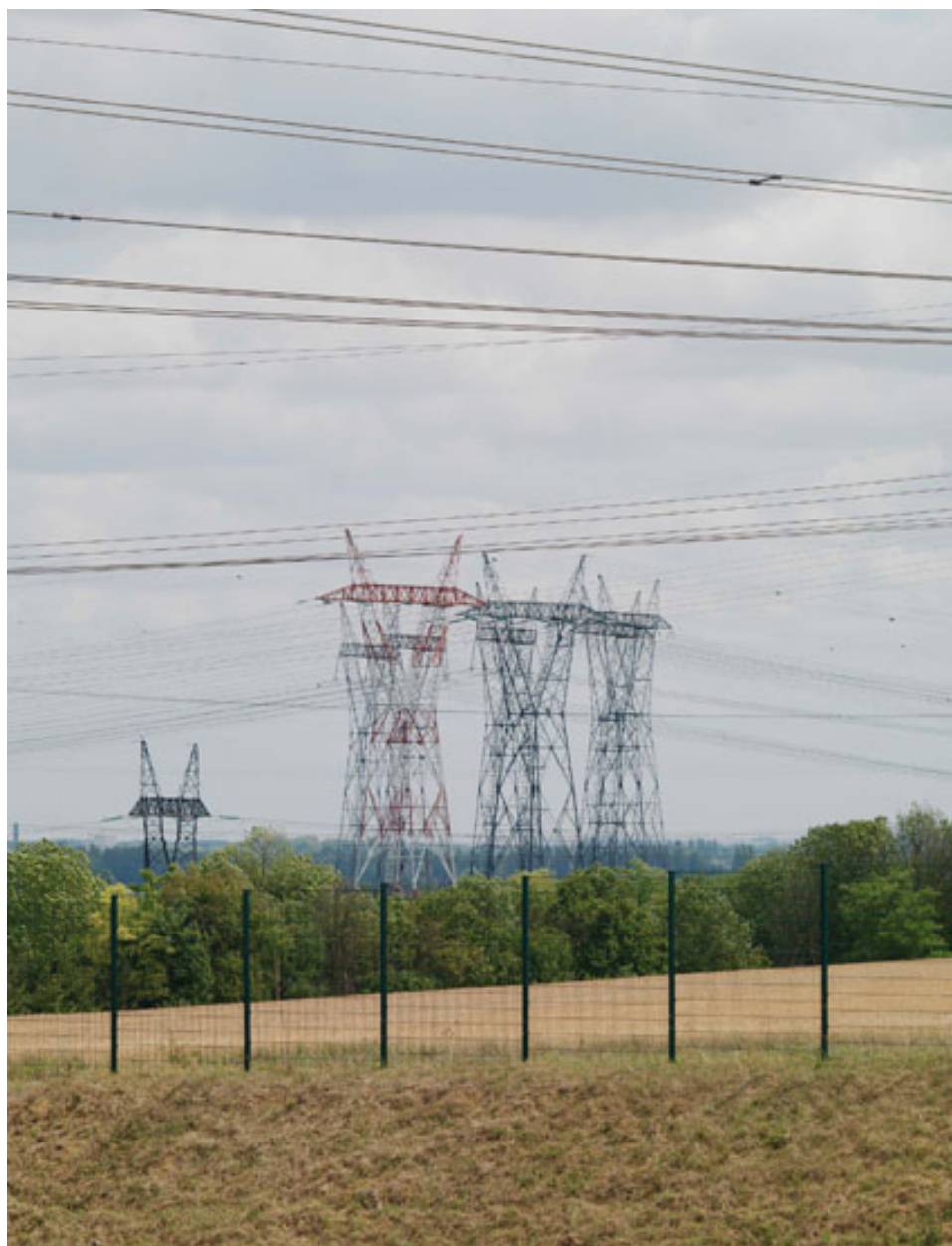
Paysage aux abords du site des Renardières. Pylônes et lignes d'alimentation.
