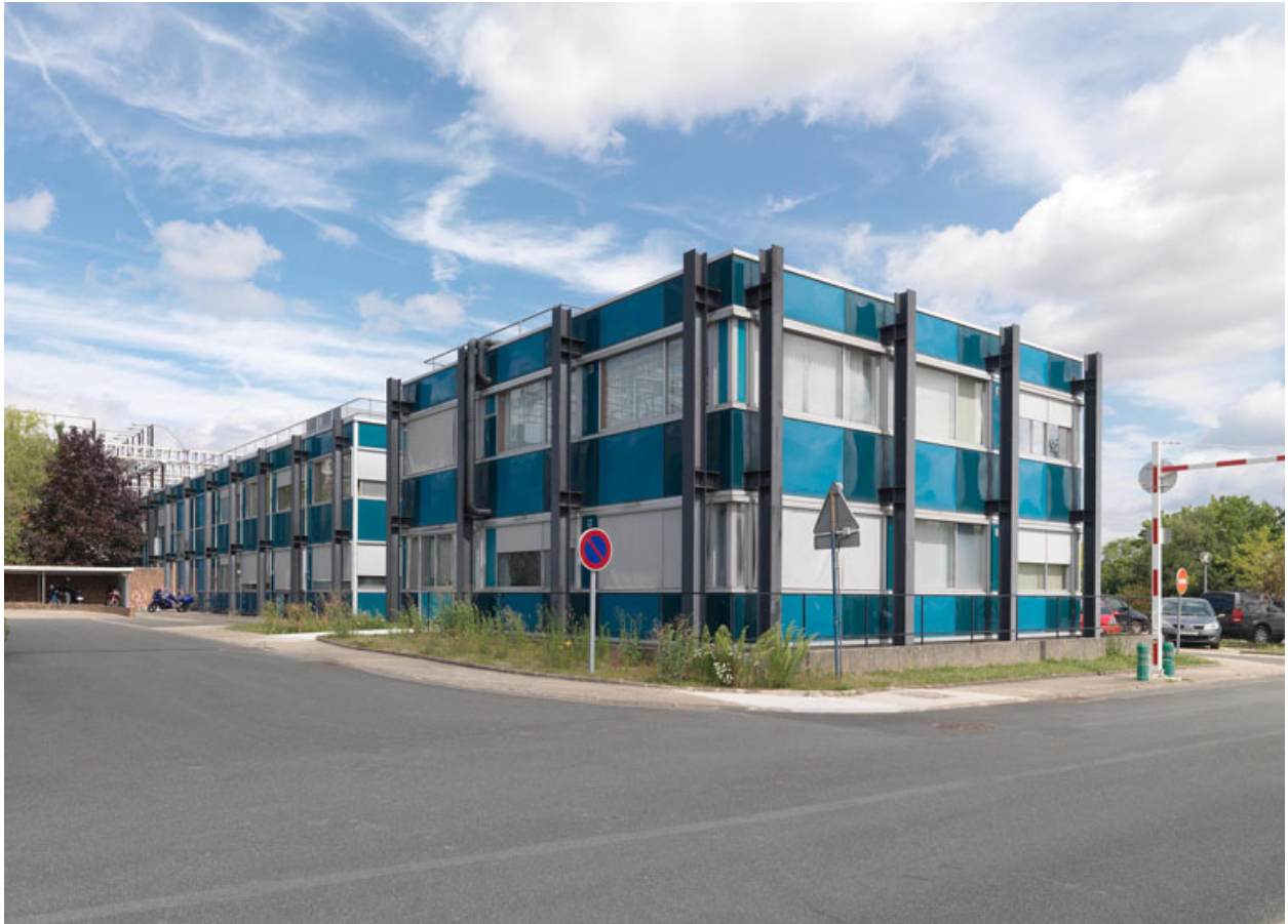
Bâtiments de bureaux bleus a un étage. Etat d'origine. En arriere-plan la charpente électrique extérieure. Département LEP (Laboratoire d'essais de puissance).
