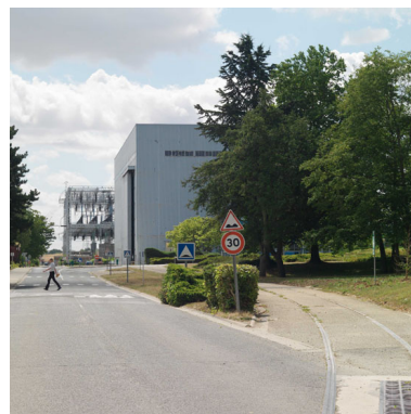
Le LEHT (Laboratoire d'essais haute tension) en bardage clair avec sa grande porte. En arrière-plan la charpente électrique extérieure et au premier plan les rails qui se raccordent à la gare de Saint-Mammes. Phot. Philippe Ayrault IVR11_20117700838NUC4A
