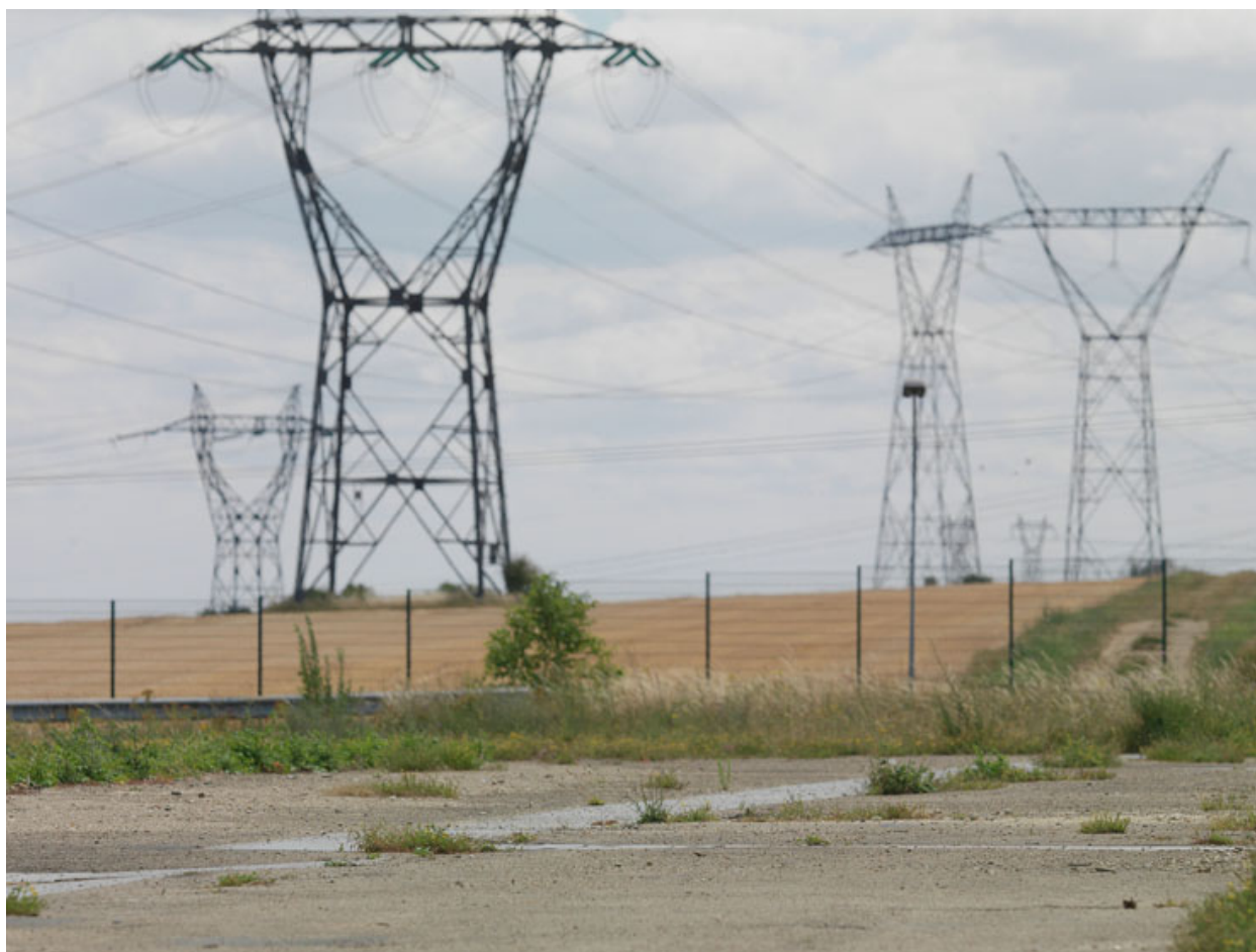
Paysage aux abords du site des Renardières. Pylônes et lignes d'alimentation.
