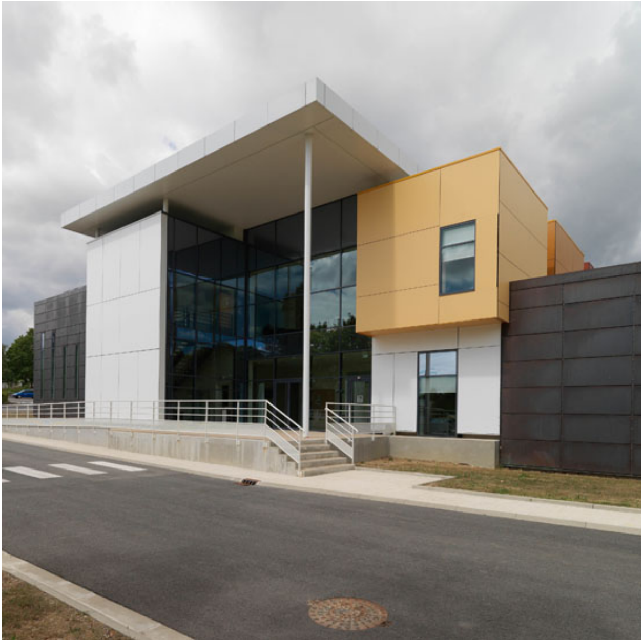
Bâtiment inauguré en 2009 et s'affranchissant de la charte esthétique originelle des Renardières. Département MAI (Materials Ageing Institut). Vue de l'entrée.
