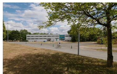
Ensemble construit entre 1981 et 1995 ( ? ) constitué de laboratoires d#essais blancs et de bureaux de seconde génération. Début de l#émancipation vis-a-vis des principes constructifs originels. Département CIMA (Câbles, condensateurs, Isolants, Matériels d#Automatisme).
