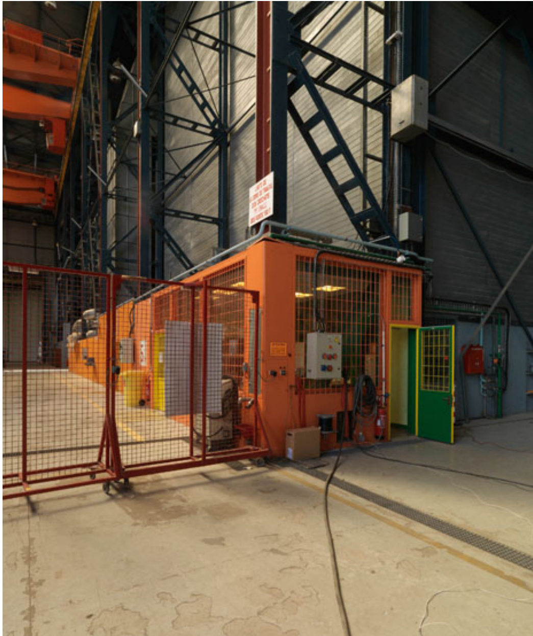
Intérieur du Hall d'essais synthétiques. Postes de commande.
