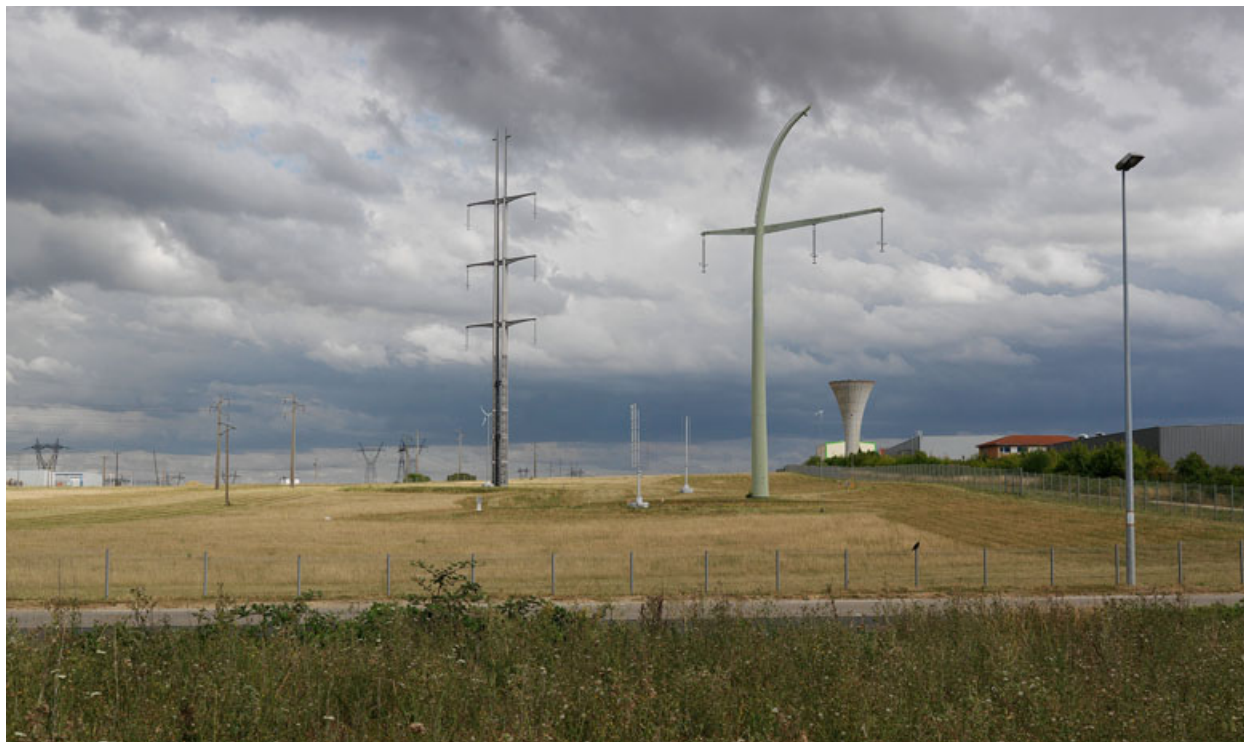
Paysage aux abords du site des Renardières. Pylônes et lignes d'alimentation.
