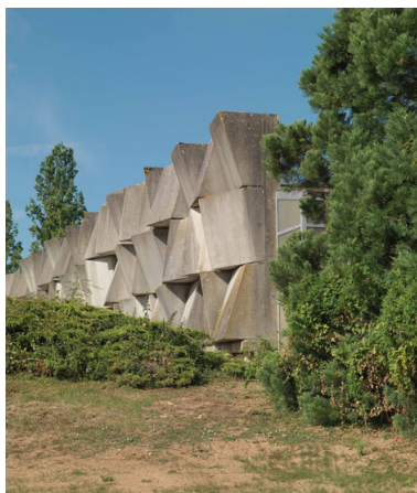
Le mur décoratif d'Etienne Martin à l'entrée du site pour dissimuler des bâtiments techniques. Phot. Philippe Ayrault IVR11_20117700837NUC4A
