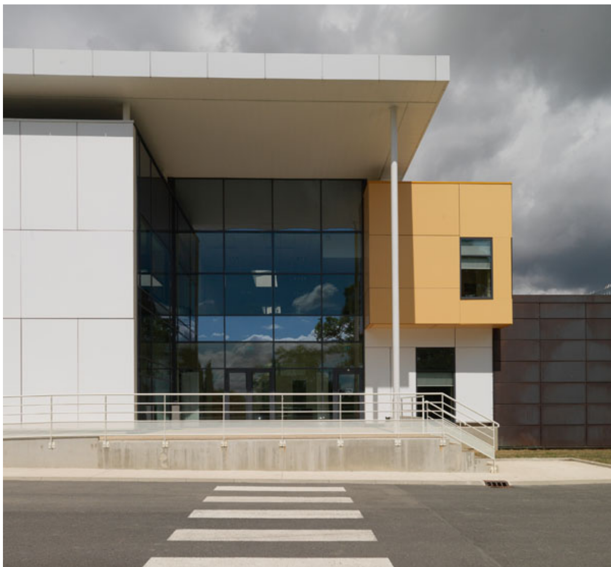
Bâtiment inauguré en 2009 et s'affranchissant de la charte esthétique originelle des Renardières. Département MAI (Materials Ageing Institut). Vue de l'entrée.
