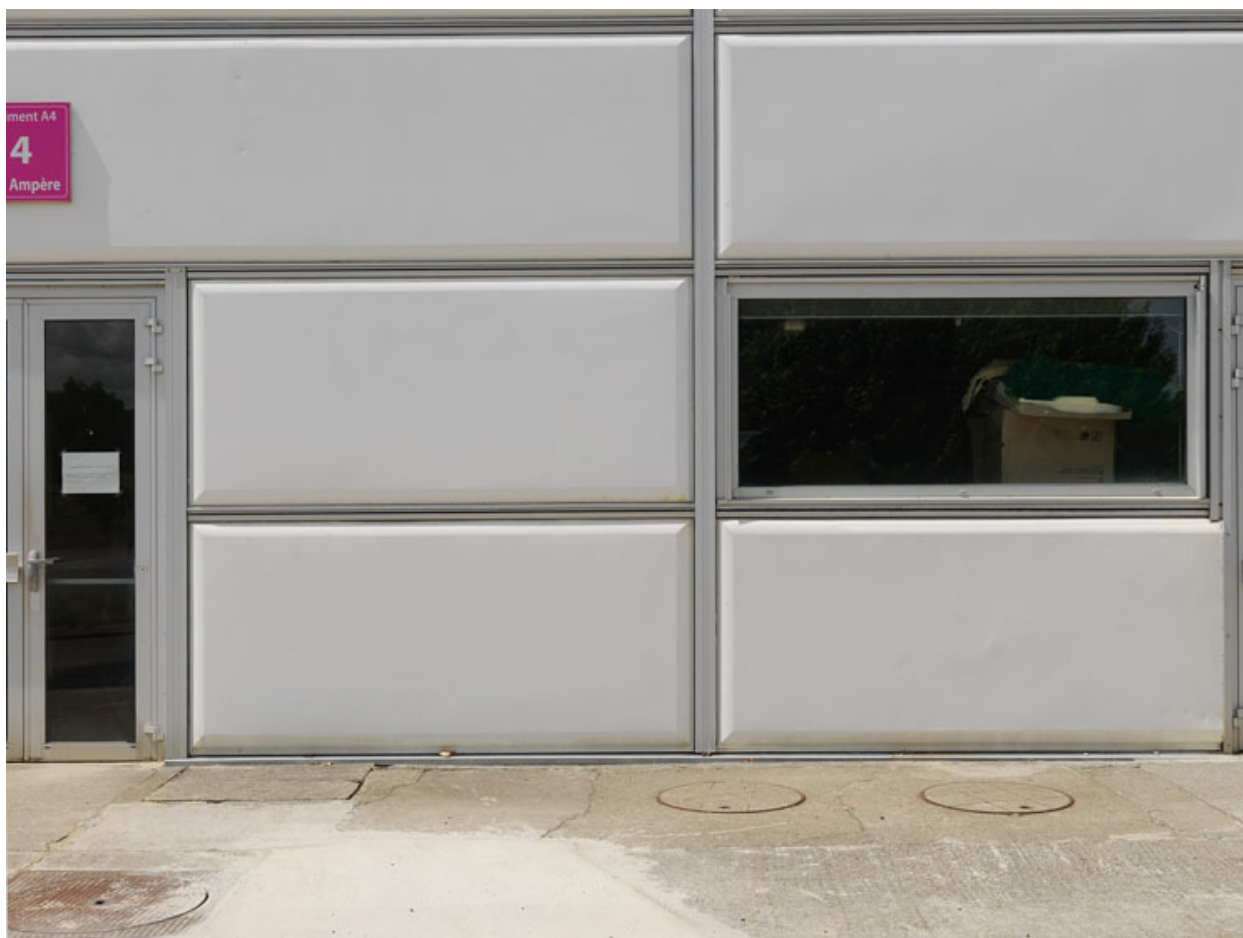
Laboratoire d'essais classique blanc de type Prouvé. Détail. Assemblage des panneaux pleins et vitrés. Traitement du joint.
