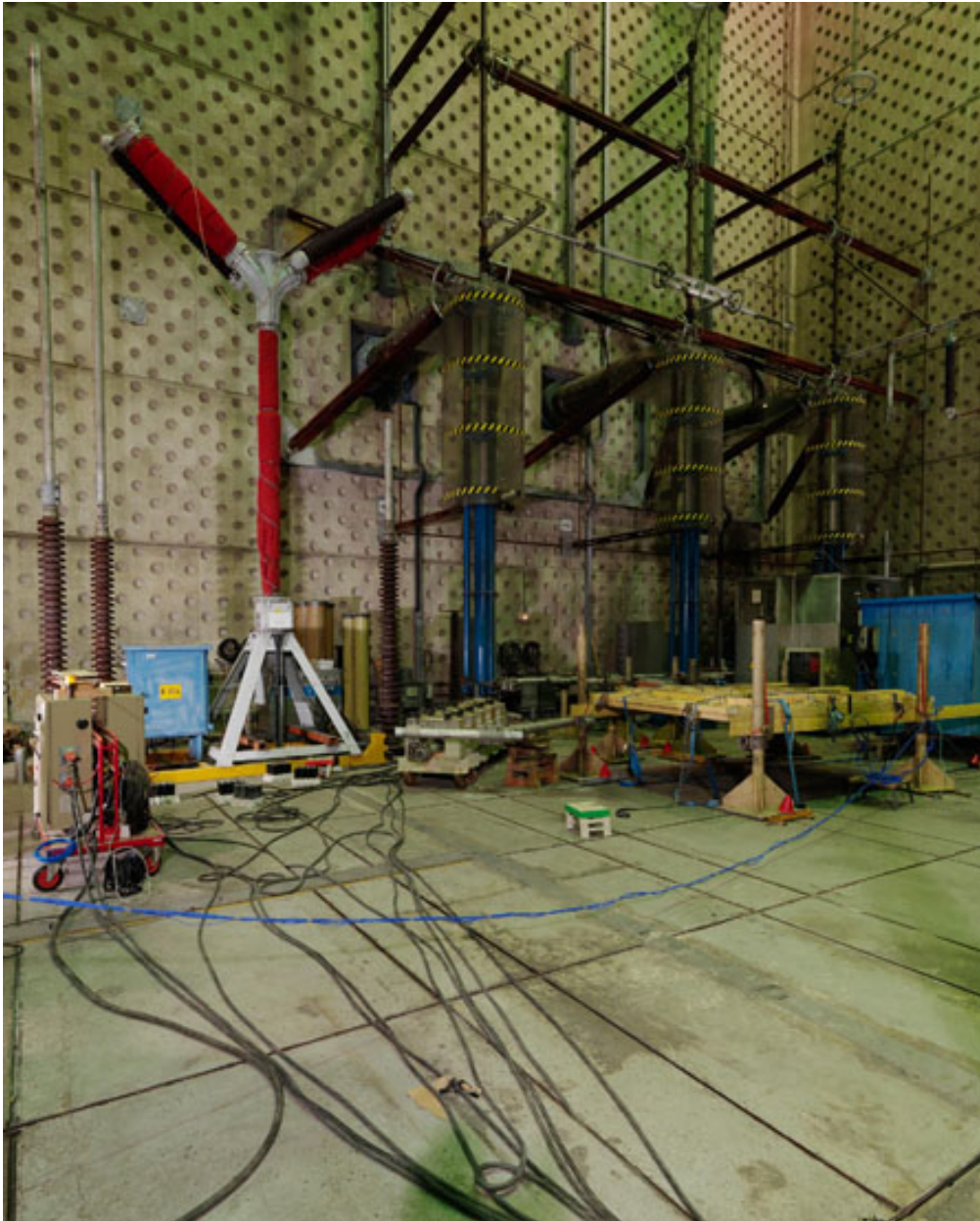
Intérieur d'un Hall STGP (Station d'essais grande puissance). Parois de béton armé de 40cm d'épaisseur alvéolé pour résister à des déflagrations de 10 kg de TNT.
