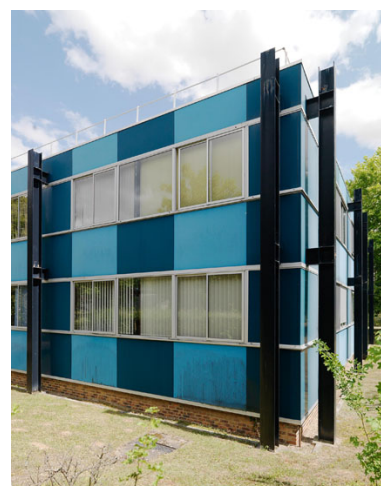
Bâtiment de bureaux bleu à 1 étage. Etat d'origine. Détail angle. Phot. Philippe Ayrault IVR11_20117700790NUC4A
