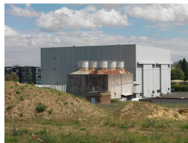
Hall C27 construit en 1981 pour abriter les boucles d'essais de centrales REP (Réacteur eau pressurisée). Début de l'émancipation vis-a-vis de la charte esthétique originelle des Renardières. Phot. Philippe Ayrault IVR11_20117700781NUC4A
