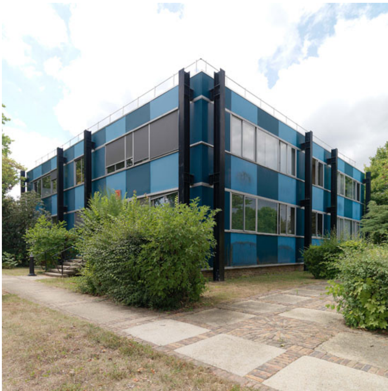
Bâtiment de bureaux bleu à 1 étage. Etat d'origine. Détail d'un angle.
