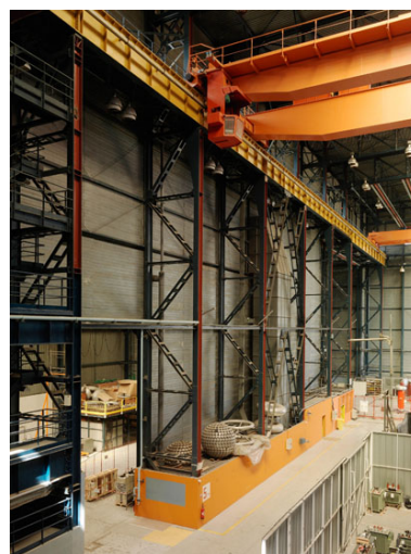
Intérieur du Hall d'essais synthétiques. Structure et ponts roulants.
