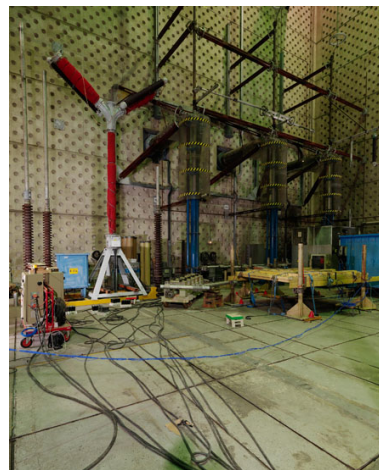
Intérieur d'un Hall STGP (Station d'essais grande puissance). Parois de béton armé de 40cm d'épaisseur alvéolé pour résister à des déflagrations de 10 kg de TNT. Phot. Philippe Ayrault IVR11_20117700862NUC4A
