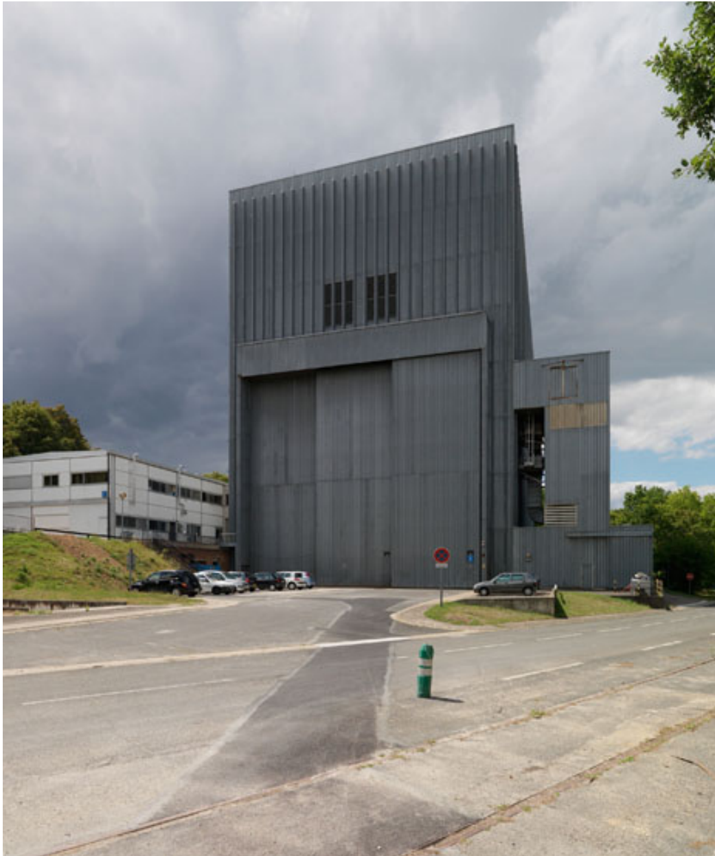
Le Hall CGVS (Circuit d'essais de Générateurs de Vapeur chauffés au Sodium) couplé a un Laboratoire d'essais classique blanc de type Prouvé.
