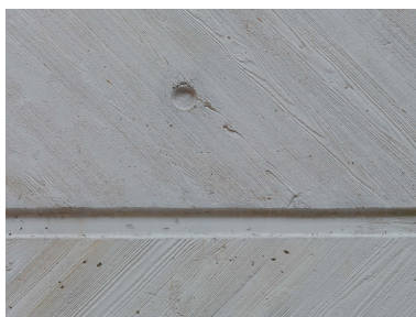
Restaurant infirmerie du site des Renardières. Vue intérieure de la cage d'escalier. Traitement des matériaux. Phot. Philippe Ayrault IVR11_20117700902NUC4A
