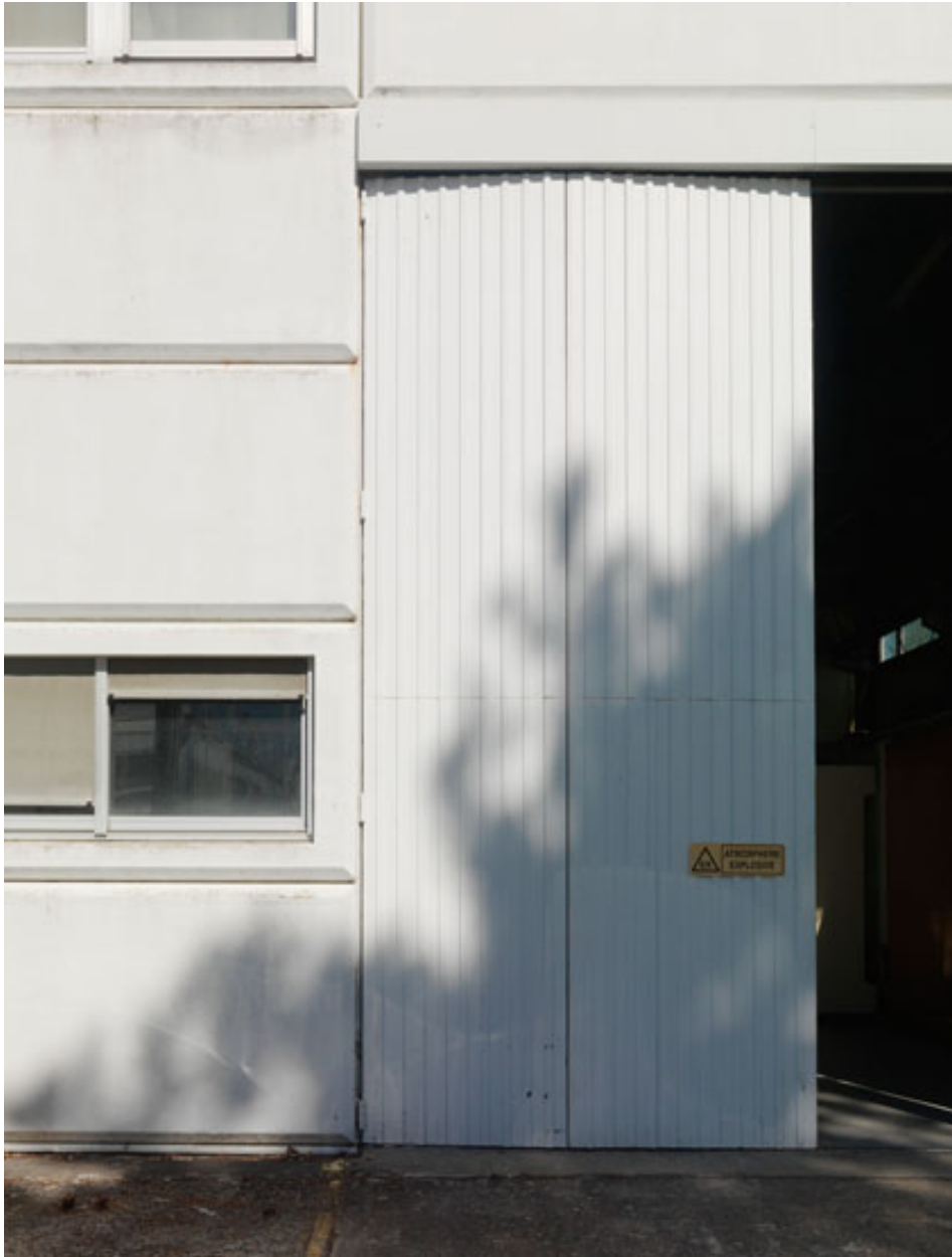
Détail de façade d'un laboratoire d'essais classique blanc de type Prouvé au niveau d'une grande porte, état transformé
