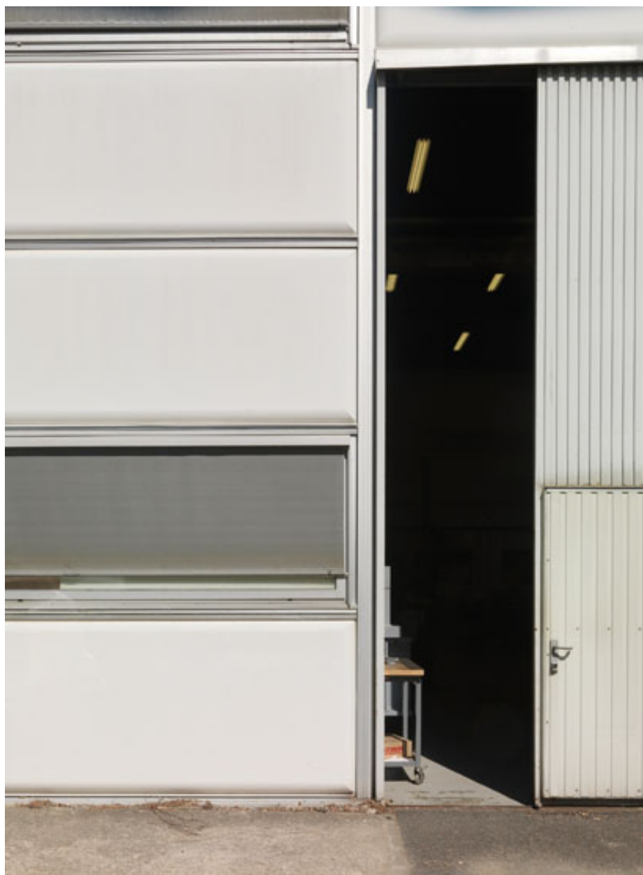
Détail de façade d'un laboratoire d'essais classique blanc de type Prouvé au niveau d'une grande porte, état d'origine.
