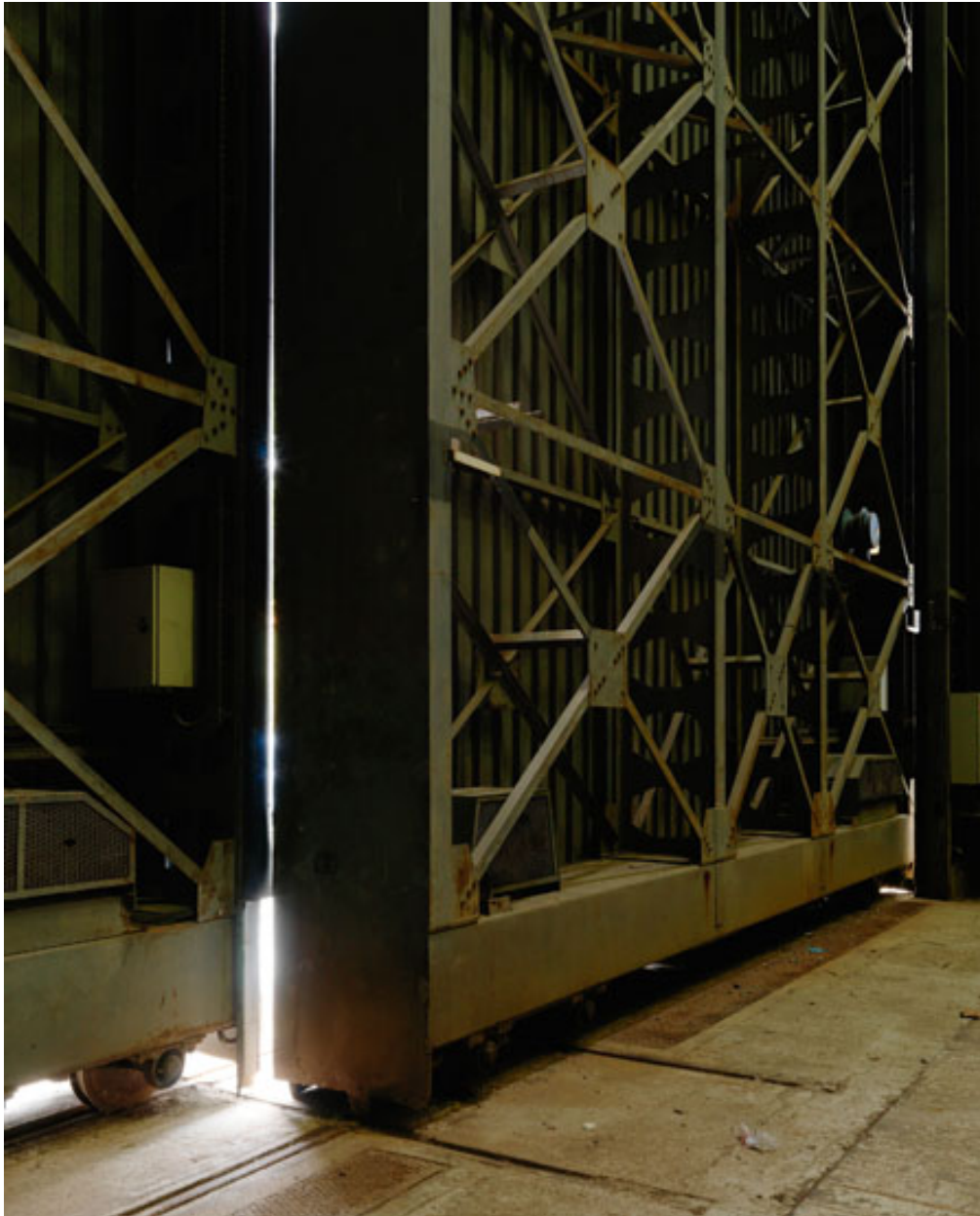
Intérieur du Hall CGVS (Circuit d'essais de Générateurs de Vapeur chauffés au Sodium). Grande porte.
