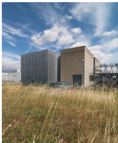
De gauche à droite : le LEHT (Laboratoire d'essais haute tension) en bardage clair, le Hall d'essais synthétiques en bardage gris, un module de bureaux bleu, le Hall STGP (Station d'essais grande puissance) en béton brut, la charpente électrique extérieure. Phot. Philippe Ayrault IVR11_20117700859NUC4A
