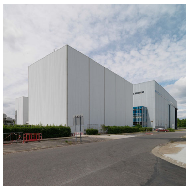
Le LEHT (Laboratoire d'essais haute tension) en bardage clair avec un module de bureaux bleu à deux étages. Phot. Philippe Ayrault IVR11_20117700839NUC4A
