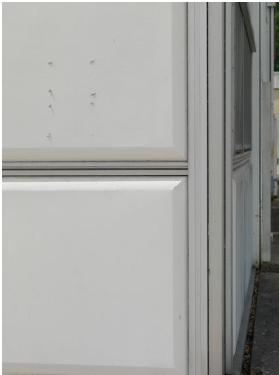
Laboratoire d'essais classique blanc de type Prouvé. Détail d'un angle. Assemblage des panneaux. Traitement du joint.
