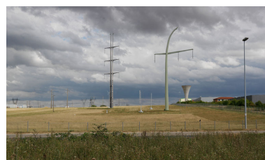
Paysage aux abords du site des Renardières. Pylônes et lignes d'alimentation. Phot. Philippe Ayrault IVR11_20117700889NUC4A
