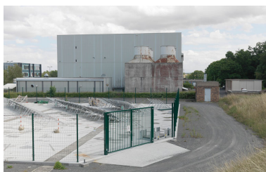
Hall C27 construit en 1981 pour abriter les boucles d'essais de centrales REP (Réacteur eau pressurisée). Début de l'émancipation vis-a-vis de la charte esthétique originelle des Renardières. Phot. Philippe Ayrault IVR11_20117700783NUC4A
