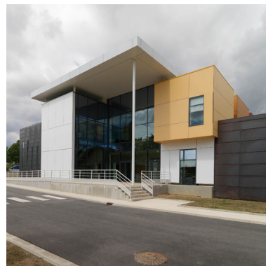
Bâtiment inauguré en 2009 et s'affranchissant de la charte esthétique originelle des Renardières. Département MAI (Materials Ageing Institut). Vue de l'entrée. Phot. Philippe Ayrault IVR11_20117700778NUC4A
