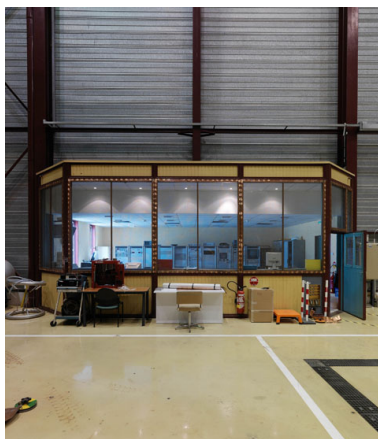
Intérieur du Hall d'essais synthétiques en bardage gris. Poste de commande. Phot. Philippe Ayrault IVR11_20117700855NUC4A
