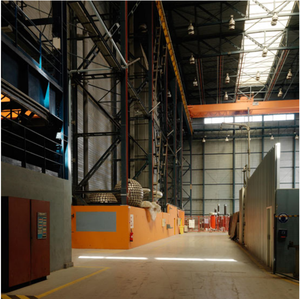
Intérieur du Hall d'essais synthétiques. Structure et pont roulant.
