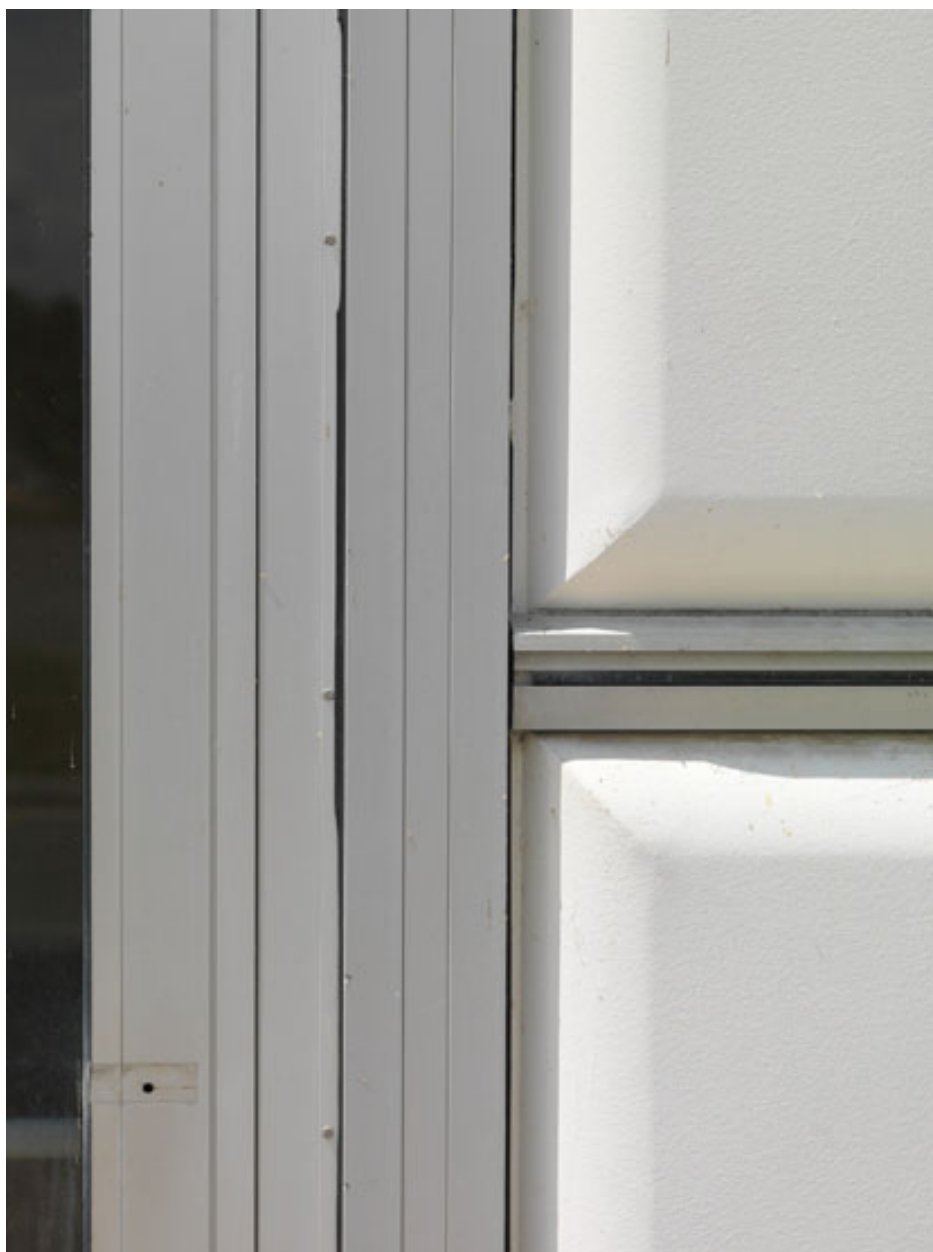
Laboratoire d'essais classique blanc de type Prouvé. Détail. Assemblage des panneaux. Traitement du joint.
