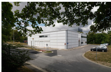
Deux laboratoires d'essais classiques blancs de type Prouvé couplés. Le Climatron (1963), laboratoire remarquable. Département ADE (Application de d'électricité). En arrière-plan le hall CGVS (Circuit d'essais de Générateurs de Vapeur chauffés au Sodium). Phot. Philippe Ayrault IVR11_20117700786NUC4A
