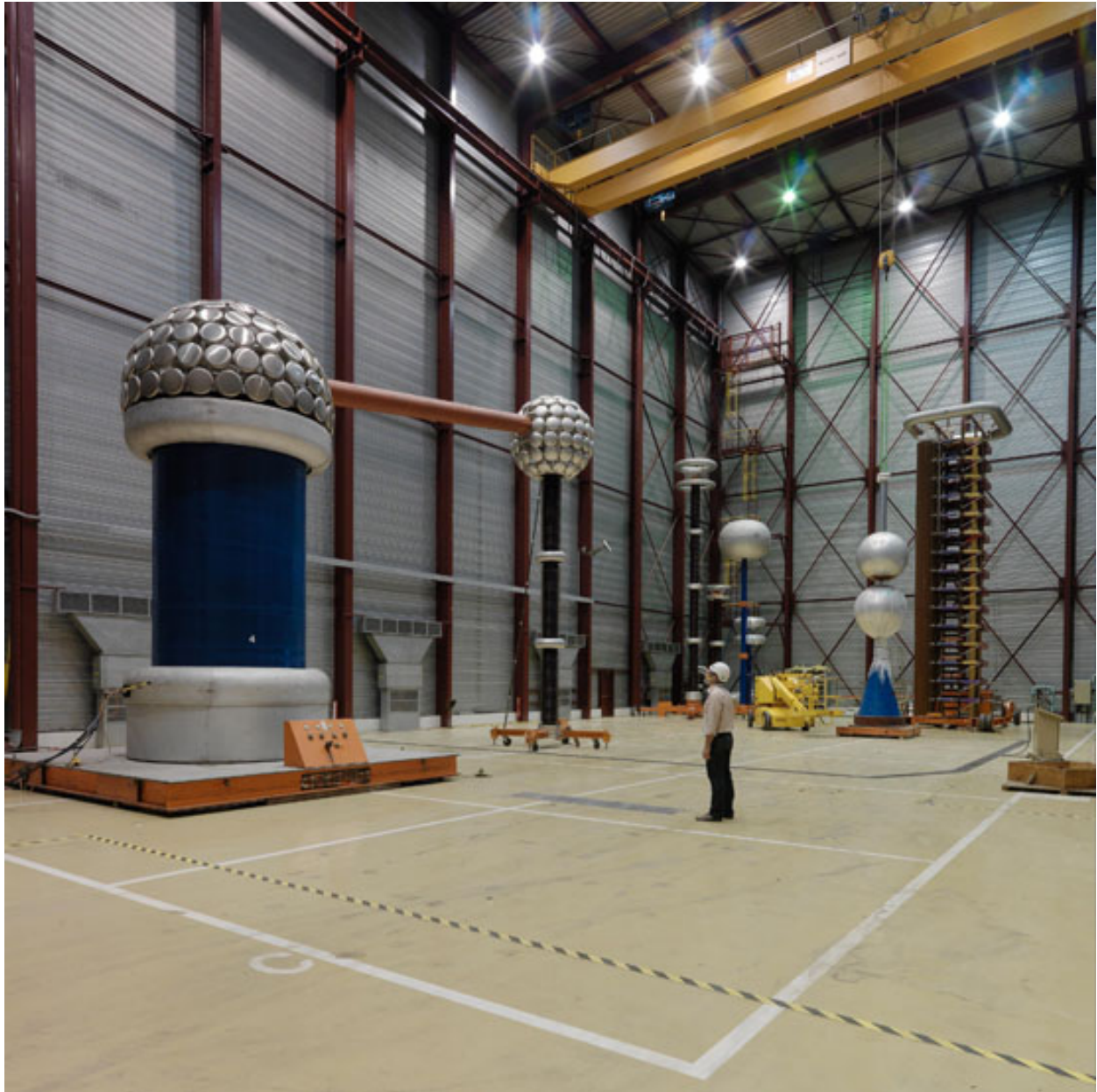
Intérieur du Hall d'essais synthétiques en bardage gris. Matériel d'essais.
