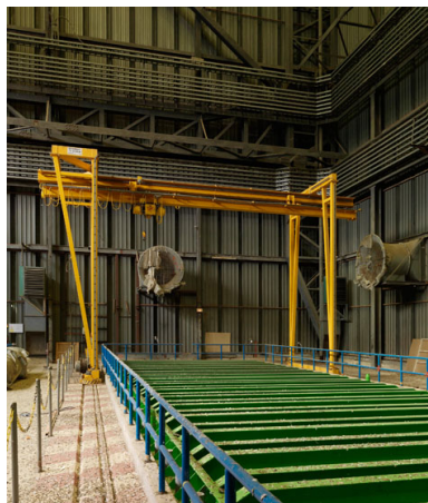
Intérieur du Hall CGVS (Circuit d'essais de Générateurs de Vapeur chauffés au Sodium). Phot. Philippe Ayrault IVR11_20117700823NUC4A
