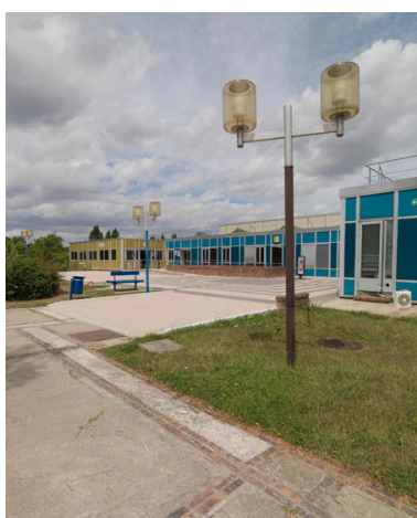
Restaurant infirmerie du site des Renardières. Vue des abords (traitement du sol et mobilier).
