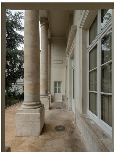
La galerie IVR11_20237500333NUC4A
