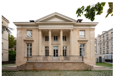
Façade antérieure, ouverte sur le jardin. IVR11_20237500568NUC4A
