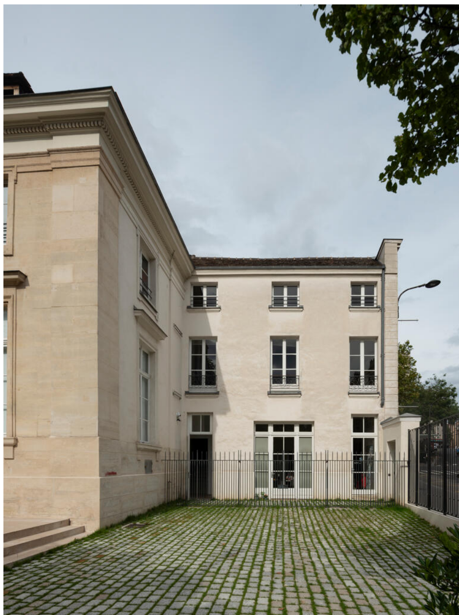
Extrémité sud de la façade principale sur jardin et, sur la droite, le commun attenant, qui longe la rue de Ménilmontant.
