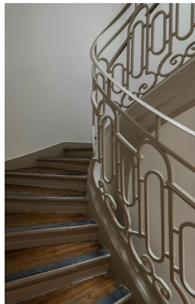
L'escalier à rampe de serrurerie, contemporain de la construction de la maison. IVR11_20237500336NUC4A
