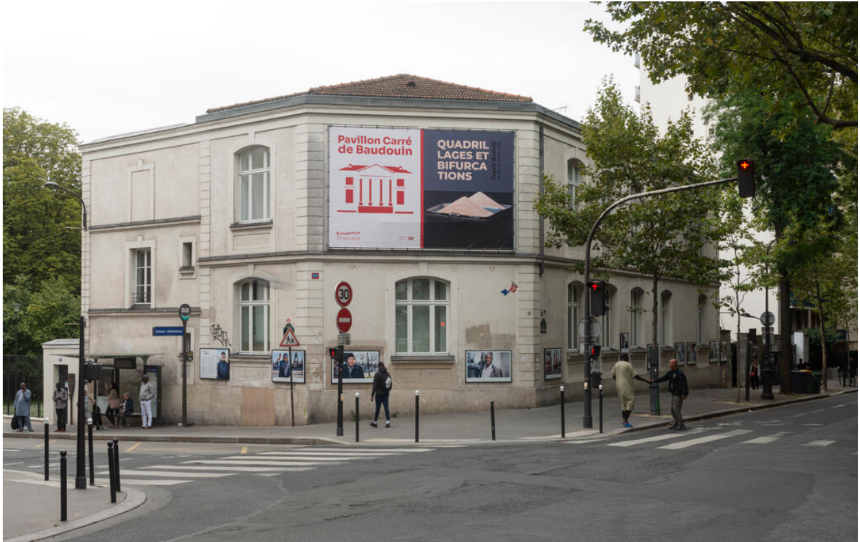
Façade postérieure des communs, angle des rues de Ménilmontant et des Pyrénées.
