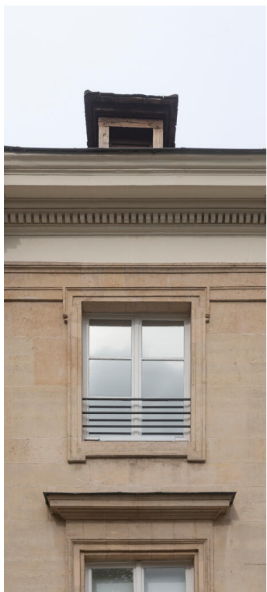
Détail en façade principale. La corniche à denticules, la fenêtre de l'étage carré avec son discret décor sculpté, et la corniche de la fenêtre du rez-de-chaussée surélevé. IVR11_20237500570NUC4A
