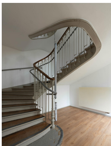
Escalier secondaire, à limon en crémaillère et barreaux en col de cygne, installé au XIXe siècle. IVR11_20237500338NUC4A
