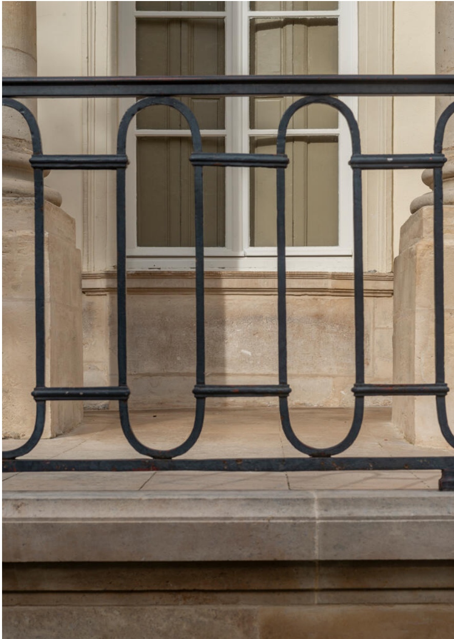
Détail du garde-corps à étriers.
