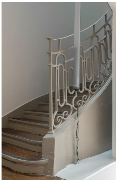
L'escalier à rampe de serrurerie, contemporain de la construction de la maison. IVR11_20237500335NUC4A
