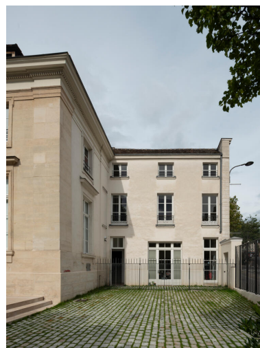
Extrémité sud de la façade principale sur jardin et, sur la droite, le commun attenant, qui longe la rue de Ménilmontant. IVR11_20237500571NUC4A
