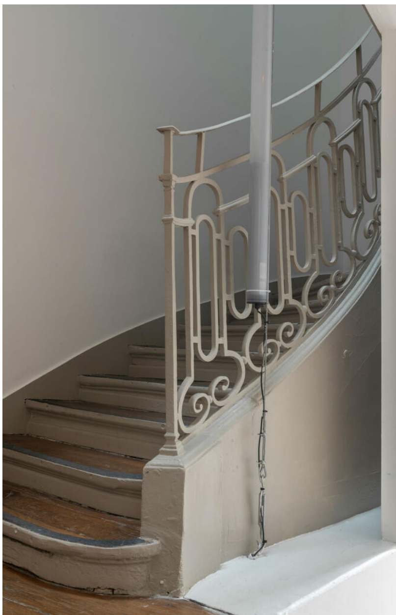
L'escalier à rampe de serrurerie, contemporain de la construction de la maison.
