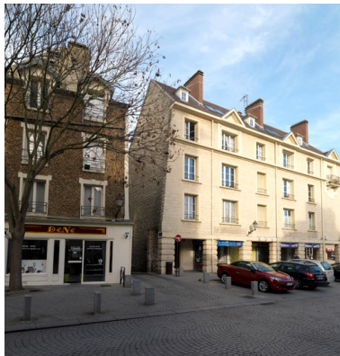
L'extrémité du bâtiment a un mur en biais destiné à rappeler l'architecture ancienne. Il s'agit d'un trompe l'oeil.
