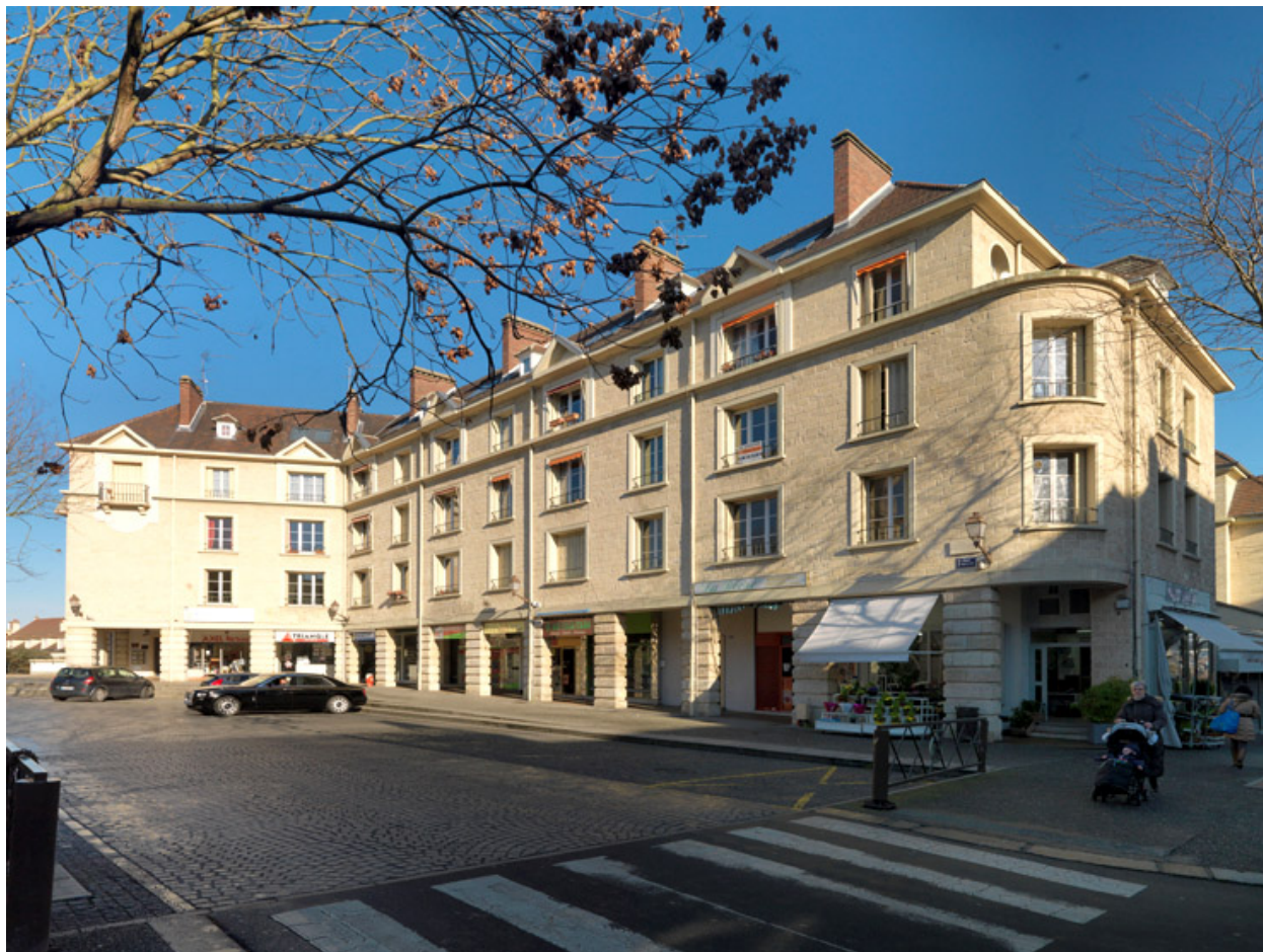
Vue des immeubles entre la rue Goust et l'escalier central.
