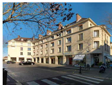
Vue des immeubles entre la rue Goust et l'escalier central.
