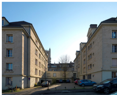
La façade arrière des immeubles et des échoppes qui les relient. Le principe de l'îlot ouvert est ici appliqué. Phot. Laurent Kruszyk IVR11_20167800089NUC4A
