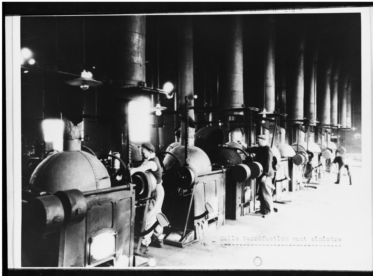
La salle de torréfaction avant le sinistre.
