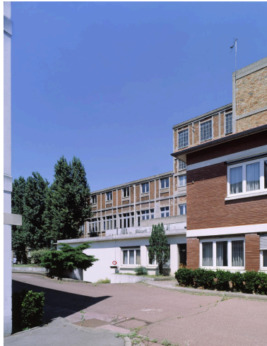
Vue partielle du bâtiment des bureaux et de l'ancienne usine de torréfaction.
