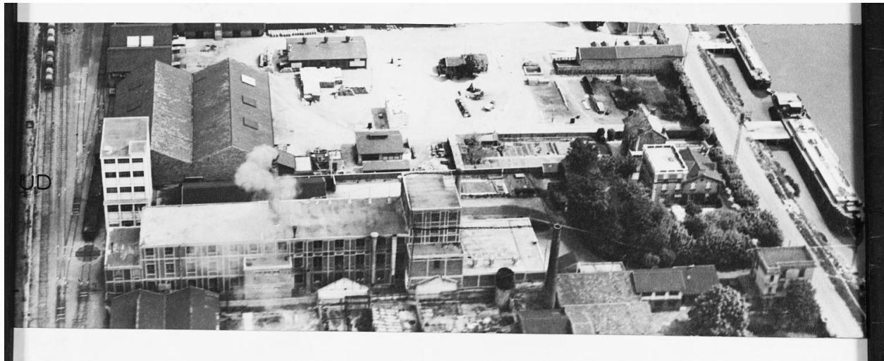
Vue d'ensemble des bâtiments avant le sinistre.
