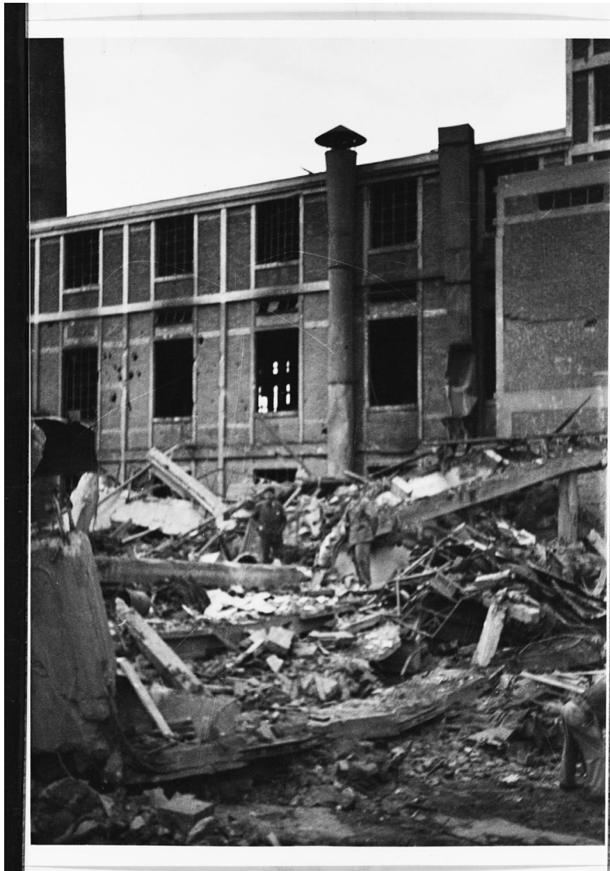
Les bâtiments sinistrés par le bombardement.
