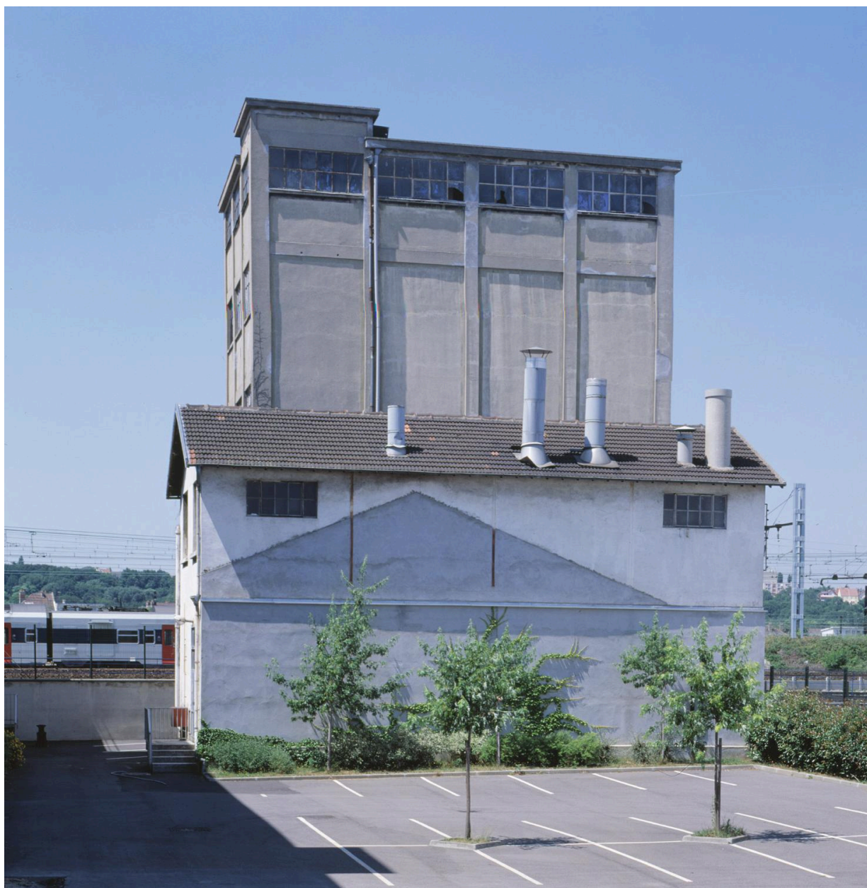
Vue des anciens silos situés au fond de la parcelle, près de la voie ferrée.
