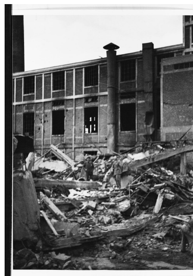
Les bâtiments sinistrés par le bombardement. IVR11_20039100166XB
