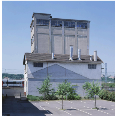
Vue des anciens silos situés au fond de la parcelle, près de la voie ferrée.
