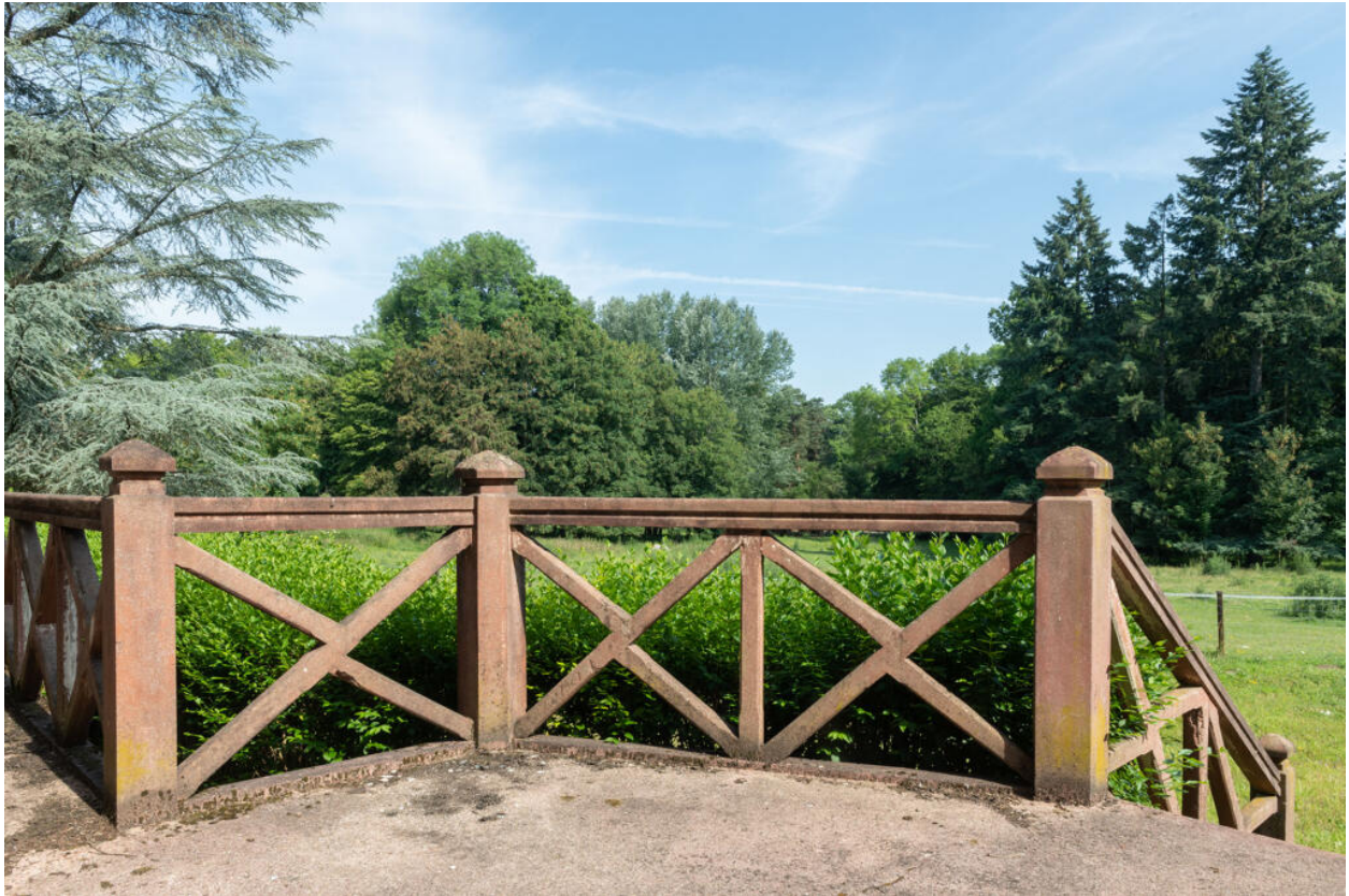
Détail du garde-corps en béton de la terrasse en façade nord, probablement d'origine.
