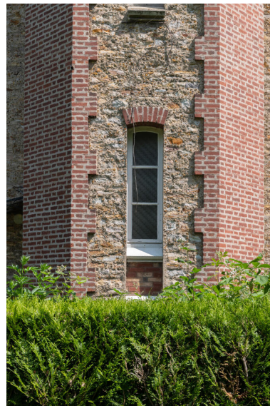
Détail du rez-de-chaussée de la tour.
