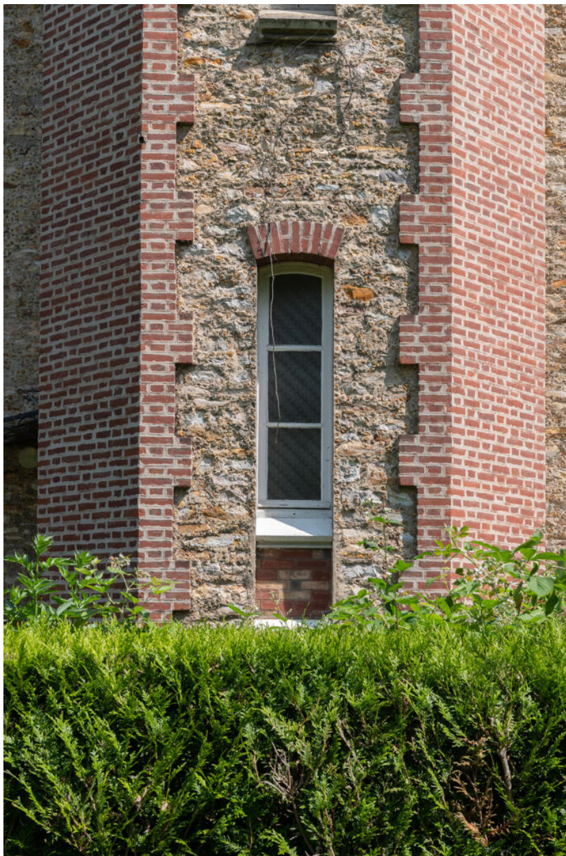
Détail du rez-de-chaussée de la tour. Les chaînes de brique encadrent un rocaillage de meulière qu'on retrouve sur l'ensemble des façades.
