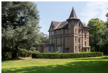
Vue générale de l'angle sud-est dominé par la tour qui malgré les apparences n'avait pas un usage de belvédère : au premier niveau se trouvait un cabinet de toilette.
