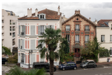
Vue de la place Charles- de-Gaulle depuis la mairie Phot. Kruszyk Laurent IVR11_20249200609NUC4A
