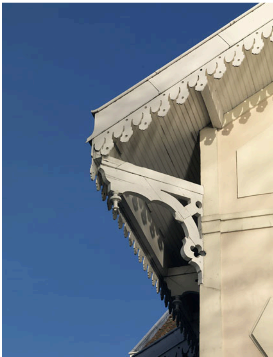
Détail de l'angle du toit.
