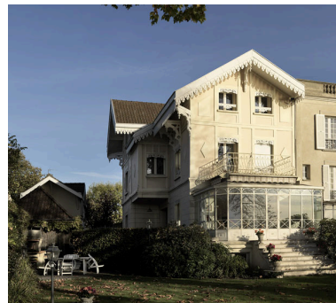
Vue d'ensemble de la façade donnant sur le lac. Phot. Jean-Bernard Vialles IVR11_20089500569NUC4A
