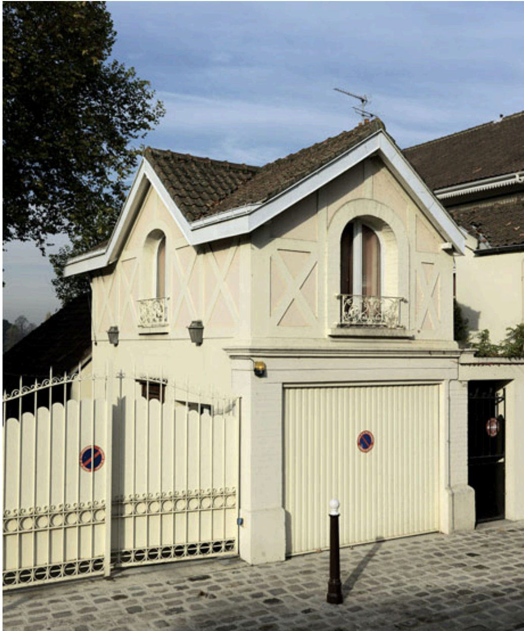
Vue des communs depuis la rue.
