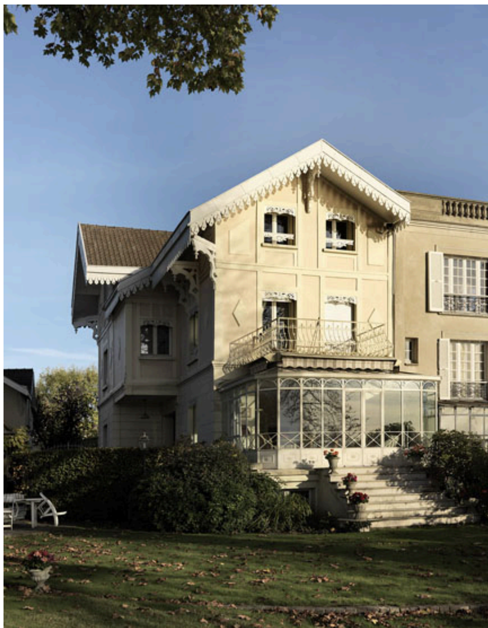
Vue d'ensemble de la façade donnant sur le lac.
