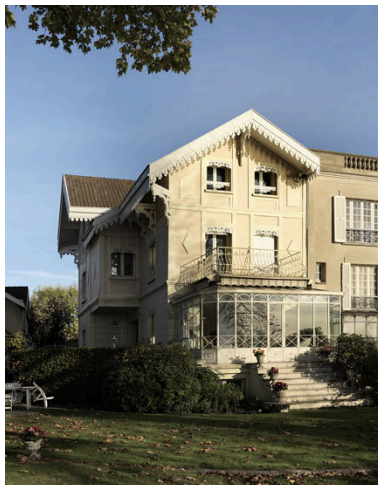
Vue d'ensemble de la façade donnant sur le lac. Phot. Jean-Bernard Vialles IVR11_20089500570NUC4A
