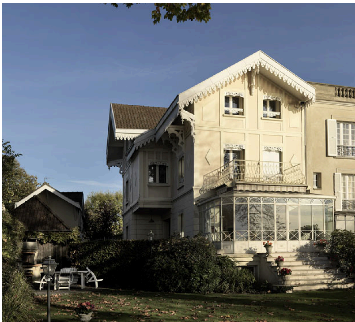
Vue d'ensemble de la façade donnant sur le lac.
