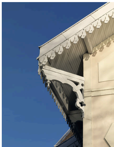
Détail de l'angle du toit. Phot. Jean-Bernard Vialles IVR11_20089500571NUC4A
