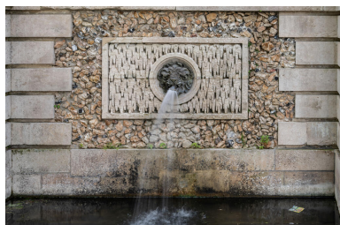
Sur le soubassement, détail sculpté du déversoir. Phot. Kruszyk Laurent IVR11_20249500070NUC4A
