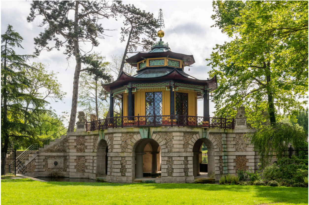
Vue de face, côté déversoir.
