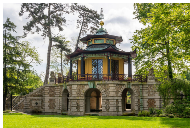
Vue de face, côté déversoir. Phot. Kruszyk Laurent IVR11_20249500062NUC4A
