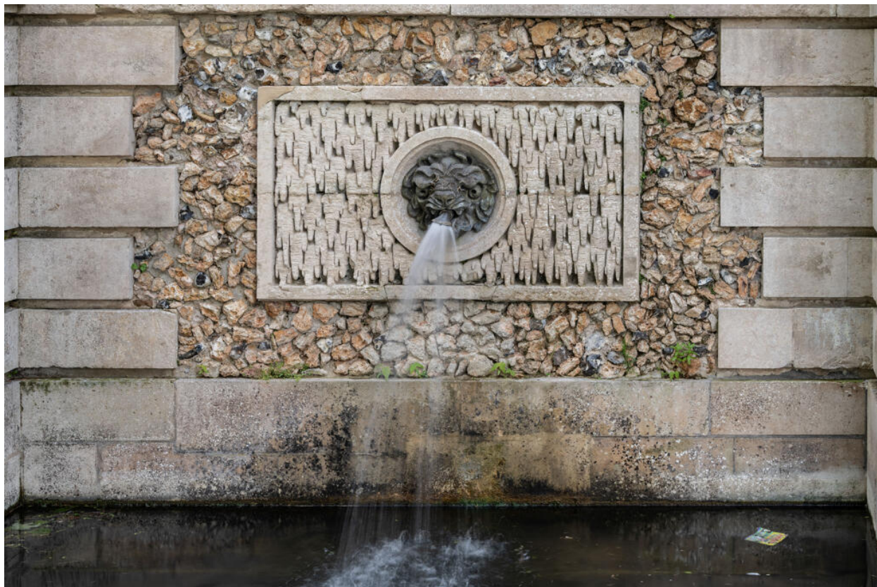
Sur le soubassement, détail sculpté du déversoir.
