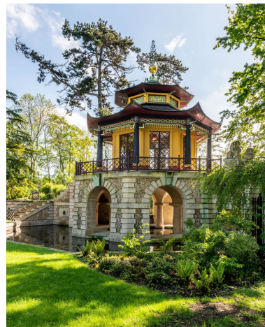
Vue de trois quarts, du côté déversoir. Phot. Kruszyk Laurent IVR11_20249500064NUC4A
