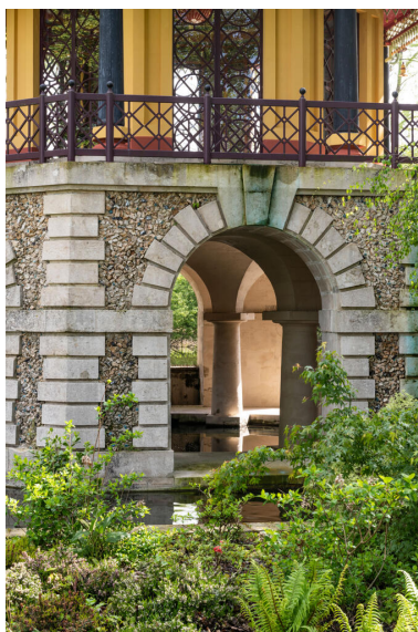
Le soubassement du pavillon abrite un déversoir devant servir de trop plein aux étangs du parc. Phot. Kruszyk Laurent IVR11_20249500067NUC4A
