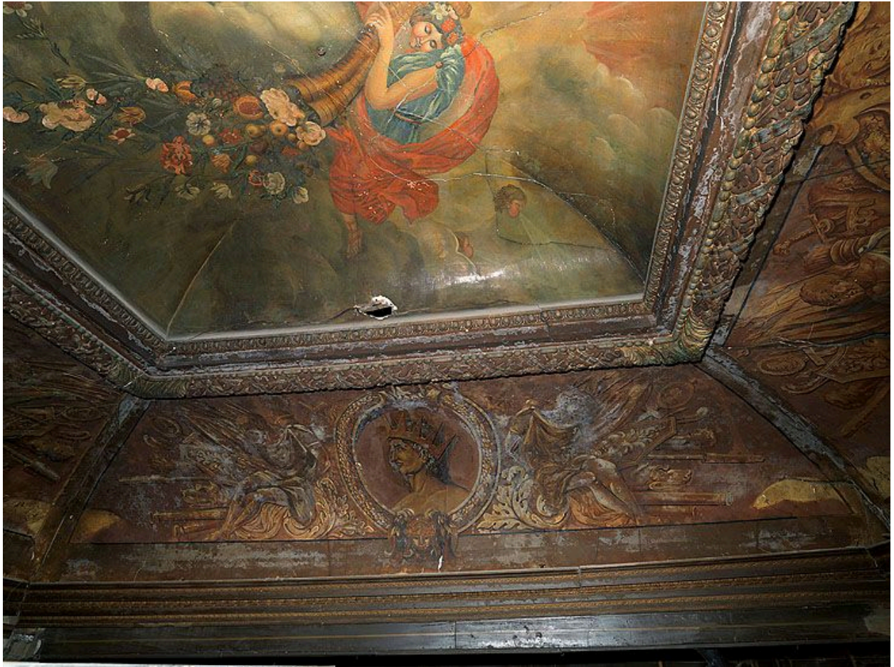
Le plafond peint : détail de la partie ouest.
