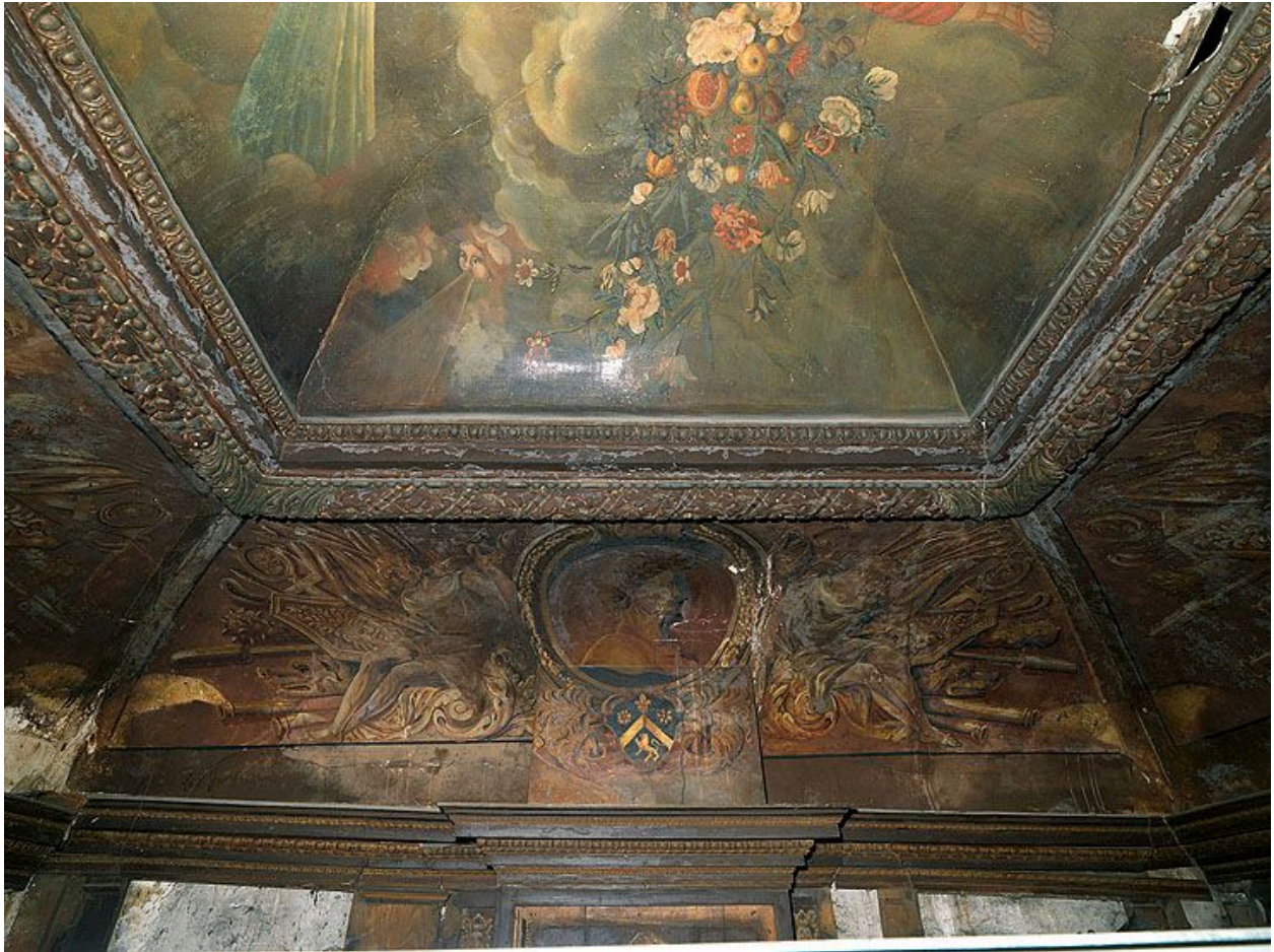
Le plafond peint : détail de la partie sud, avec les armoiries du commanditaire.
