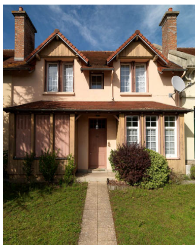
Rue de la Libération. Logements locatifs sur deux niveaux construits en 1912-1913. Décrochement des toits, tuiles plates, avancées.
