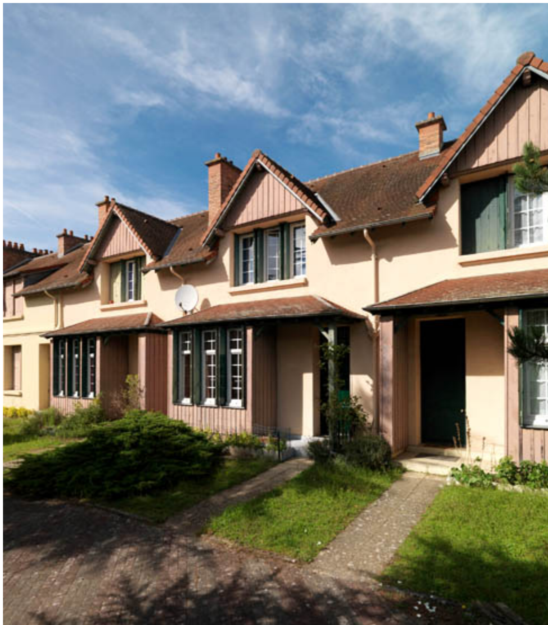
Rue de la Libération. Logements locatifs sur deux niveaux construits en 1912-1913. Décrochement des toits, tuiles plates, avancées, pignon bardés de bois.
