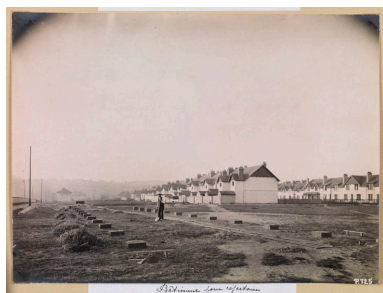
Photo ancienne de la construction du lotissement. IVR11_20117700314NUC4A
