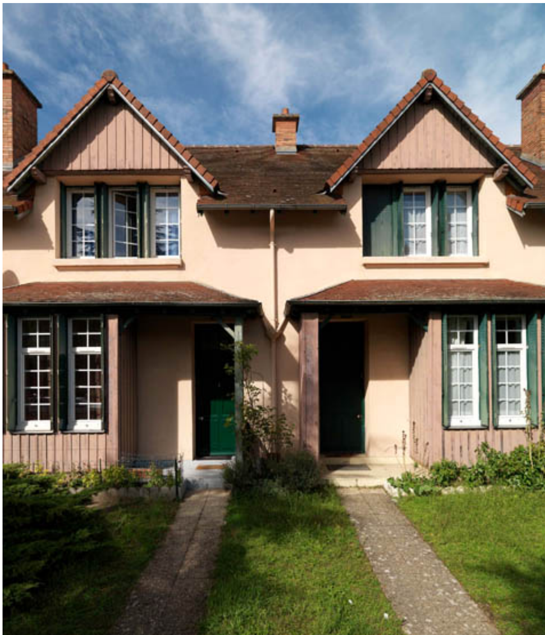
Rue de la Libération. Logements locatifs sur deux niveaux construits en 1912-1913. Décrochement des toits, tuiles plates, avancées, pignon bardés de bois.
