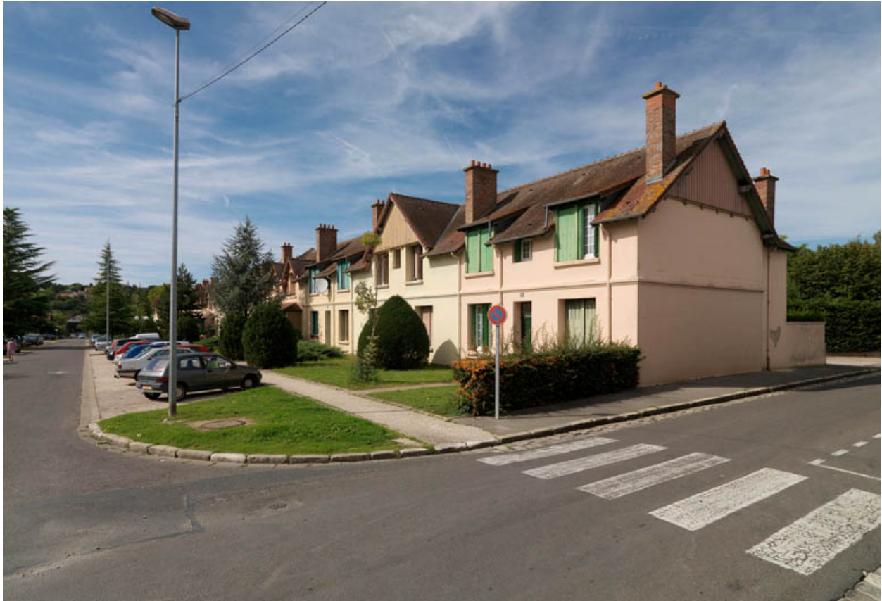
Logements locatifs sur deux niveaux construits en 1912-1913 réhabilités en 1984 par l'office HLM.
