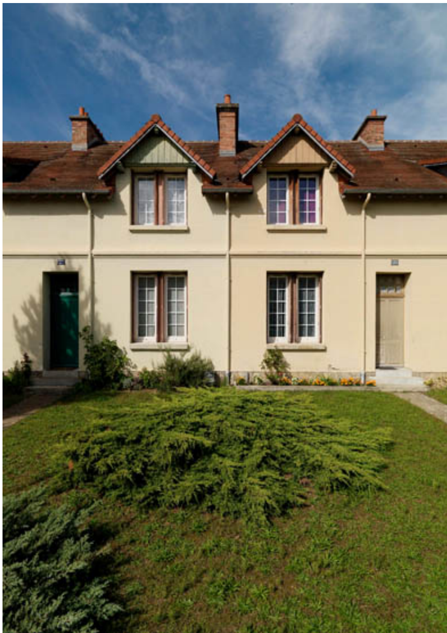
Rue de la Libération. Logements locatifs sur deux niveaux construits en 1912-1913.
