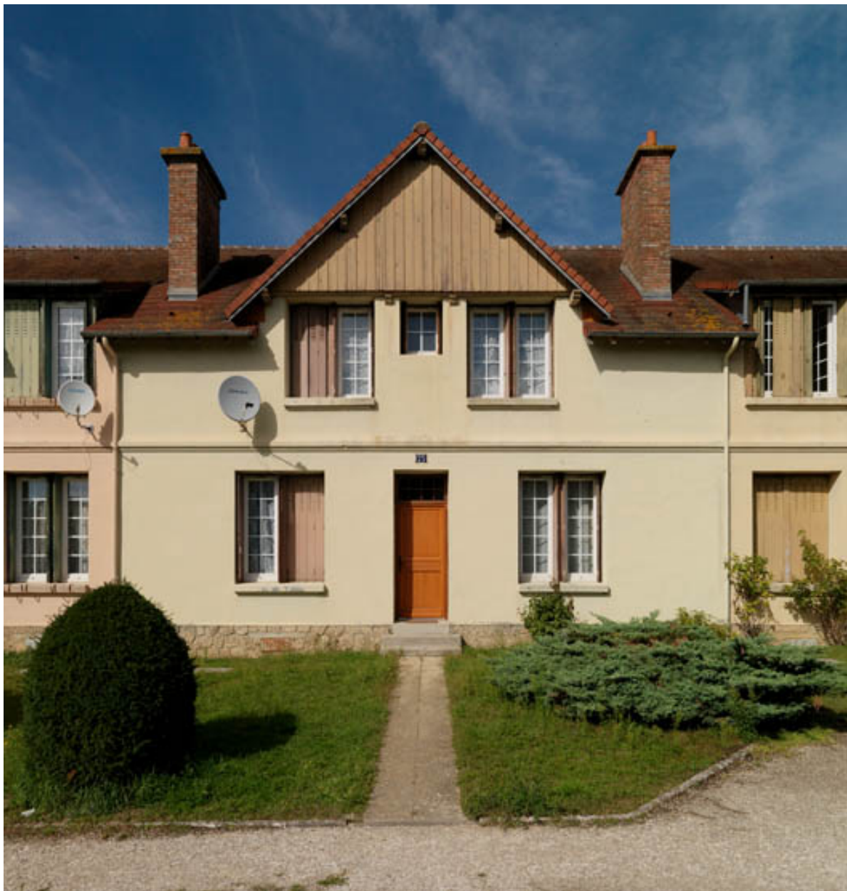
Rue de la Libération. Logements locatifs sur deux niveaux construits en 1912-1913. Décrochement des toits, tuiles plates pignon bardés de bois.
