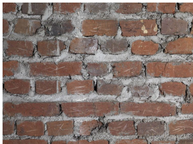
Vue rapprochée d'un mur avec graffiti et griffures sur brique. Phot. Jean-Bernard Vialles IVR11_20109300081NUC4A
