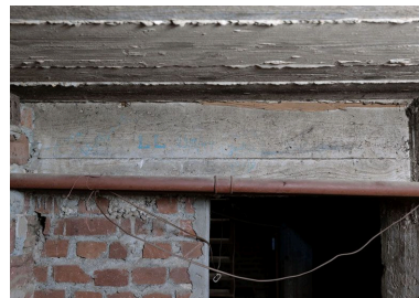
Série de graffiti sur structure béton de la cave. Phot. Jean-Bernard Vialles IVR11_20109300075NUC4A
