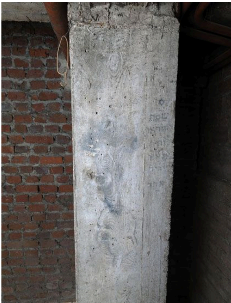
Vue générale de graffiti sur structure béton dans la première cave prison.
