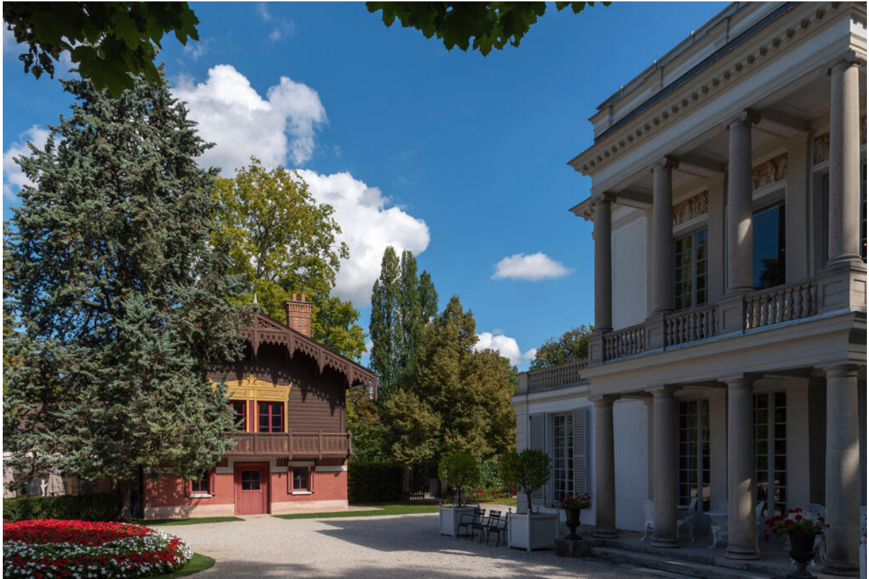
La maison au premier plan, et sa façade sur jardin aux portiques superposés. Au fond, le chalet suisse.
