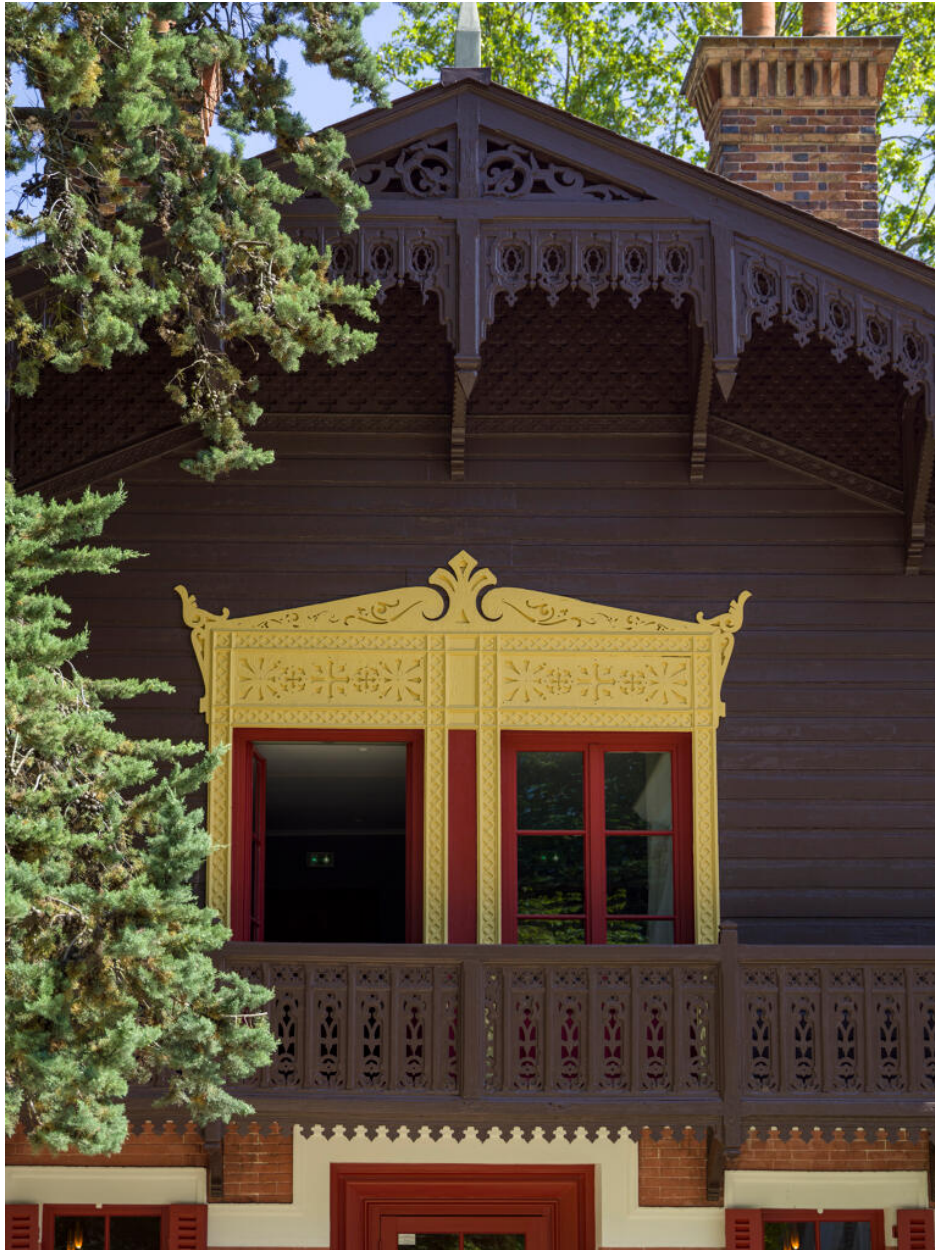
Détail de l'étage du chalet suisse avec ses décors en bois découpé sur le toit, le garde-corps et les encadrements de fenêtres.
