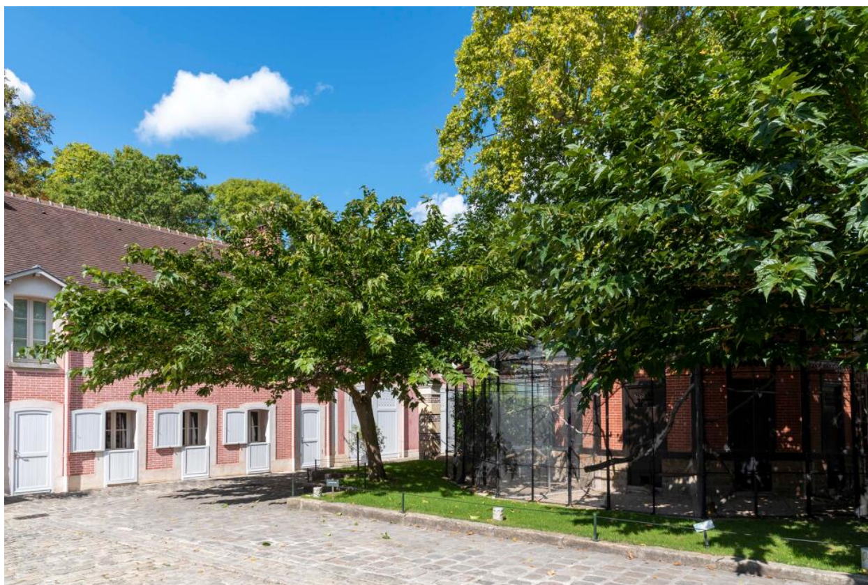
La Ferme ornée aux murs en fausse brique, au milieu de laquelle est installée la volière.
